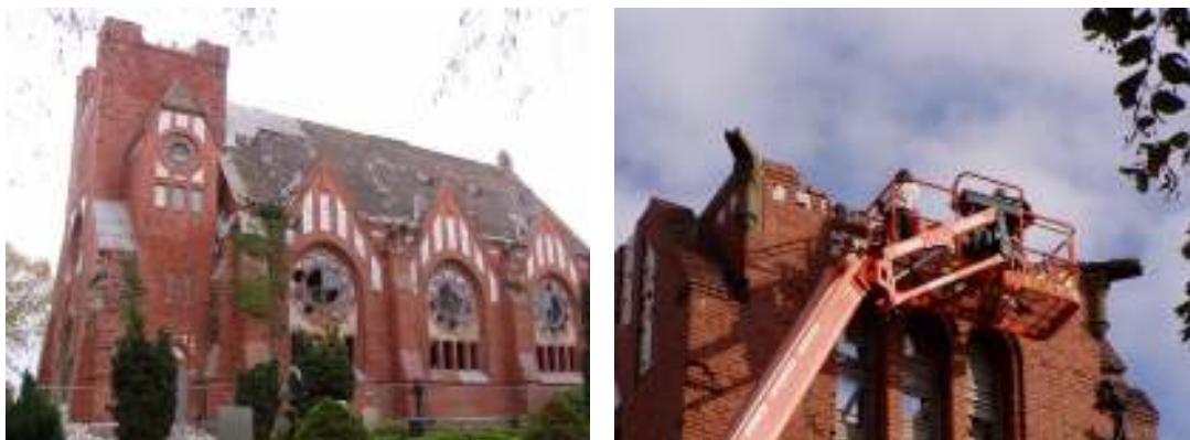
Tornets spira är borttagen och tornet rivs först ned för hand till lagom höjd för rivningsmaskinen. Bilden till vänster visar också att takskiffret till största delen är nedblockat. Foto: Regionmuseet 2007-10-26 resp 2007-09-26.
