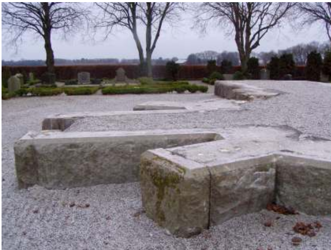
Kyrkans grundstenar har lämnats kvar som planerat när rivningen avslutats. Här platsen för koret. Foto: Regionmuseet 2007-12-19.
