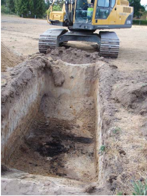
Fig 5: Schakt IIa, torven börjar synas i djupschaktet. Foto Helene Wilhelmson.
