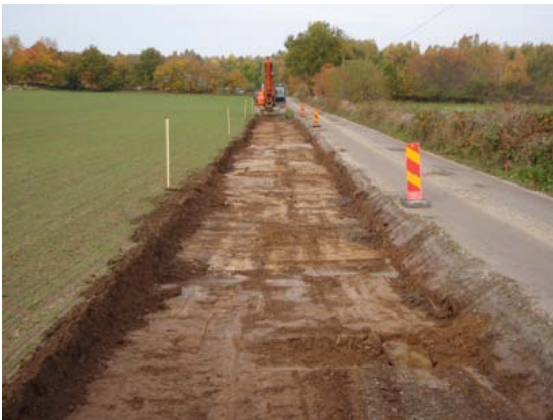
Fig. 3. Besiktning av pågående schaktning i norra kanten av RAÄ 75. Foto åt väster, Tony Björk.
