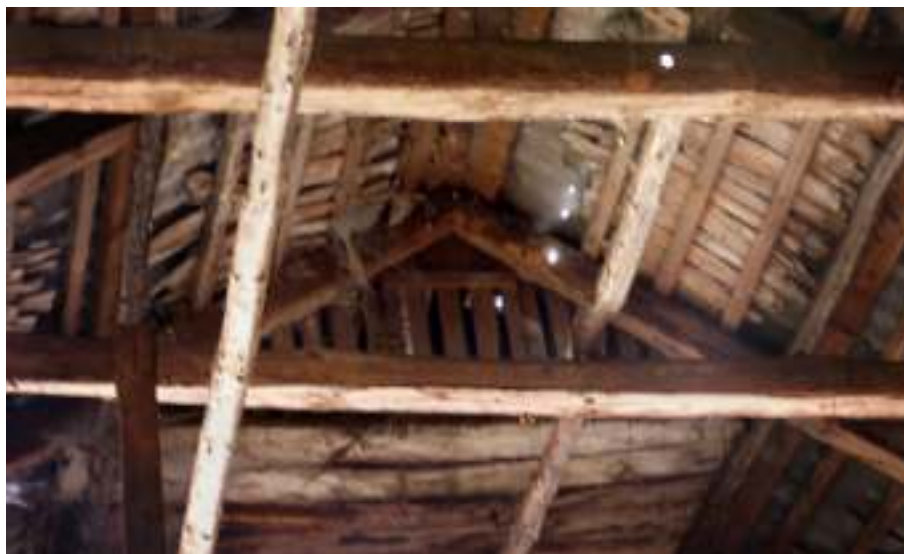
Ett bra exempel på hur man kan erbjuda busrum åt fåglar utan att de kan skräpa ner alltför mycket i byggnaden. Boet är hopsnickrat invändigt i ladan med ingång från utsidan, högst upp på gaveln.
