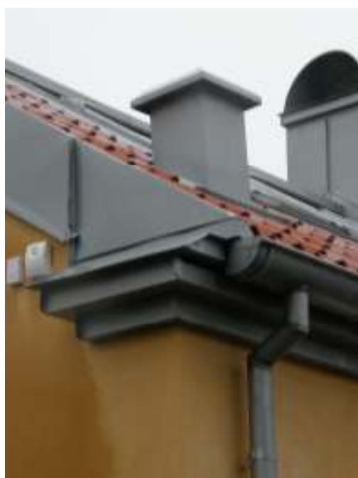
Bilder: Nybyggd flygelbyggnad med detaljer i reinzink.
