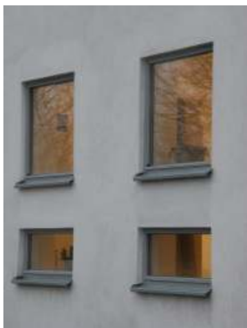
Bilder: Nybyggd flygelbyggnad med detaljer i reinzink.
