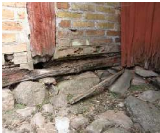
Vänster bild: Rötskadad syll och stolpe på loglängan. Höger bild: Syll och stolpe efter lagning men innan fogning.
