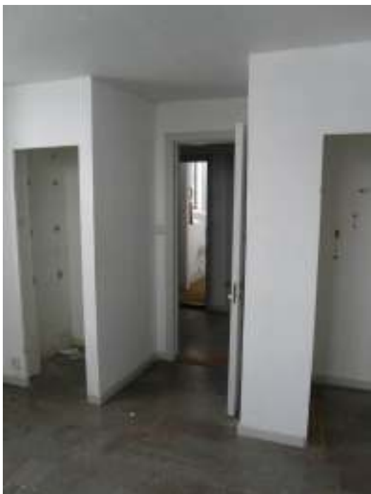
För att få ett mer verksamhetsanpassat entrérum med möjlighet till enklare servering skapades en öppen planlösning genom att riva en vägg och ett par skåpsinbyggnader.
