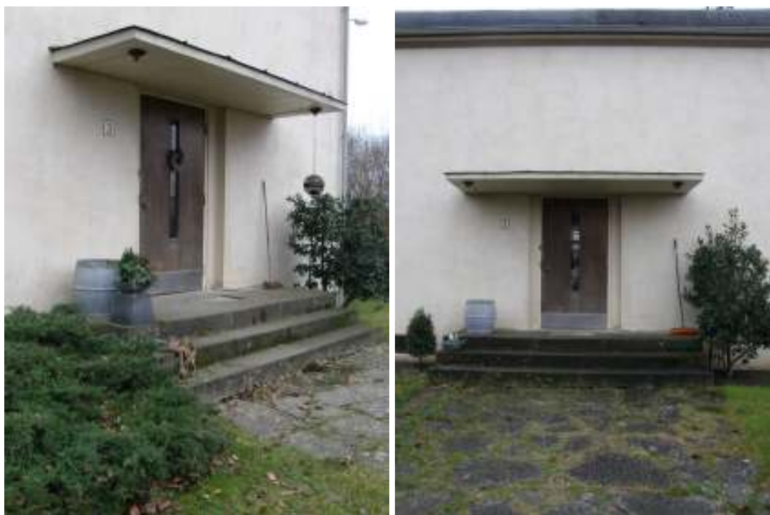
Entrén före restaureringen och till höger efter. Trädgårdsenen och tujan har ersatts med gräs och en ny järnek.
