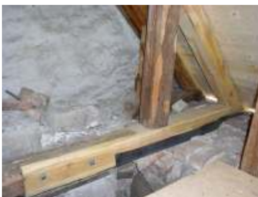
Tv. Reparerad bjälke och sparre i långhusets sydöstra taklag. Th. Långhusets undertak byts ut.
