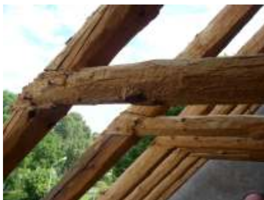
Tv. Lagning av långhusets södra taklag. Byte av stickbjälke och lagning av sparre. Mellan murverk och nytt virke lades papp. Th. Korets sydliga taklag blottat i samband med byte av undertak. Detalj av anslutning mellan banband och sparre.
