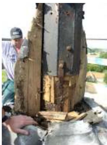
Tv. Tornspirans krön efter avtäckning av plåt. Pappen vittnar om att krönet blivit reparerat tidigare, troligen i samband med ommålningen 1990. Mitten: Krönkorsets infästning före. Th. Krönkorsets nya infästning med bottenplatta och beslag.
