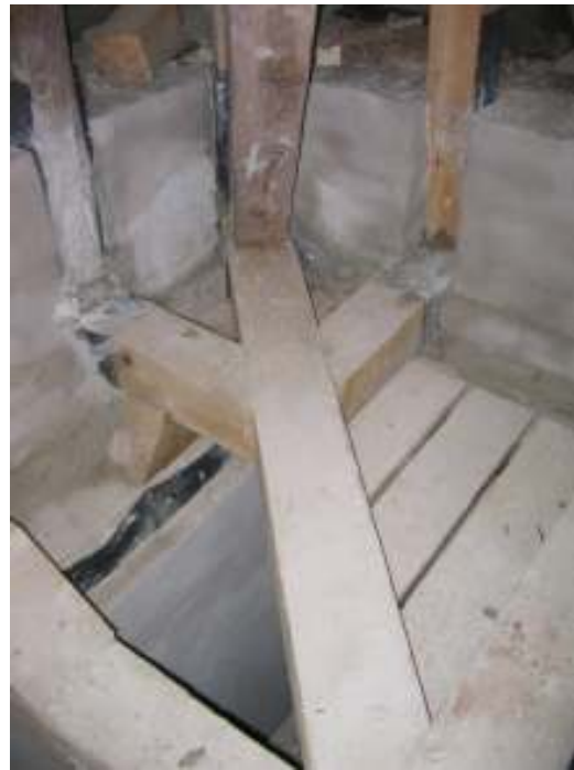
Reparation av tornets nedre taklag. Lägg märke till rötskadad stolpe till höger i bild. Th. Tornspirans nedre bjälklag efter byte. Anslutande tegelmurverk är återställt och putsat.
