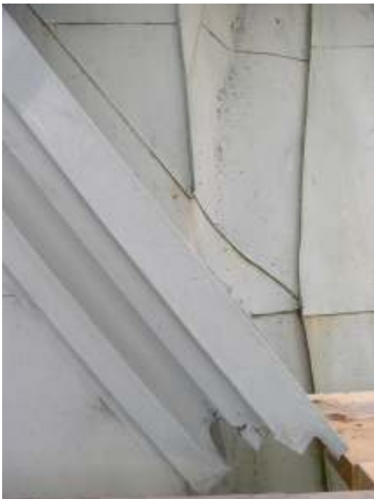
Tv. Listverk på tornkupa före. Tb. Tornbuvens nedre takfall före.
