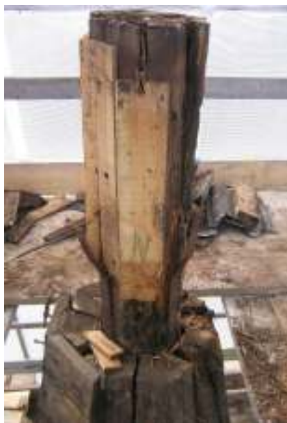
Tornspirans topp med omfattande rötskador både i hjärtstolpe och kröndecor.
