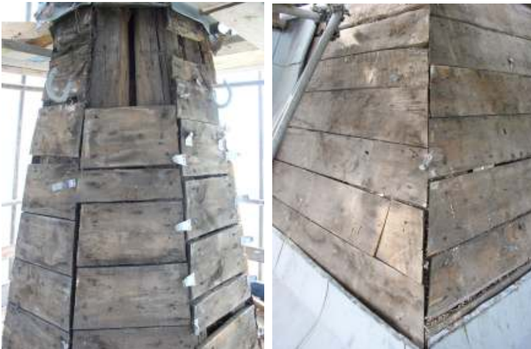
Tornspirans undertak före byte.
