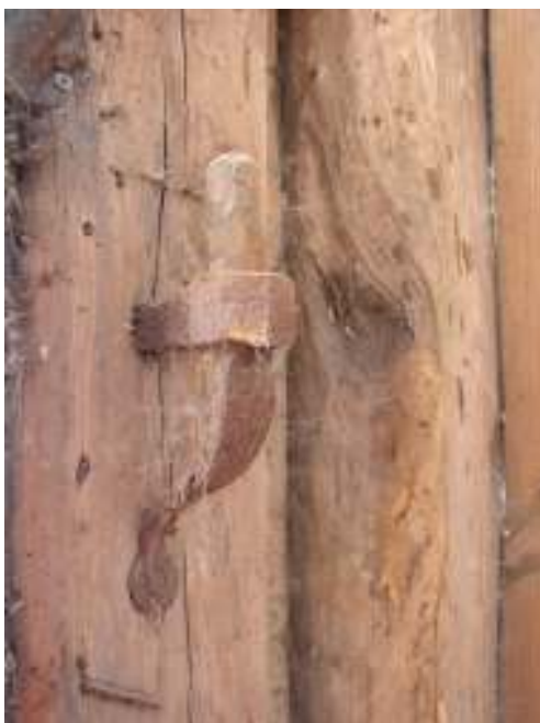
Gångjärn för luckorna i tornhuvens kupor.
