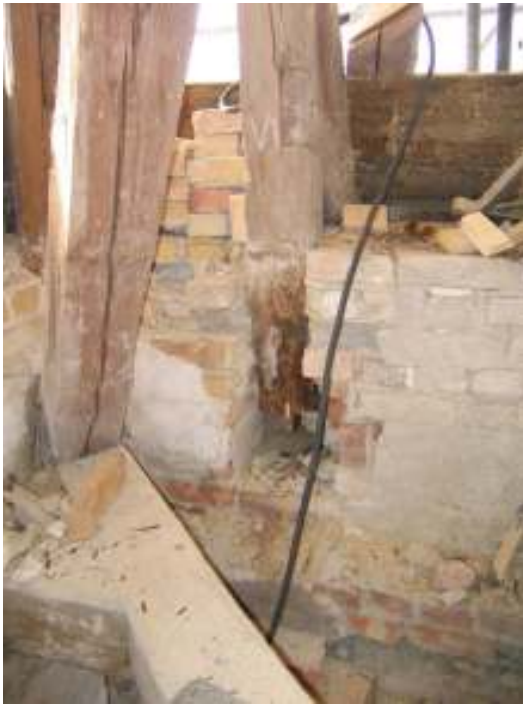
Reparation av tornets nedre taklag. Lägg märke till rötskadad stolpe till höger i bild. Th. Tornspirans nedre bjälklag efter byte. Anslutande tegelmurverk är återställt och putsat.
