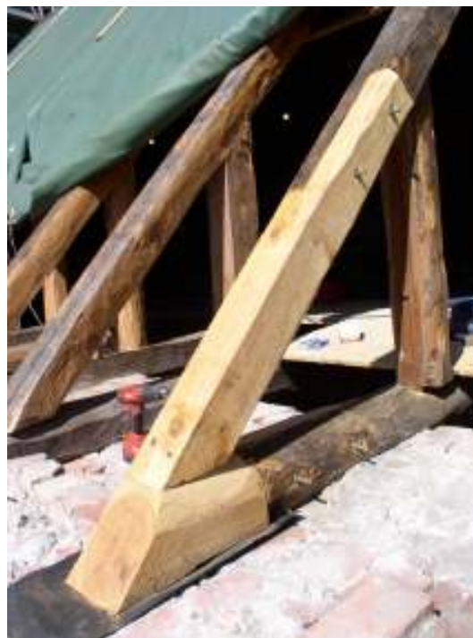
Tv. Långhusets södra takfall under pågående reparation av rötskador i taklag. Th. Lagad takstol med iskarvad sparre och stickbjälke.
