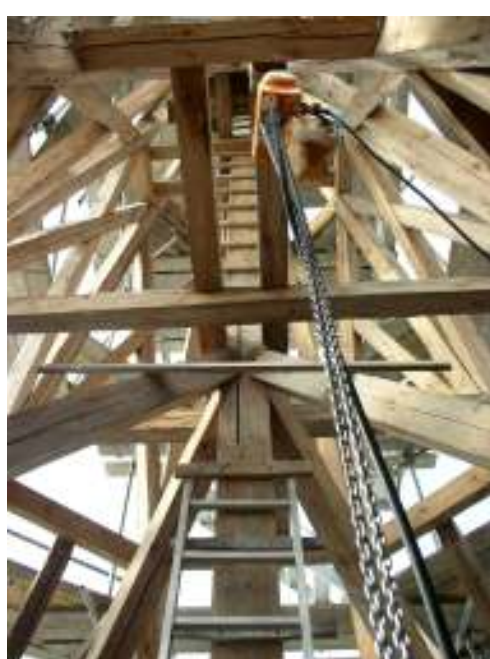
Törntaklaget i samband med byte av undertak. Ett gediget trähantverk från 1870 att beundra.
