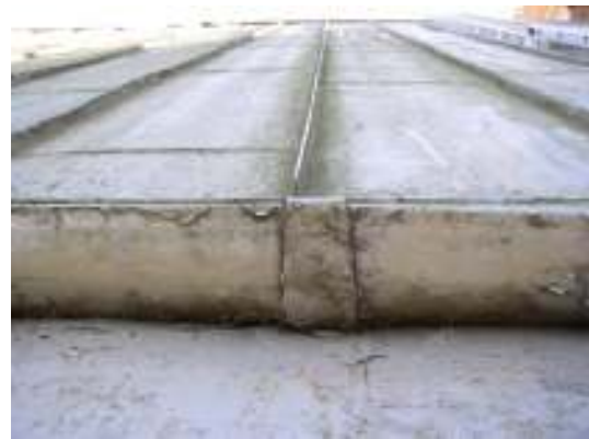
Tr. Vattkupa och anslutande fotränna. Th. Fotränna med rännkrok av dubbelvikt plåt.
