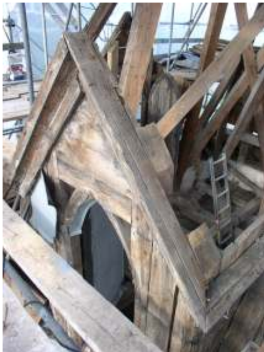
Tv. Tornkupa med krönlist före byte. Th. Tornkupa med plåtklädd dörr sedd från tornvinden före reparation.
