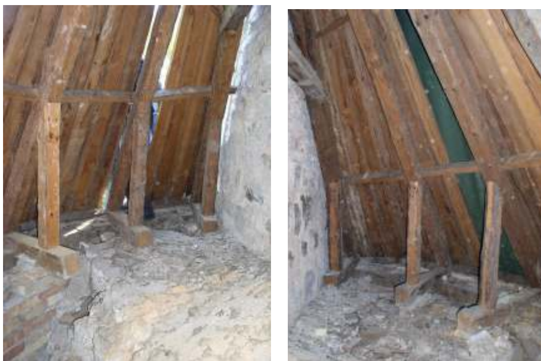
Absidens taklag och undertak före byte åt syd respektive nord.
