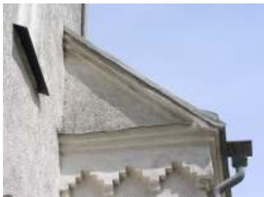
Tv. Långhusets sydvästra gavel med hängskiva och listplåt före. Th. Övergång mellan kor och långhus i söder före.
