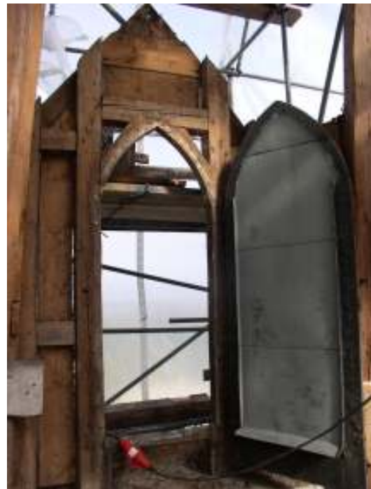
Tv. Tornkupa med krönlist före byte. Th. Tornkupa med plåtklädd dörr sedd från tornvinden före reparation.
