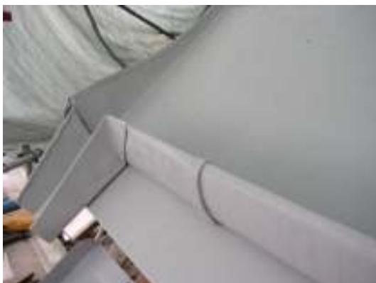
Tv. Ny fotränna, hängskiva på långhusets nordsida. Th. Detalj av långhusets västra listavtäckning efter byte. Pustanslutning ej färdigställd.
