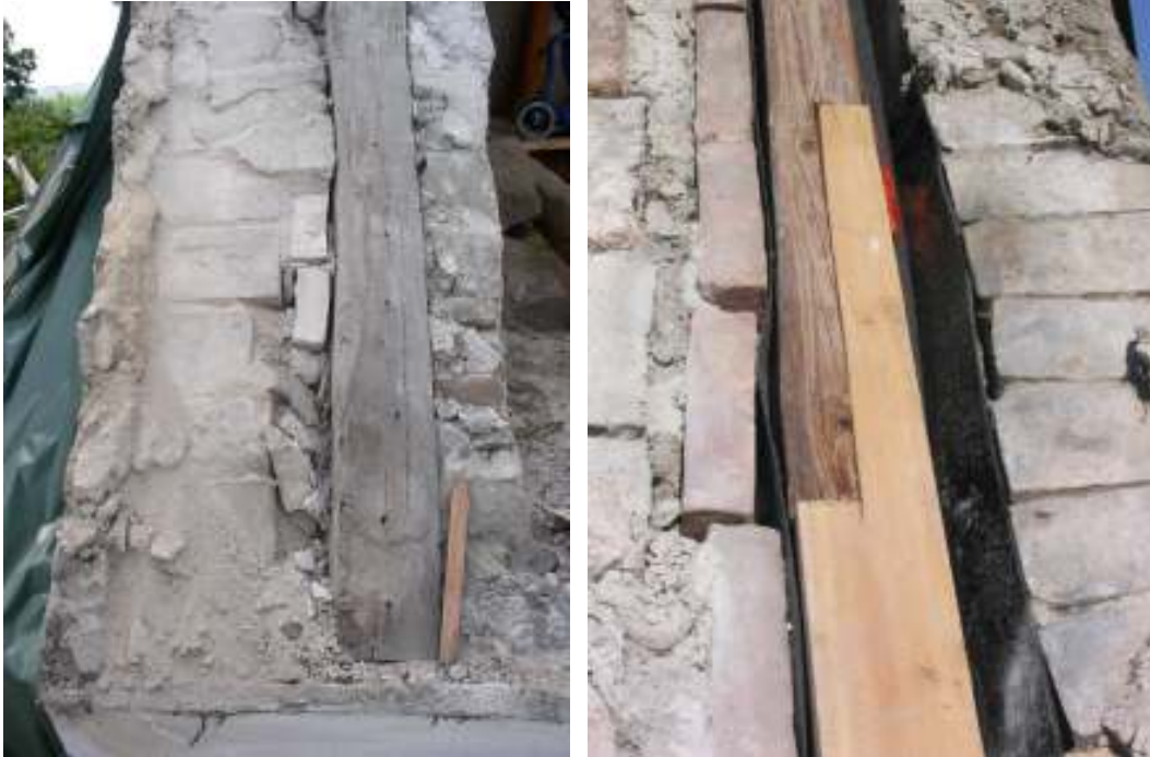
Tv. Korets norra sida med inmurad sparre österut som undgick reparation. Th. Motsvarande sparre i söder efter lagning.
