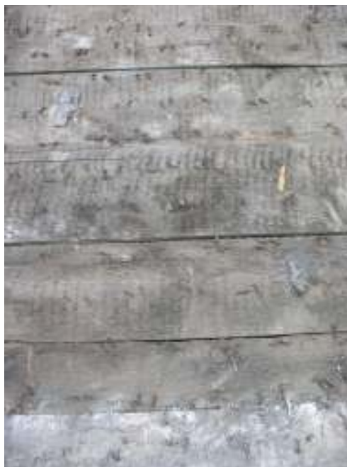
Långhusets undertak, ramsågad brädpanel med massor av spik efter tidigare skeffertäckning
