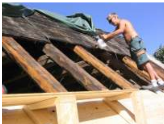
Tv. Reparerad bjälke och sparre i långhusets sydöstra taklag. Th. Långhusets undertak byts ut.
