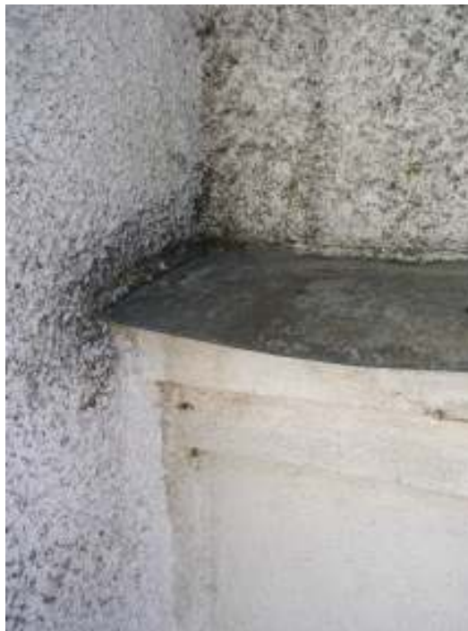
Tv. Plåtläggning pågår på långhusets sydsida. Th. Detalj av långhusets västra listavtäckning före byte.
