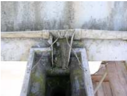
Tr. Vattkupa och anslutande fotränna. Th. Fotränna med rännkrok av dubbelvikt plåt.
