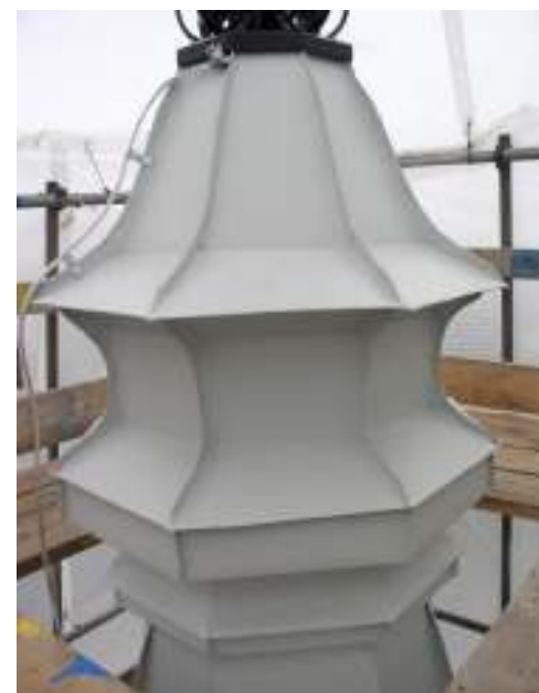
Tornspirans krön efter omläggning.
