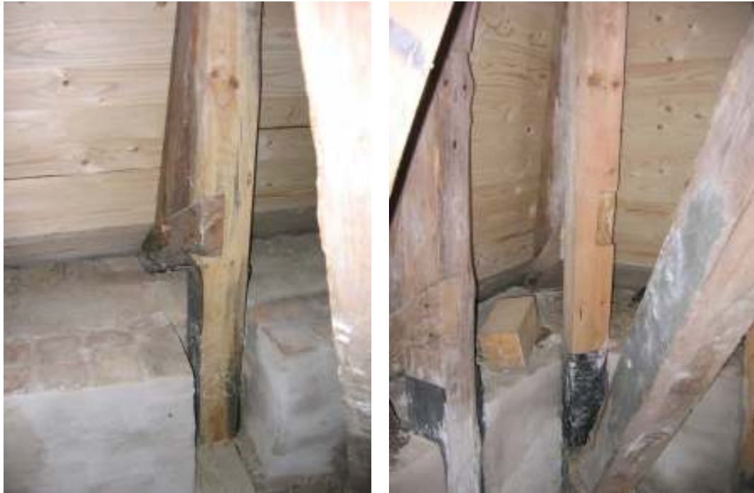
Tornspirans nedre taklag efter lagning. Anslutande tegelmurverk är återställt och putsat.
