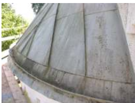
Tv. Takfot långhusets södra sida före. Th. Absidetakets nedre del och fotränna från nord före.
