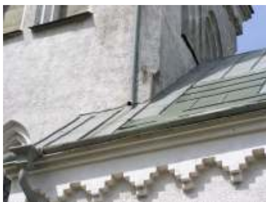
Tv. Tornspiran från söder före restaurering. Th. Långhustakets sydvästra del före. Den omlagda delen är en temporär täckning utförd i samband med besiktning av tak och taklag inför restaureringen.
