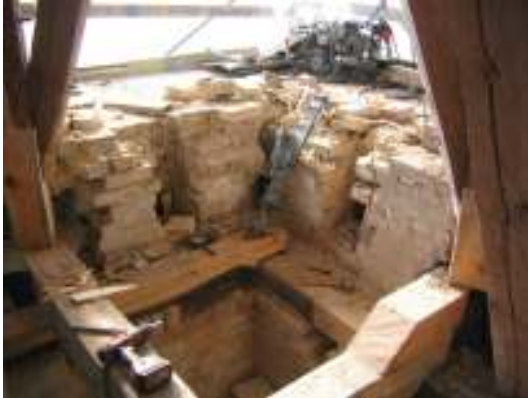
Tornets sydvästra hörn invändigt respektive utvändigt efter att rötskadade stolpar avlägsnats ur murverket.
