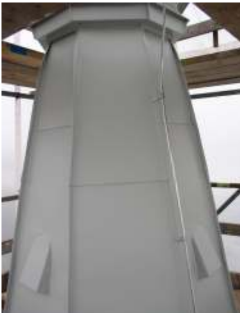
Tornspira med luftning efter omläggning.
