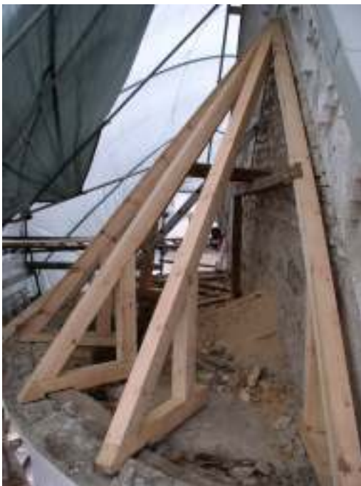
Absidens taklag och undertak efter byte.
