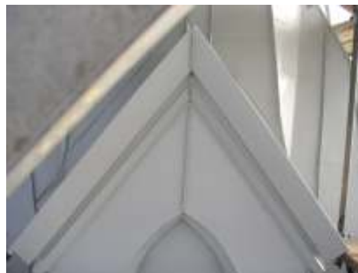
Tv. Ny fotränna, hängskiva på långhusets nordsida. Th. Detalj av långhusets västra listavtäckning efter byte. Pustanslutning ej färdigställd.
