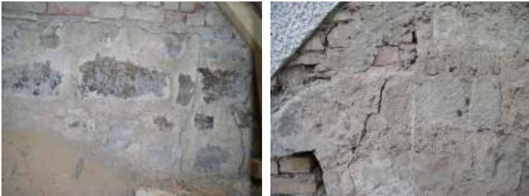
Tv. Apsidvindens murverk norrut. Th. Detalj av uppbruten del i söder, där sandstensmurverk möter tegelmurverk i en oregelbunden övergång.
