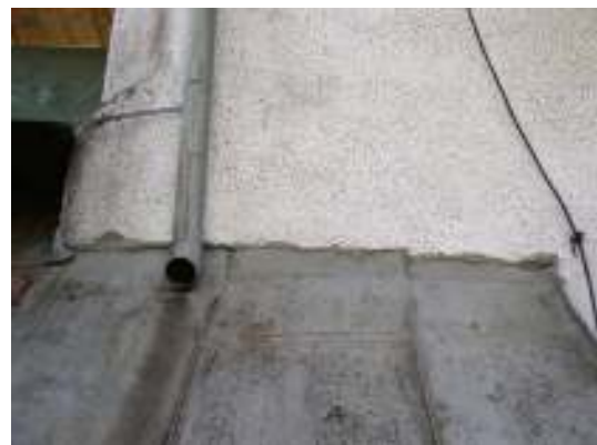
Tr. Hängskiva på långhusets nordöstra gavel. Th. Ståndskiva utmed tornets norra fasad.
