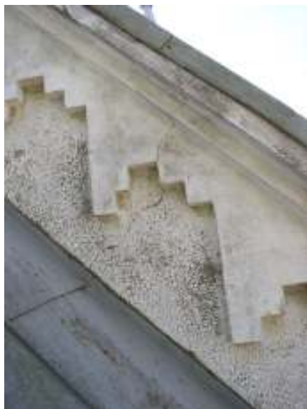
Tv. Korets östra gavel norrut. Absiden ansluter till gavelväggen med en nätt ståndskeiva. Sprickan som löper över väggen syntes även inifrån och är en äldre sättningskada. Th. Absidataket norrut före omläggning.
