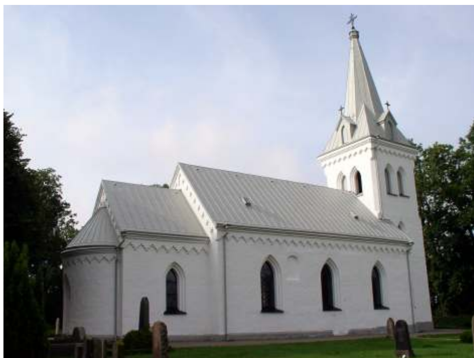
Stångby kyrka efter renovering 2005-2006. Fasad åt norr.
