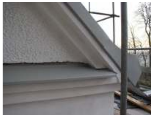
Tv. Ny fotränna, hängskiva på långhusets nordsida. Th. Detalj av långhusets västra listavtäckning efter byte. Pustanslutning ej färdigställd.
