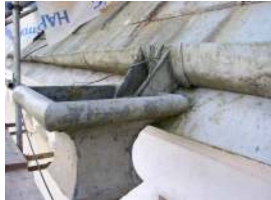
Tr. Hängskiva och listantäckning på långhusets nordvästra gavelparti. Th. Vattkupa och anslutande bängränna.
