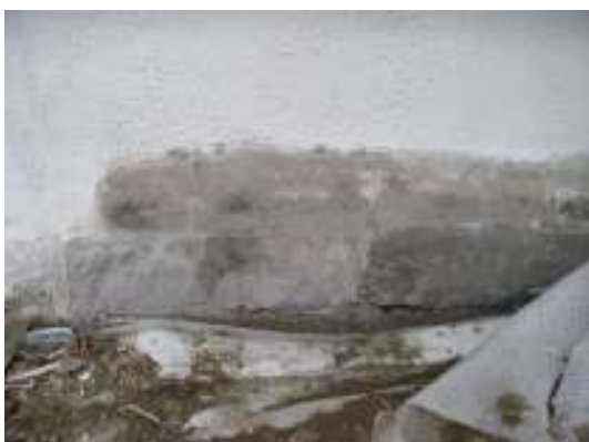
Tv. Provblästrad sockel av Höörsandsten utmed långhusets nordvästra del. Th. Överdelen av tornspirans hjärtstolpe med inristat namn, tillvaratogs av församlingen.
