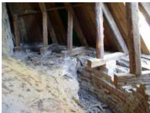
Tv. Absidmurens östra krön, ommurat i samband med att östdörren togs upp. Th. Absidevinden norrut med uppbrutet absidvalv till höger i bild.
