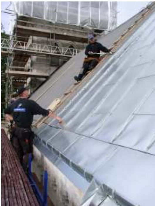
Tv. Plåtläggning pågår på långhusets sydsida. Th. Detalj av långhusets västra listavtäckning före byte.
