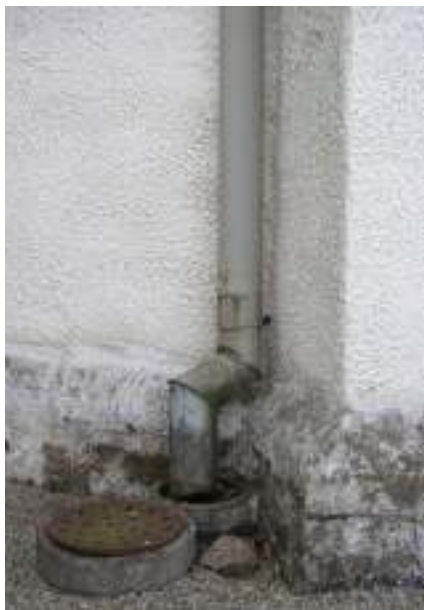
Tv. Anslutning av vattkypor mellan kor och absid på södra norra sidan före byte. Notera även absidens nätta takfot och svagt rundade fotränna. Th. Stuprörskastare på absidens norra sida före.
