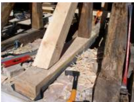
Tv. Lagning av långhusets södra taklag. Byte av stickbjälke och lagning av sparre. Mellan murverk och nytt virke lades papp. Th. Korets sydliga taklag blottat i samband med byte av undertak. Detalj av anslutning mellan banband och sparre.
