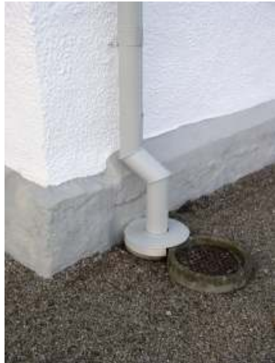
Avslutning stuprör. Sockeln är målats grå.
