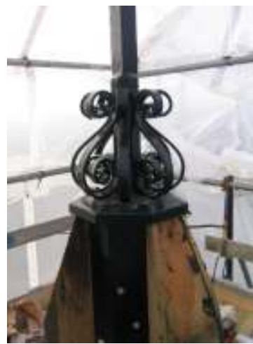
Tv. Tornspirans krön efter avtäckning av plåt. Pappen vittnar om att krönet blivit reparerat tidigare, troligen i samband med ommålningen 1990. Mitten: Krönkorsets infästning före. Th. Krönkorsets nya infästning med bottenplatta och beslag.
