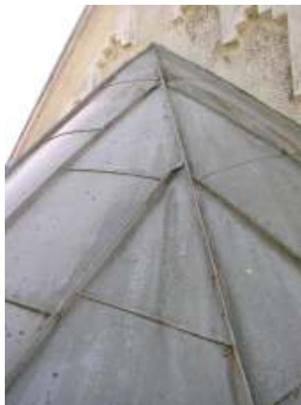
Tv. Korets östra gavel norrut. Absiden ansluter till gavelväggen med en nätt ståndskeiva. Sprickan som löper över väggen syntes även inifrån och är en äldre sättningskada. Th. Absidataket norrut före omläggning.
