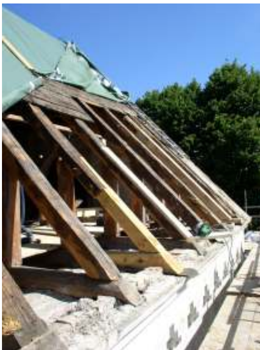
Tv. Långhusets södra takfall under pågående reparation av rötskador i taklag. Th. Lagad takstol med iskarvad sparre och stickbjälke.
