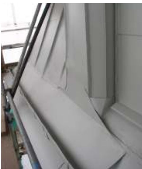
Tornhuvens nedre takfall med ny plåtavtäckning.
