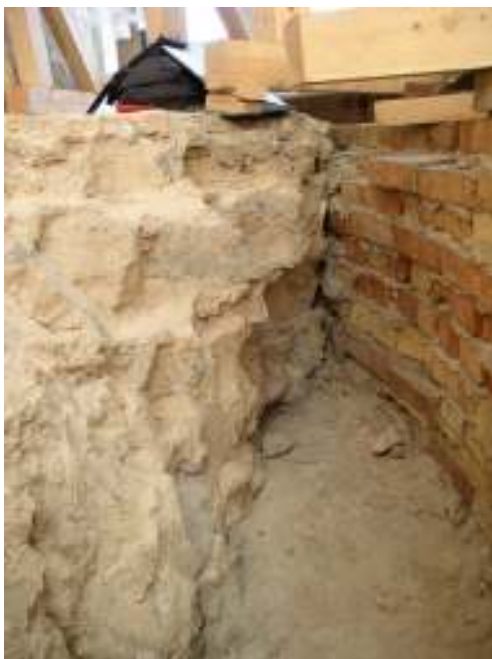
Detalj av uppbyggning i absidens valv. Här syns antryck i fyllningen efter bortplockade stenar.
