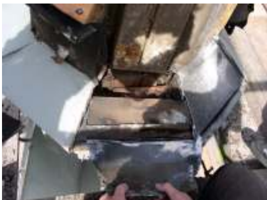
Tv. På tornspirans plåtantäckta krön upptäcktes en äldre bevarad zinkplåt under befintlig galvad plåtantäckning. Th. Absidens taklagstopp före byte.
