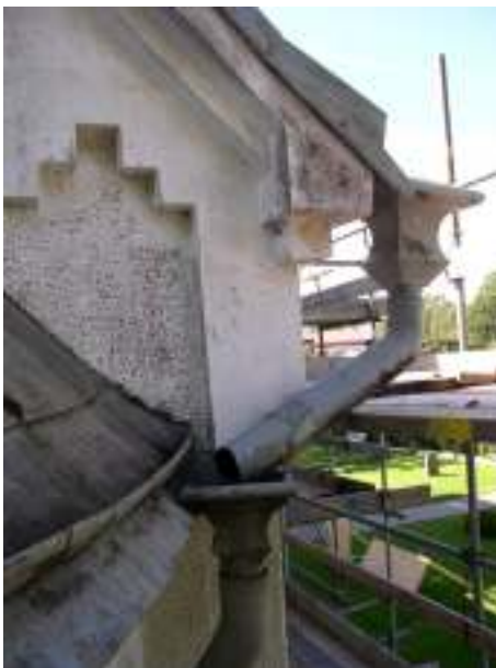
Tv. Anslutning av vattkypor mellan kor och absid på södra norra sidan före byte. Notera även absidens nätta takfot och svagt rundade fotränna. Th. Stuprörskastare på absidens norra sida före.
