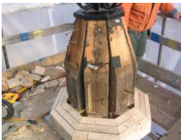
Tornspirans topp med omfattande rötskador både i hjärtstolpe och kröndecor.
