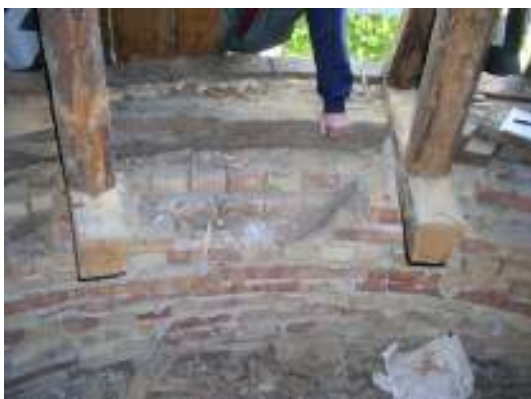
Tv. Absidmurens östra krön, ommurat i samband med att östdörren togs upp. Th. Absidevinden norrut med uppbrutet absidvalv till höger i bild.
