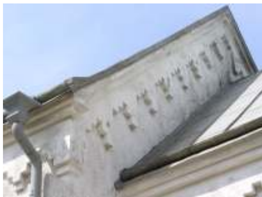
Tv. Långhusets sydvästra gavel med hängskiva och listplåt före. Th. Övergång mellan kor och långhus i söder före.
