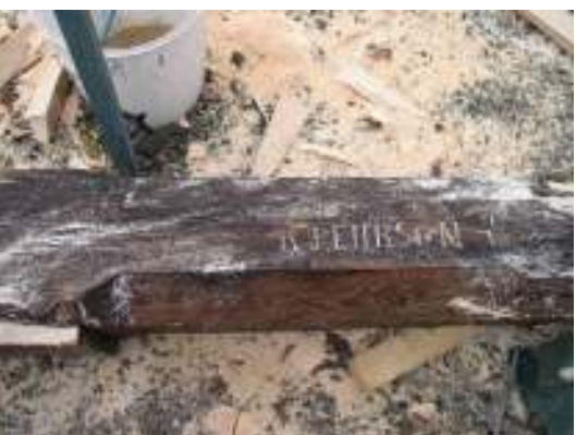
Tv. Provblästrad sockel av Höörsandsten utmed långhusets nordvästra del. Th. Överdelen av tornspirans hjärtstolpe med inristat namn, tillvaratogs av församlingen.
