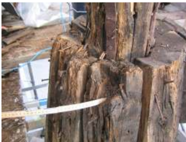
Tornspirans topp med omfattande rötskador både i hjärtstolpe och kröndecor.
