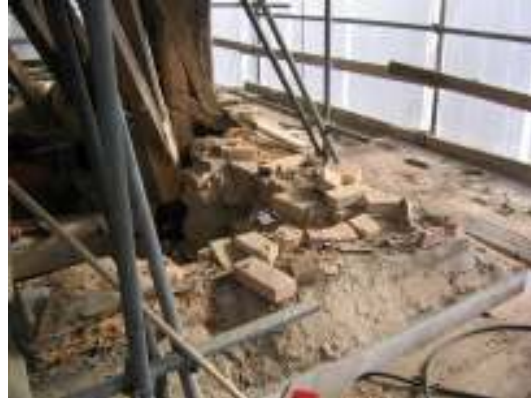
Tornets sydvästra hörn invändigt respektive utvändigt efter att rötskadade stolpar avlägsnats ur murverket.
