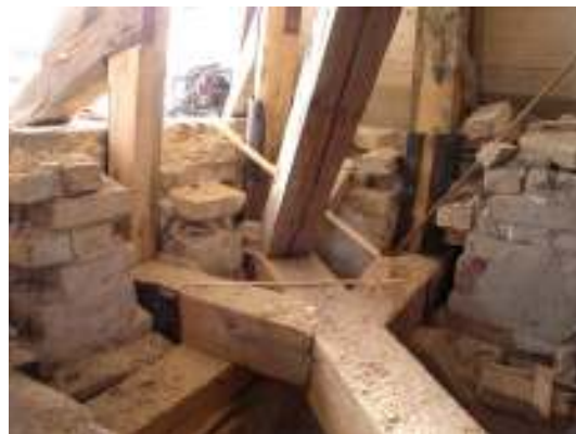
Tornets bjälklag mot murkrön före respektive efter byte.
