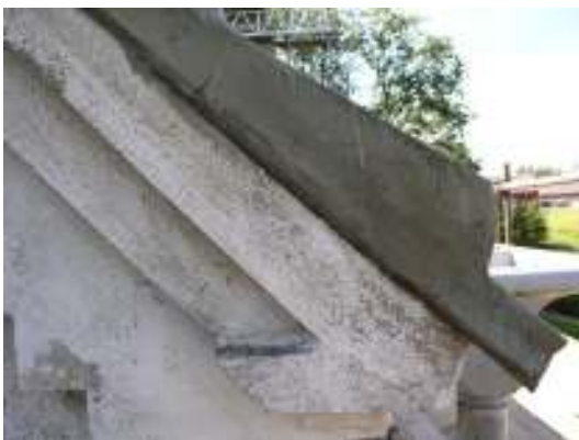
Tr. Hängskiva på långhusets nordöstra gavel. Th. Ståndskiva utmed tornets norra fasad.
