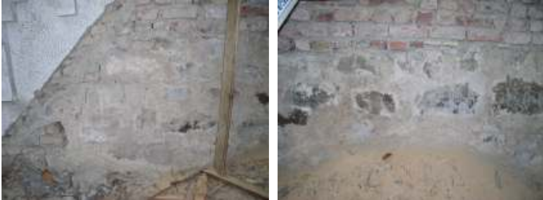
Apsidvindens murverk södra delen tv och mittdelen ovan hjälmvalvets krön th. Notera gränsen mellan sandsten och tegelmurverk
