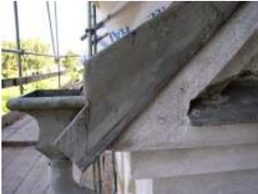
Tr. Hängskiva och listantäckning på långhusets nordvästra gavelparti. Th. Vattkupa och anslutande bängränna.
