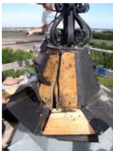
Tv. Tornspirans krön efter avtäckning av plåt. Pappen vittnar om att krönet blivit reparerat tidigare, troligen i samband med ommålningen 1990. Mitten: Krönkorsets infästning före. Th. Krönkorsets nya infästning med bottenplatta och beslag.
