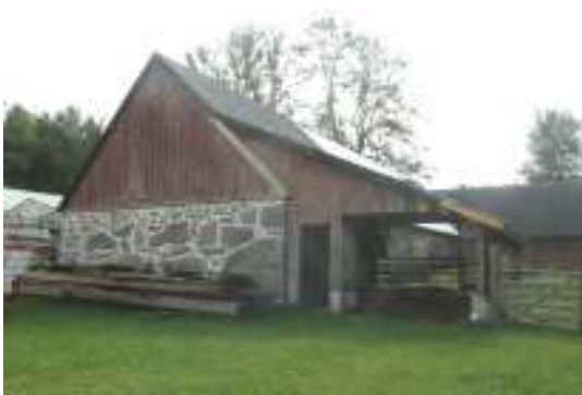
Lagningar på Västra längan/skyddstaket.
