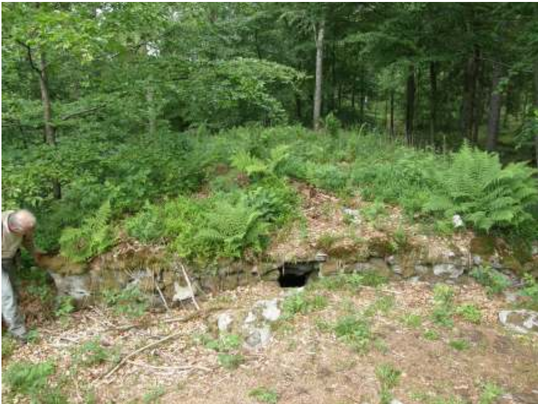
Jordkällaren innan arbetet.
