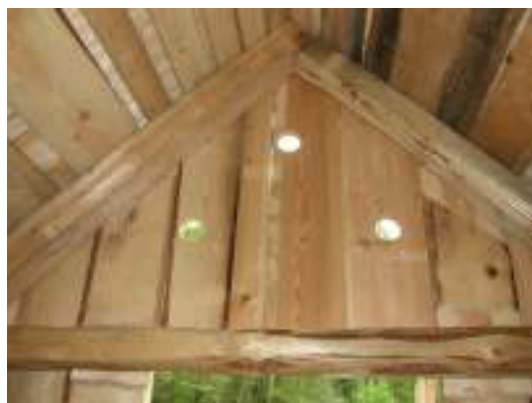
Ventilhålen på östra gaveln.
