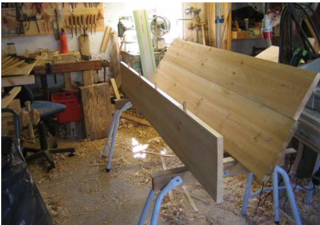
Jordkällarens östra gaveldörr under montering. Foto Olof Andersson.
