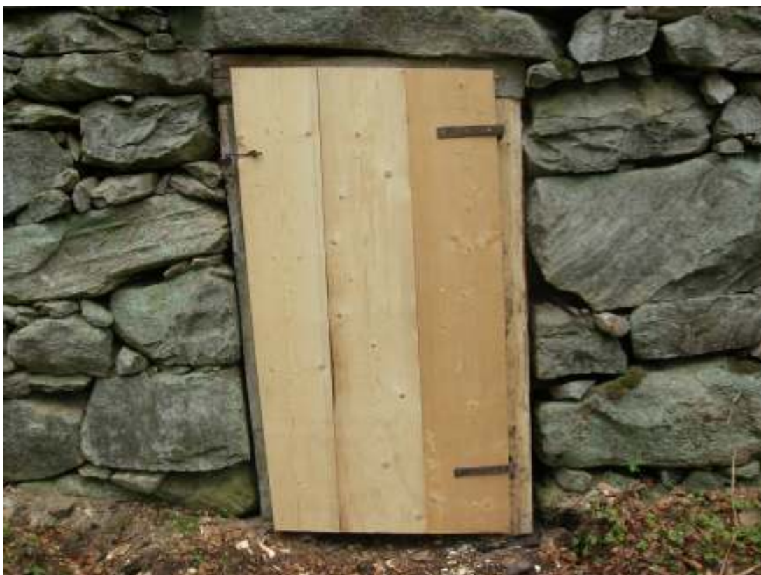
Jordkällarens västra, yttre dörr. Dörrbladets brädor är spontade.
