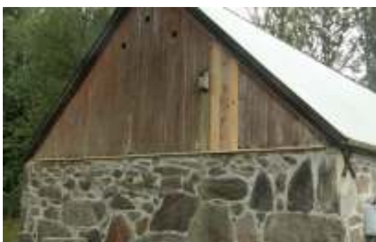
Östra längans norra gavel efter arbetet.
