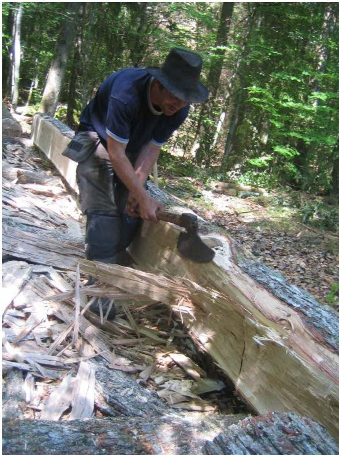
Timmerman Olof Andersson, under arbetet med att bila fram timret till Jordkällaren. Bilden visar tydligt den skånska typen av bilningsteknik; buggningen sker framåt och timmermannen står bredvid stocken. Foto tillhörande Olof Andersson.
