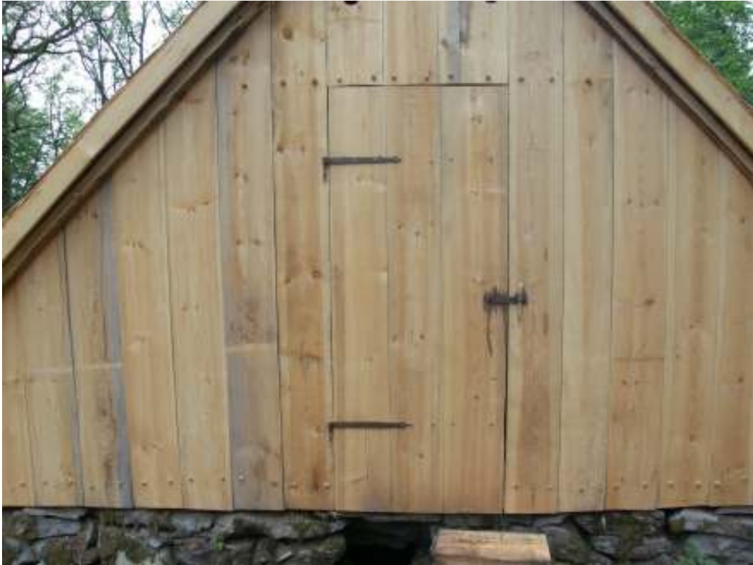
Jordkällarens östra dörr. Notera de återanvända dörrbeslagen.
