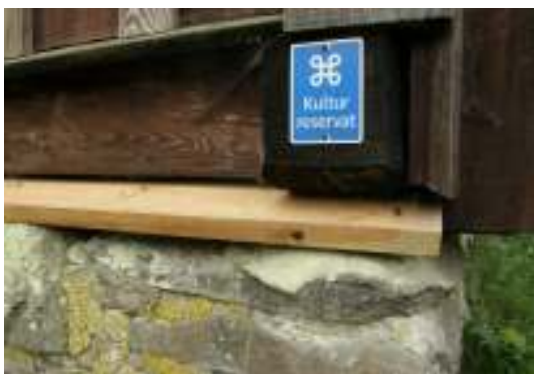
Ny vattbräda å norra långsidan.
