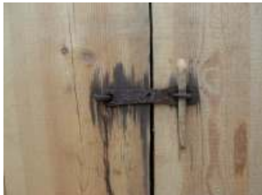
Östra dörrens låsningsbeslag.
