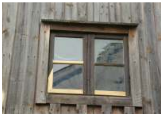
Fönstret på västra gavelröstet, efter arbetet.
