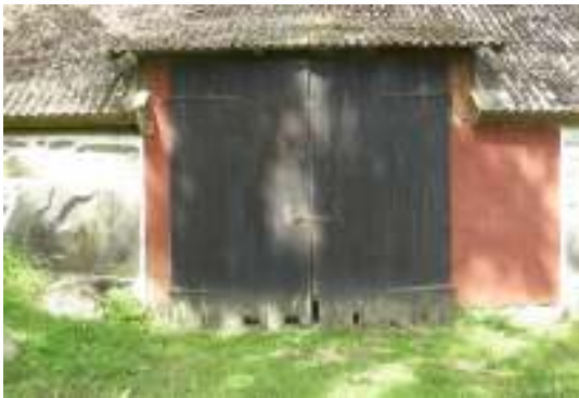
Västra längans logport innan arbetet.
