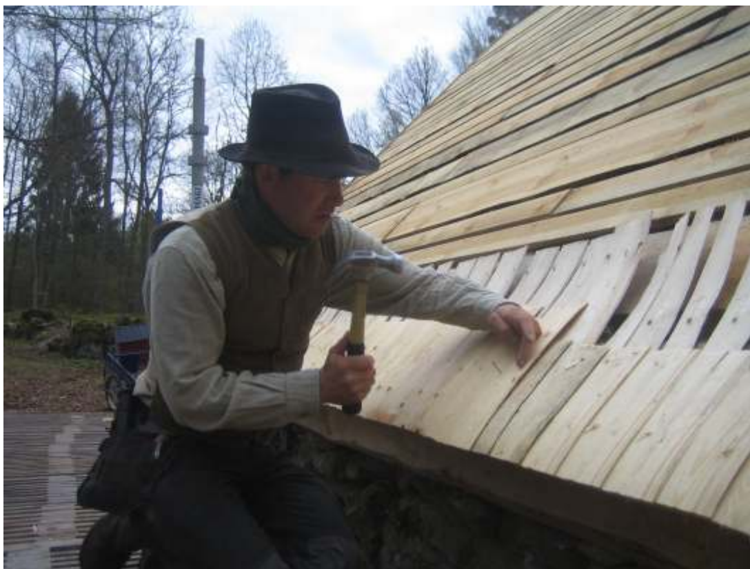
Norra takfallet täcks med stickor. Foto tillhörande Olof Andersson.
