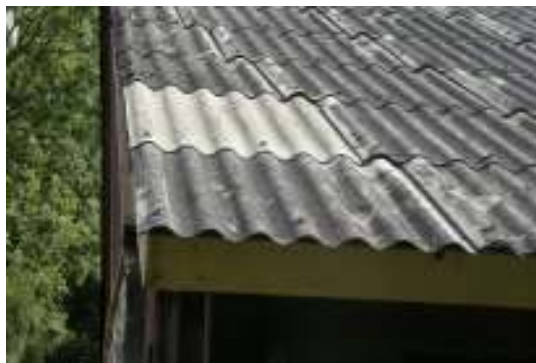
Ny eternitplatta på skyddstaket.
