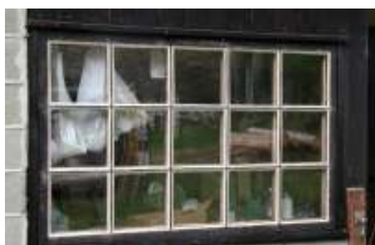
Ett av de 15-glasiga fönstren efter arbetet.
