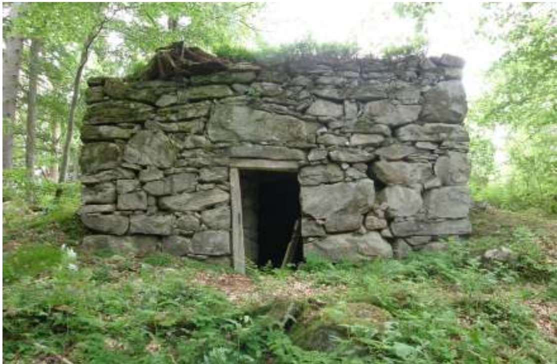
Jordkällaren före arbetet.
