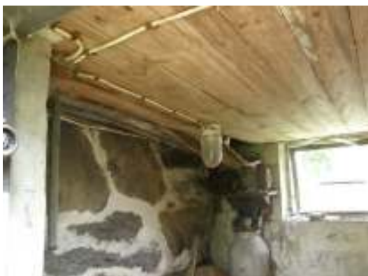
Mjölkrummets skadade innertak.
