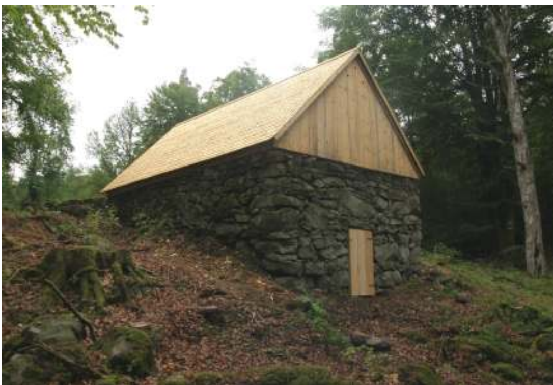
Jordkällaren efter återuppbyggnadsarbetet.
