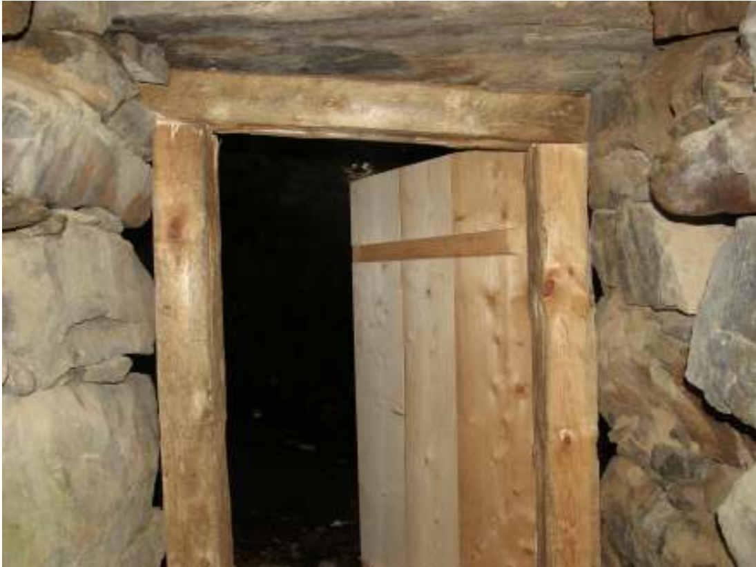
Jordkällarens västra, inre dörr. Notera den nygjorda karmen av bilad fur.
