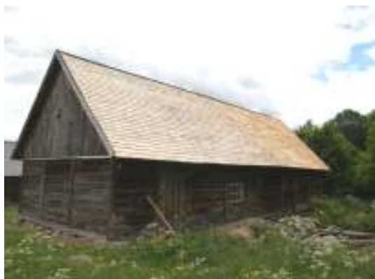
Östra längan efter arbetet.
