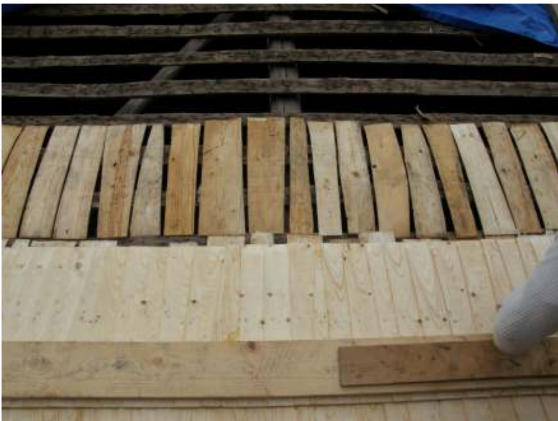
Östra längan under arbetet. Notera det undre lagret – förskalningen.
