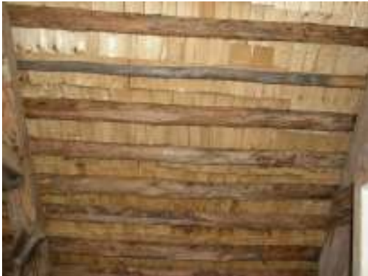
Södra takfallet, utan förskalning.
