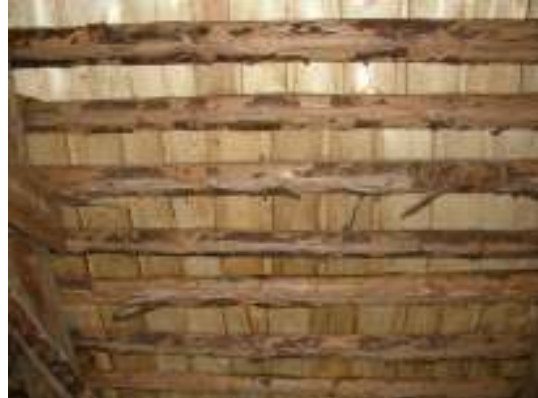
Norra takfallet, med förskalning.
