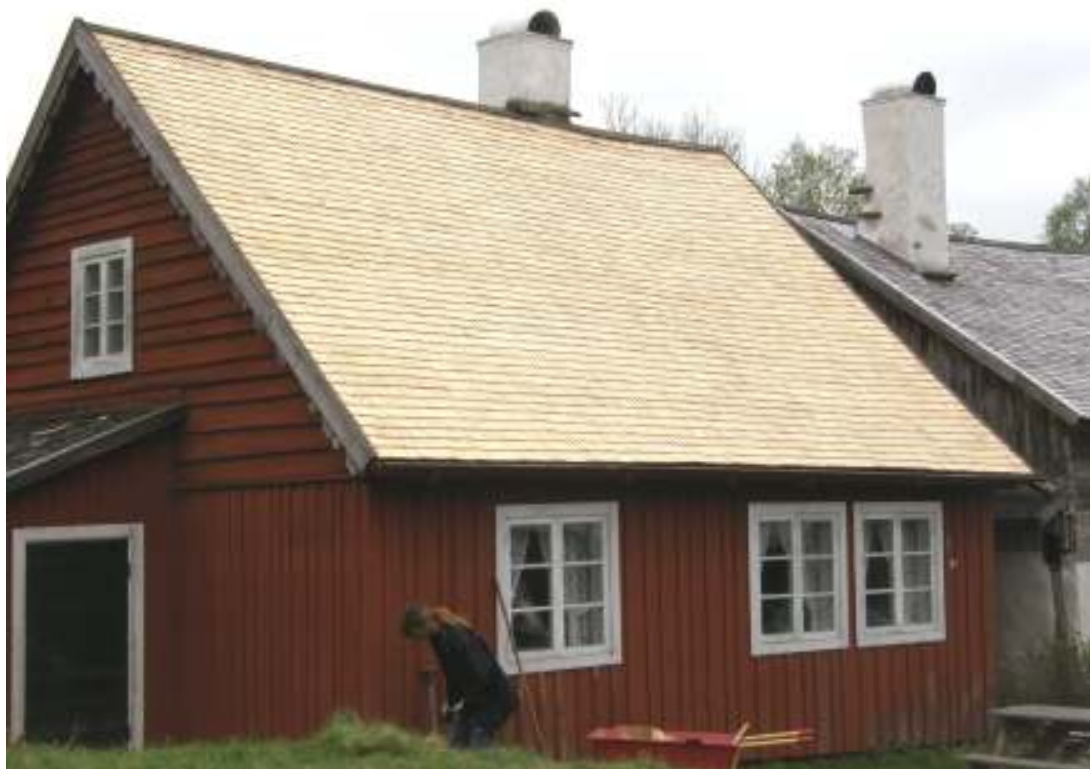
Arrendatorsbostadens norra takfall omtäckt.
