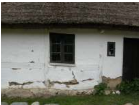
Boningshuset innan arbetet.
