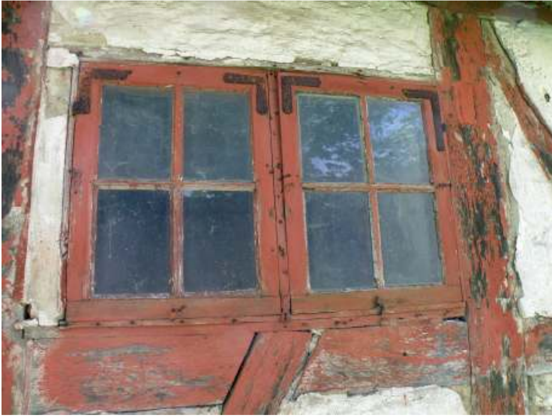
Gamla återanvända fönsterbeslag i äldre fönster.
