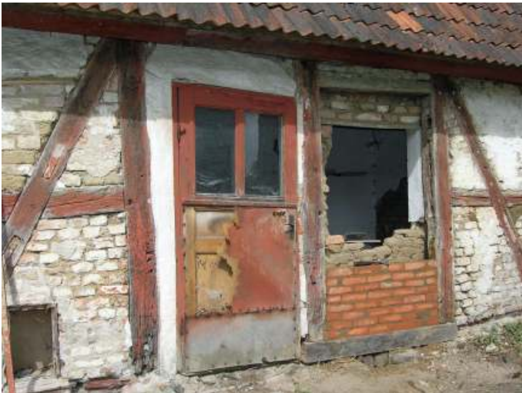
Ny tegelfyllning i fack där den vara raserad.
