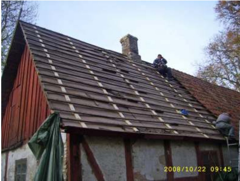
Sticketaket har täckts med oljebärdad masonite.
