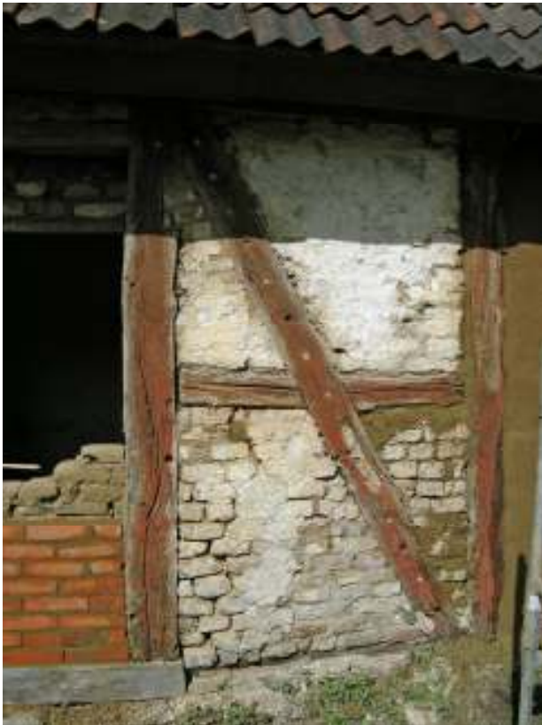
Exempel på återvänt virke, med synliga hål för käppar till stakerägg.
