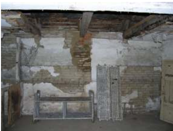
Ingrepp efter bjälkbyte återställt.
