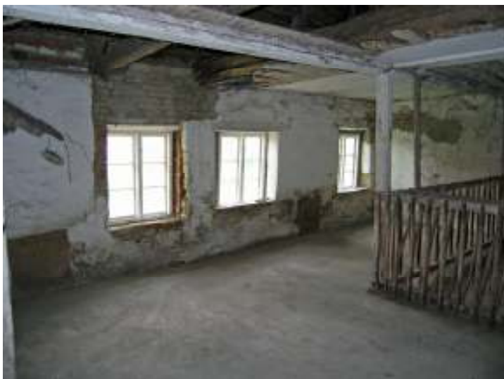
Interiör efter fönsterbyte.
