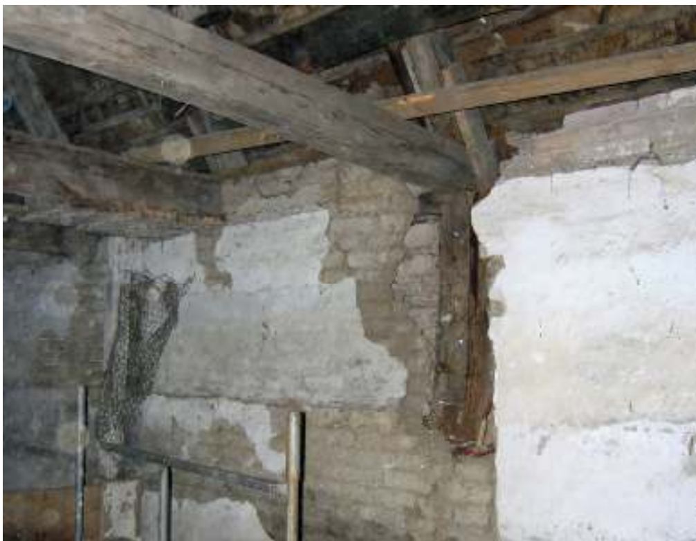
Utbytt takbjälke och förstärkt stolpe.
