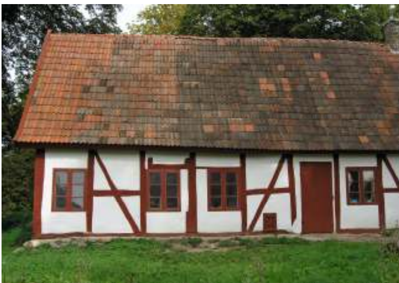
Del av sydfasaden efter renovering.
