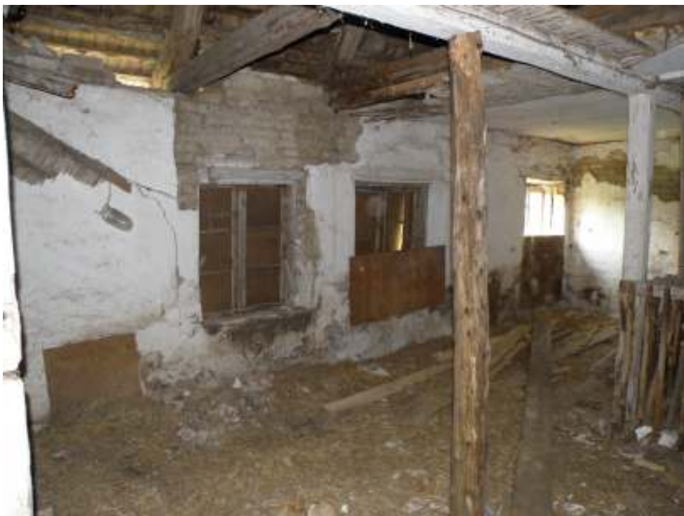
Invändigt syns separat murade innerväggar av råsten.
