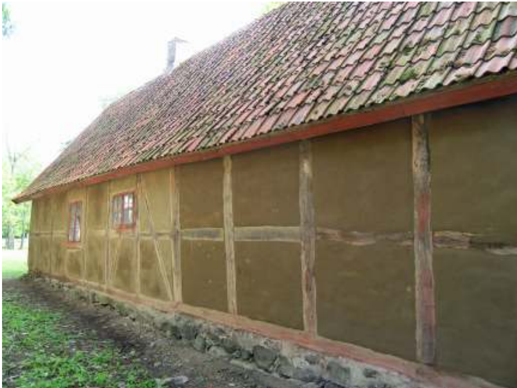
Fasaderna har putsats med lerbruk.
