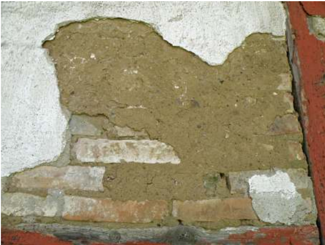
Befintlig lerputs.
