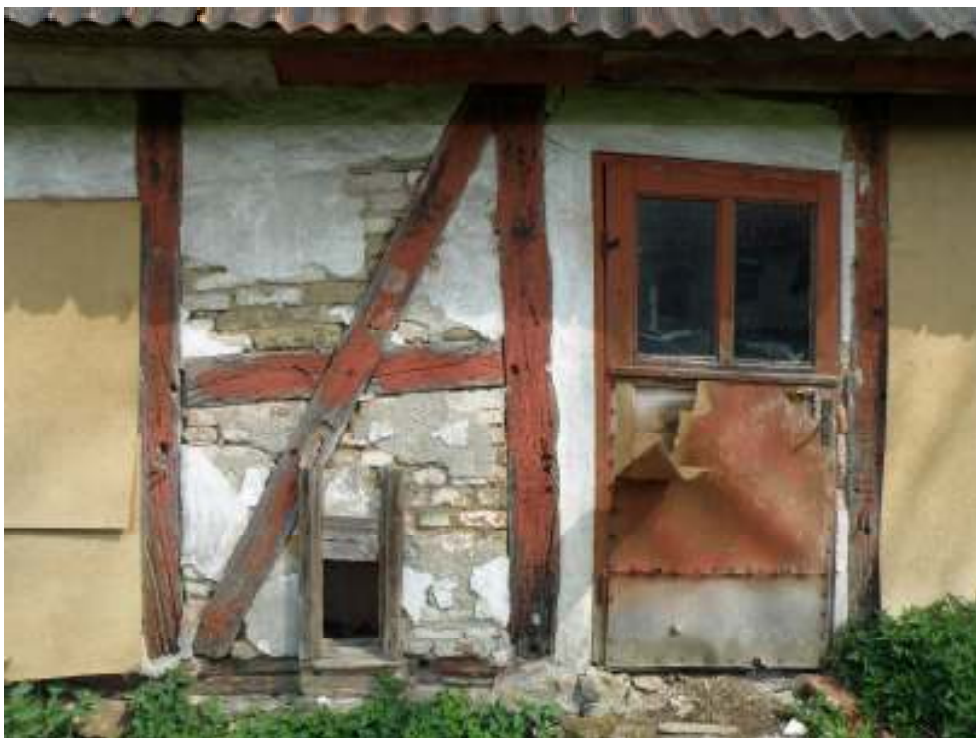
De flesta facken är fyllda med bränd tegelsten, något enstaka fack med råsten. På bilden syns bönsluckan som bevarats samt den ena dörren som ersatts med nytillverkad plankdörr.
