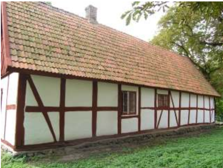
Fasad åt norr efter renovering.
