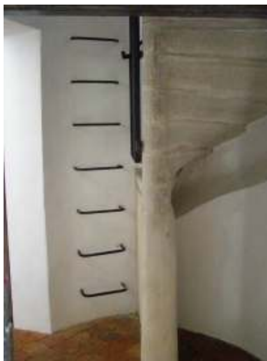
Bild 5 ovan.v: Gång i norra korsarmens östra bänkkvarter med utgång till tillbyggnaden via det nordöstra trapphuset. Bild 6 ovan t.h: Utrymningsstege på vägg i det nordöstra trapphuset. Bild 7 t.v: De fyra nedersta trappstegen i nordöstra trapphuset har demonterats för att lösa passagen till tillbyggnaden.
