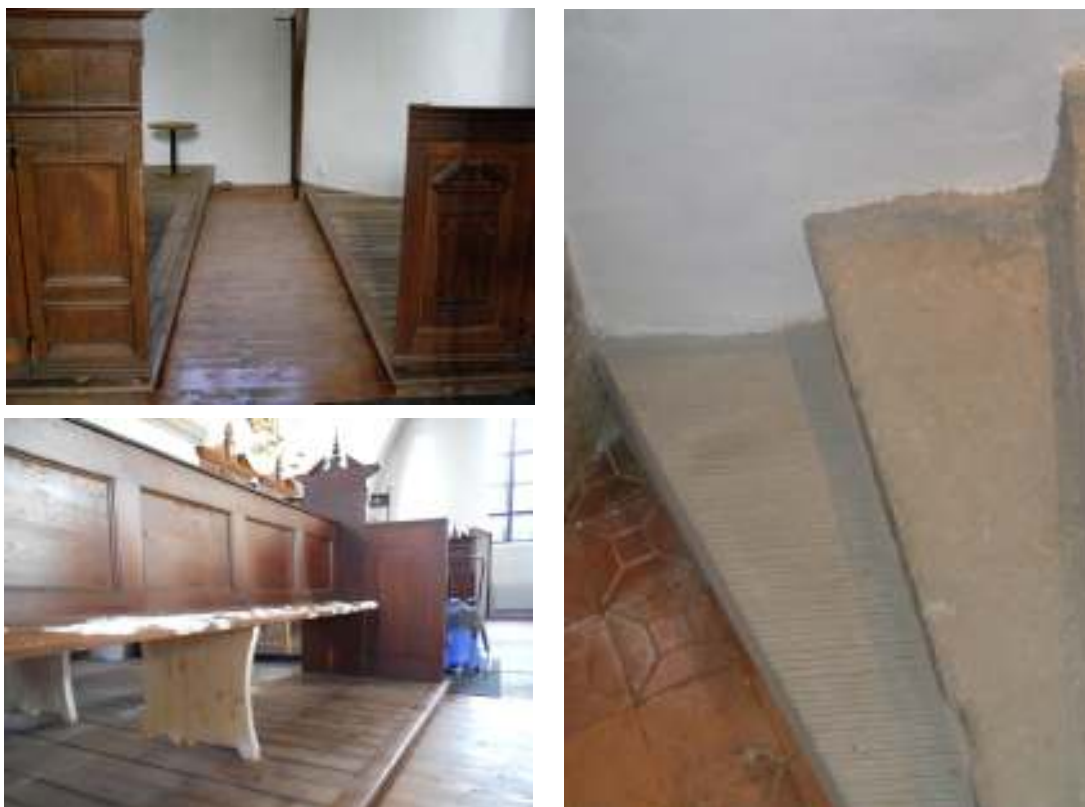
Bild 8 överst: Gång i norra korsarmens västra bänkkvarter med trägolv i samma nivå som den tegelbelagda gången från norra portalen. För att lösa nivåskillnader i gång och trapphus har ett trappsteg ner varit nödvändigt utanför trapphusets dörr. Bild 9 ovan: Återmonterad bänk i norra korsarmens västra bänkkvarter med nytillverkat stödben. Bild 10 t.h.: Trappsteg av sandsten i nordvästra trapphuset. Det nedersta trappsteget är nybygget medan trappsteg nr 2 är ett av de ursprungliga stegen som bevarats under skorstensstockens dragning.
