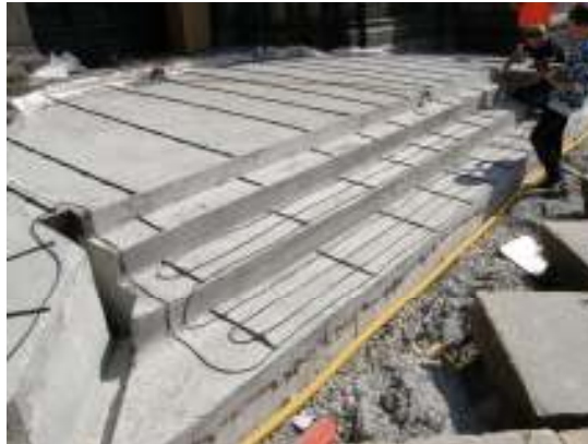
Bild överst t.v.: Geotextil och gjutning mot västportalens södra omfattning.
