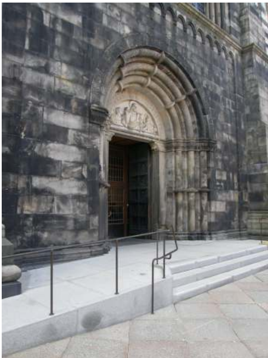
Bild ovan: Lunds domkyrka – tillgänglighetsanpassning med trappa, vilplan, ramper och räcken på sommaren 2010.
