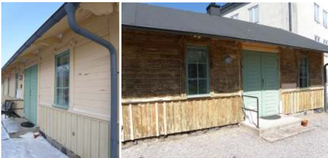
Bilderna visar delar av den södra fasaden innan arbetena påbörjats respektive sedan panelen rengjorts in till bart trä.
