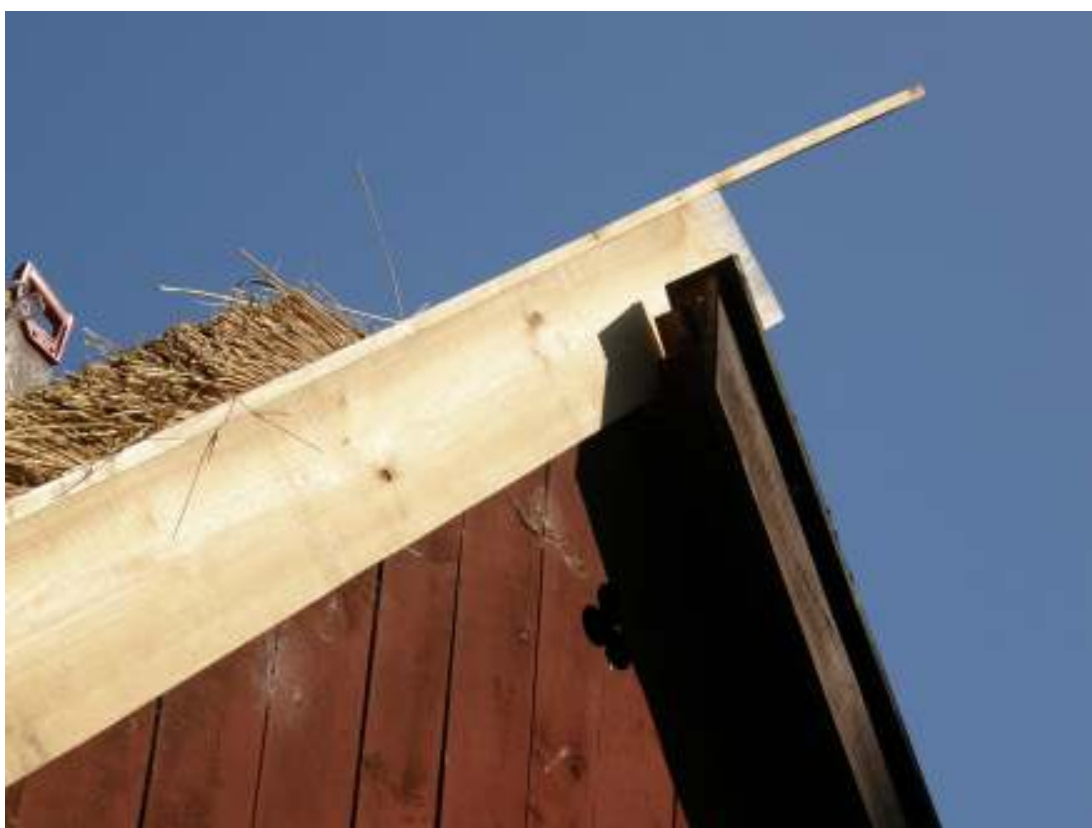
Fig. 19. Den tillfälliga skarven mellan ny och gammal vindskiva. Södra gaveln.
