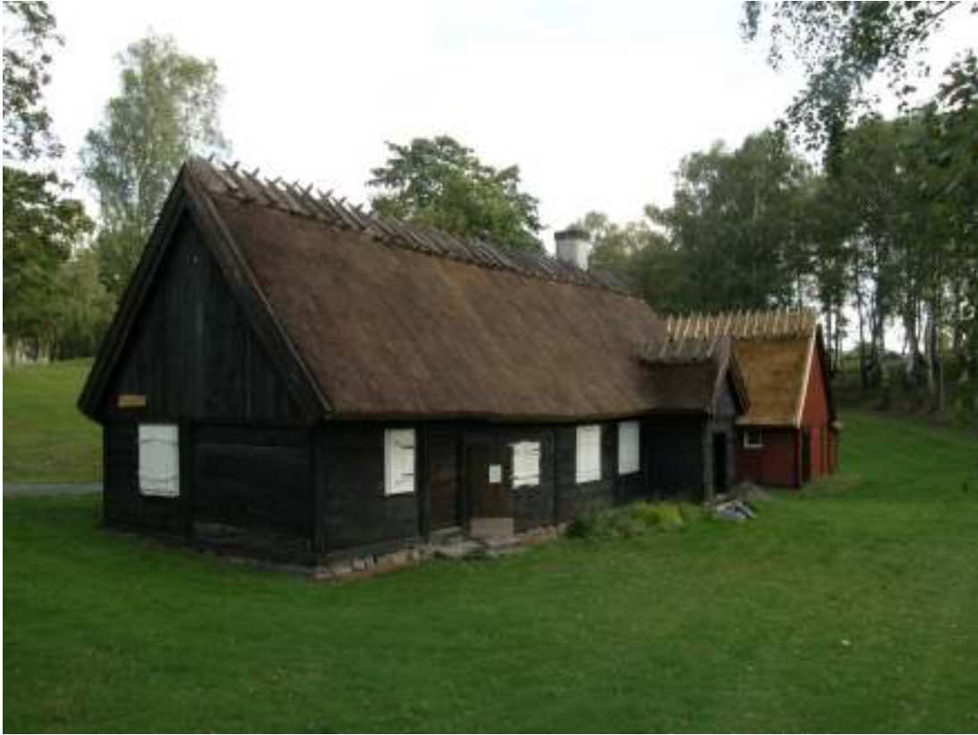
Fig. 16. Vy mot öster, efter arbetet.
