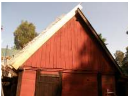
Fig. 5. Södra, nya vindskivan.
