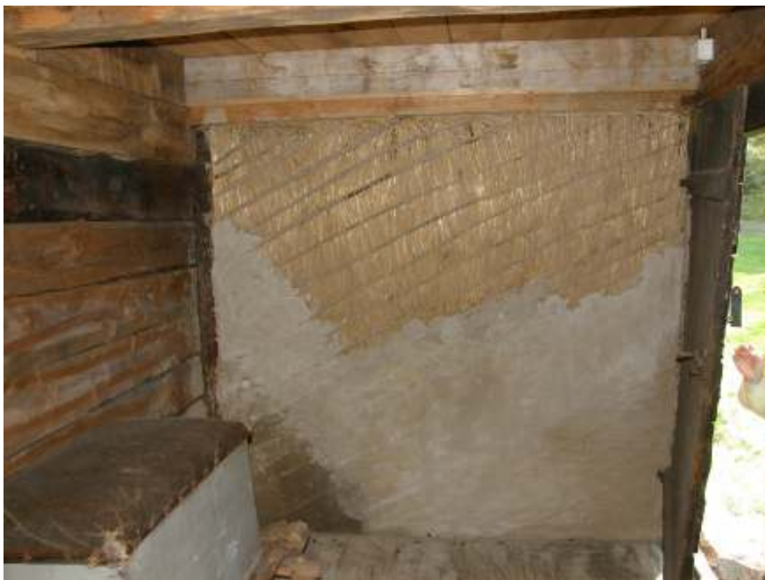
Fig. 13. Den lerputsade båleväggen i "smekammaren".
