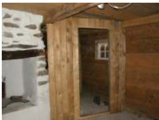
Fig. 7. Den nyuppförda plankväggen.
