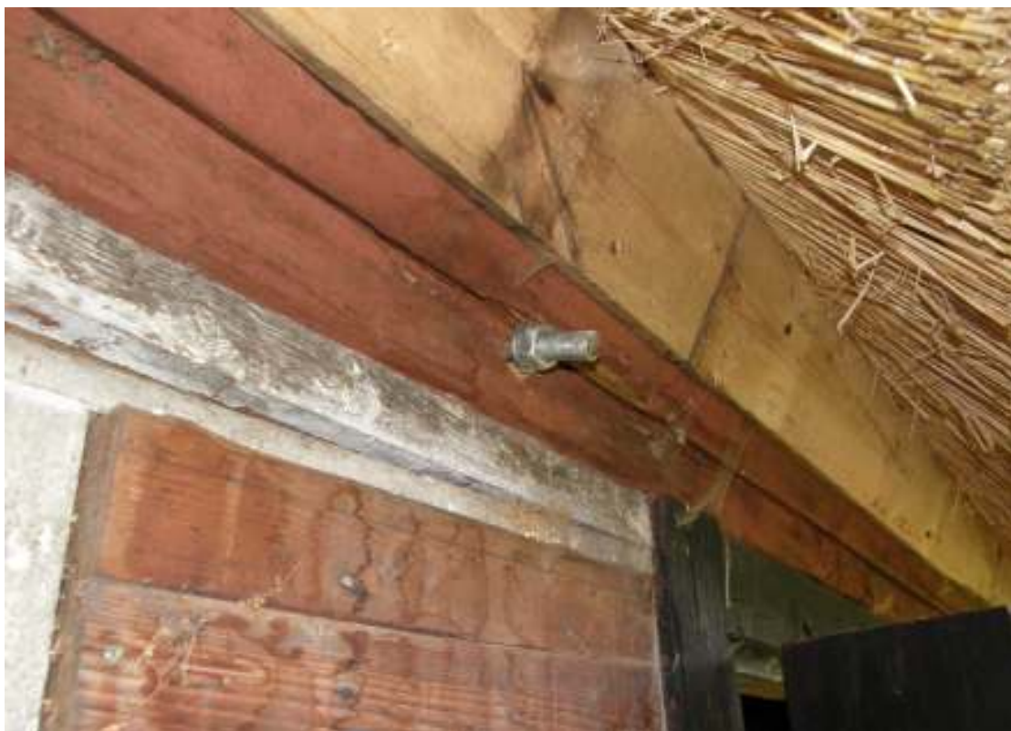
Fig. 14. Det genomgående dragjärnet i fähusets västra långsida.
