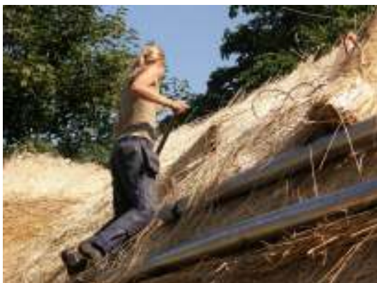
Fig. 2. Västra takfallet under arbetet.
