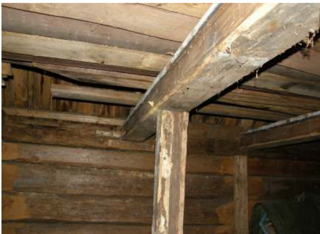
Fig. 15. Dubbad stolpe i fähuset.
