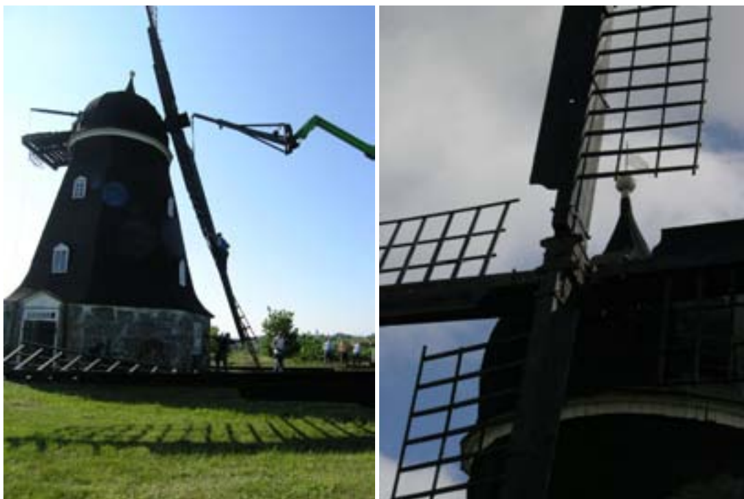
Foto: Ingela Blomén. Kranföraren lyfter upp en vinge i taget. Varje moment sker i samspel med möllebyggaren och hans medarbetare. Till höger har vindflöjeln åter kommit på plats, högst upp på hättans toppklot.
