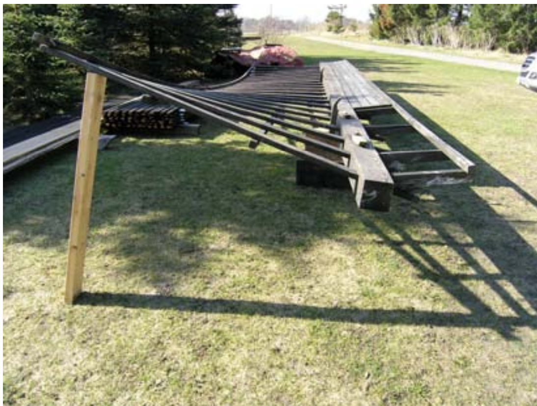
En vinge som nyligen har strukits med träskydd bestående av trätjära, balsamterpentin och linolja.
