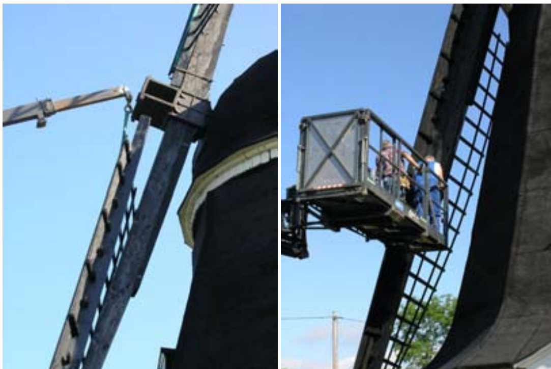
Foto: Ingela Blomén. Till vänster lyfts en av vingarna på plats för att förankras i axeln. Till höger monteras klamrar kring samma vinge, för att få den att fästa vid vingbalken.
