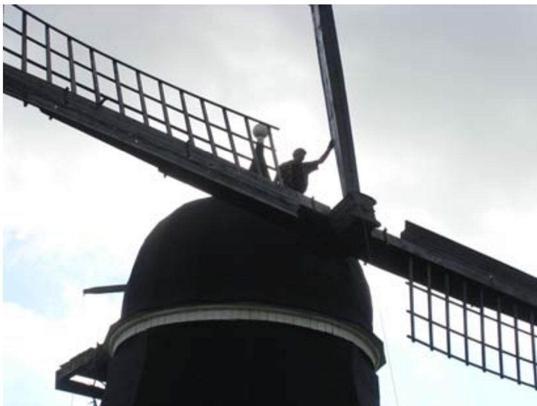
Foto: Ingela Blomén. Arbete på uppe från hättan när vingbalken ska fästas in i spindeln.
