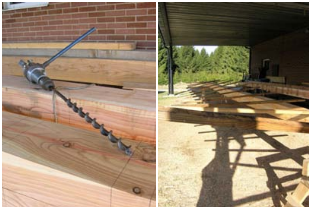
Till vänster det borr som användes vid borrning av hål till bäckskedarnas infästning i vingträet. Till höger bäckskedar som börjar anta vingens skålförm.
