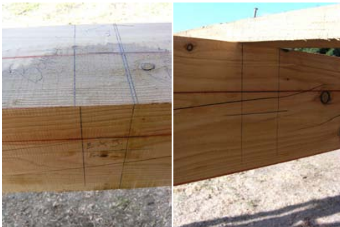
Till vänster vingträ med balkbrottet markerat. Till höger har en bäckskeed försiktigt spikats fast för att markera vinkeln som den ska ha på vingen.
