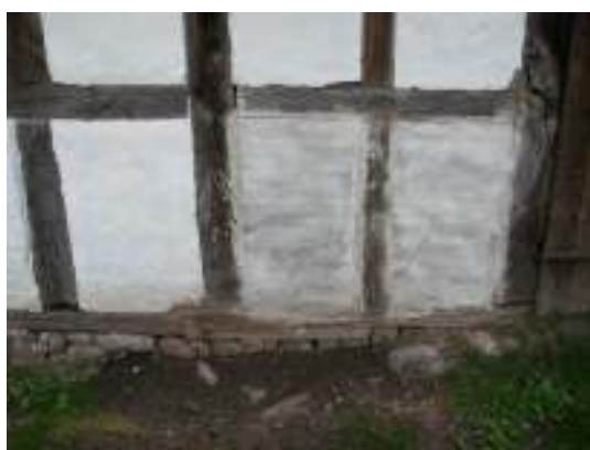
Fig. 4. Västra längan efter arbetet.
