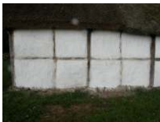
Fig. 5. Östra längan efter arbetet.
