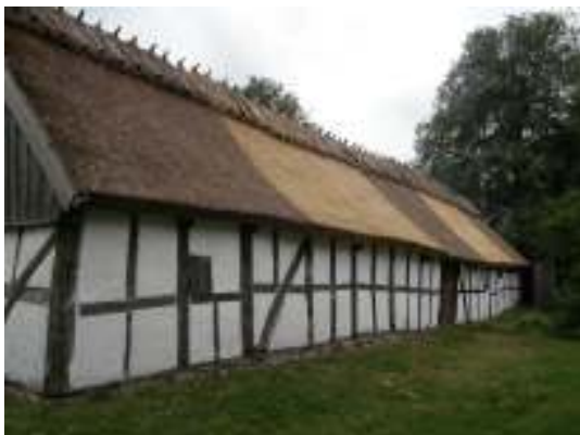
Fig. 1. Västra längan efter arbetet.
