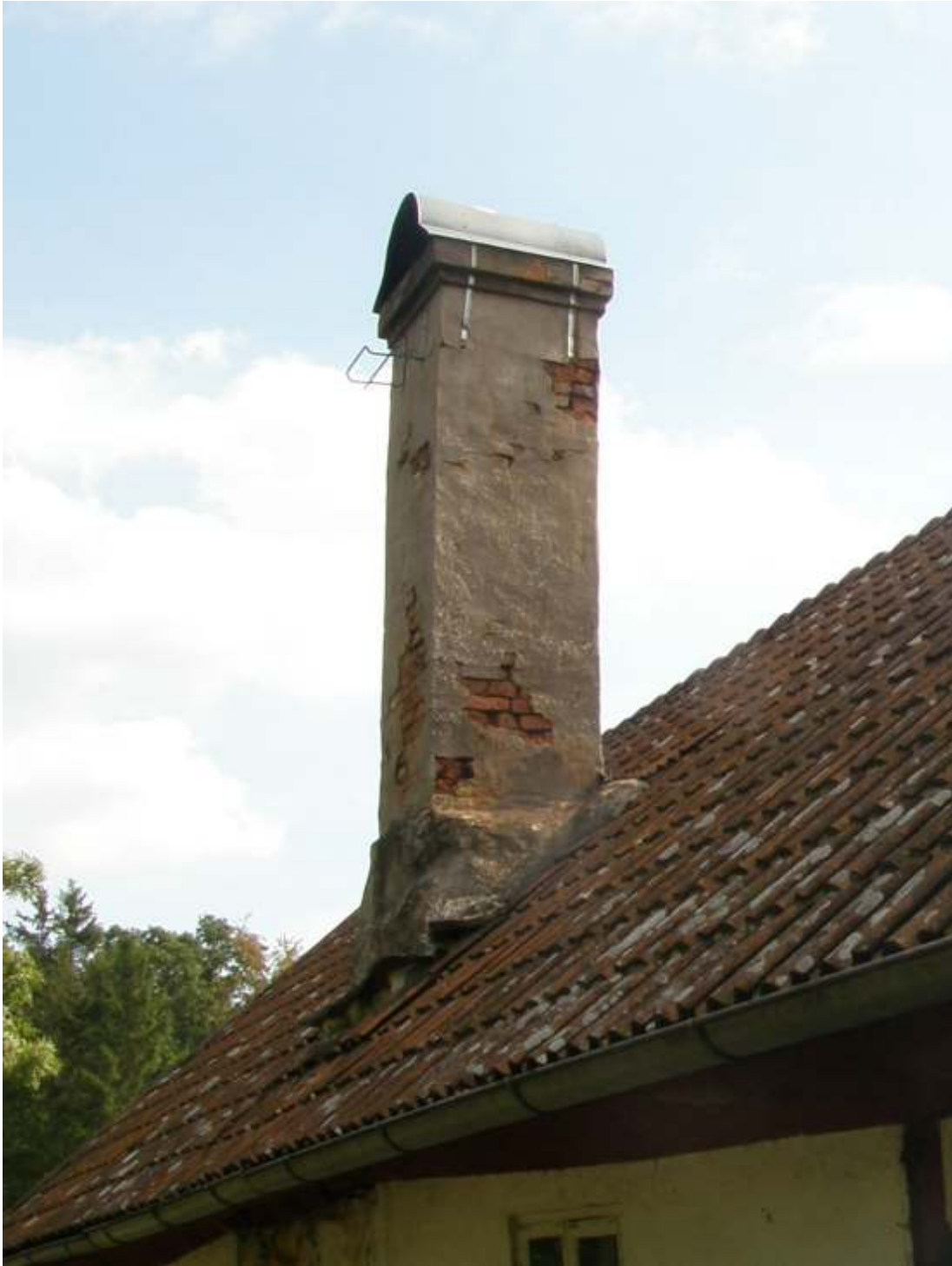
Fig. 10. Skorstenen innan arbetet.
