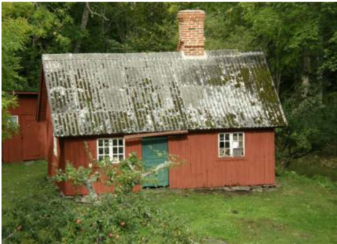
Fig. 17. Brygguset efter arbetet (sista nockvinkeln ännu inte monterad då bilden togs).
