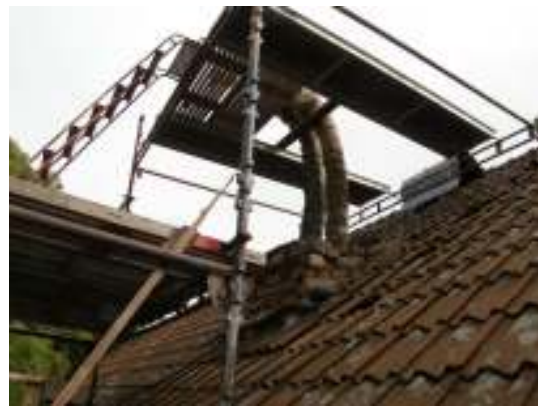
Fig. 3. Efter att teglet monterats ned.
