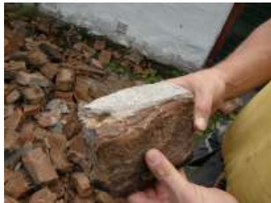
Fig. 5. Cementputs på tegelsten.
