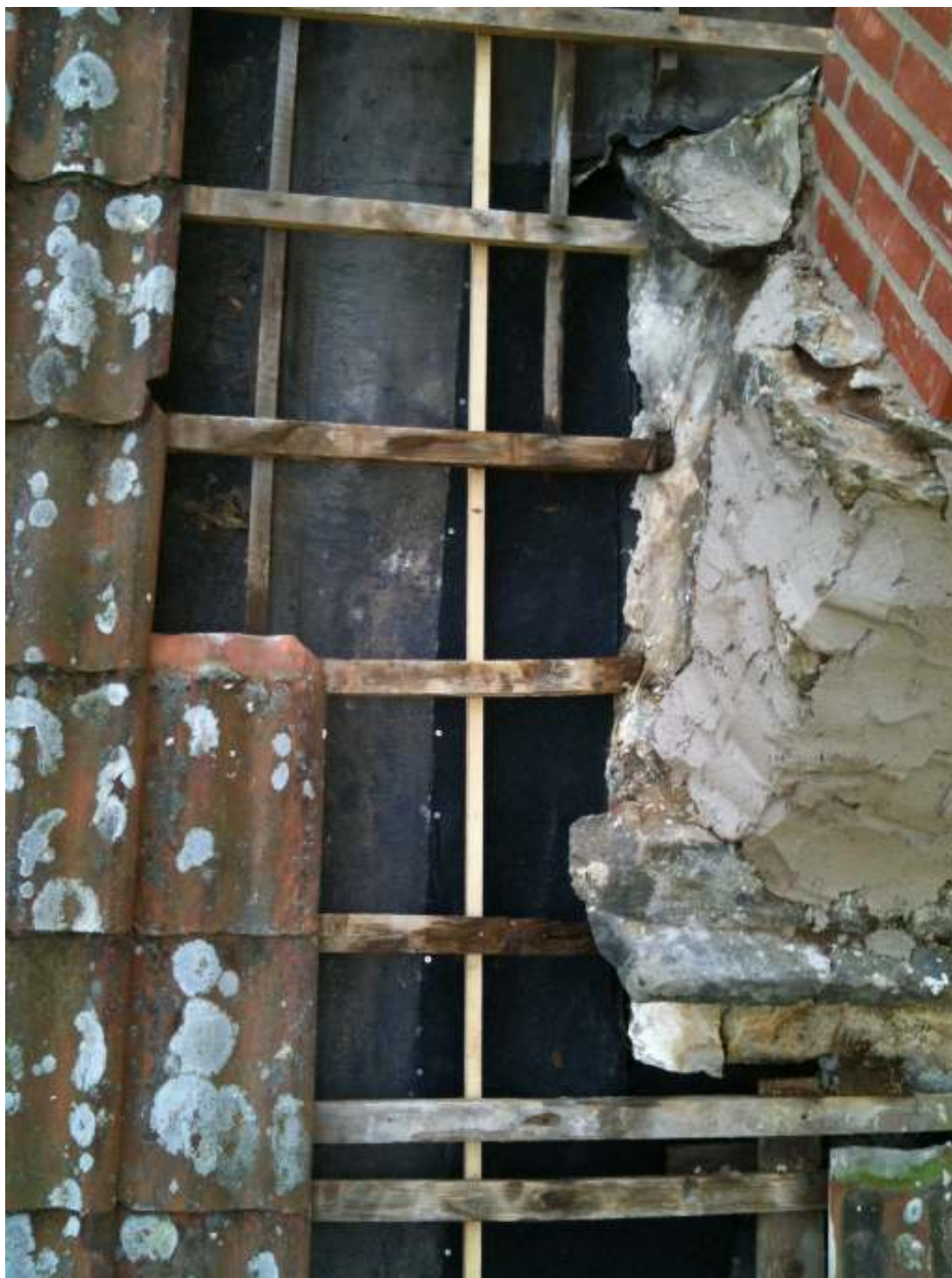
Fig. 15. Bytt ströläkt vid skorstenens östra sida, samt partiell takpappslagning. Foto Henrik Nilsson, 2010.
