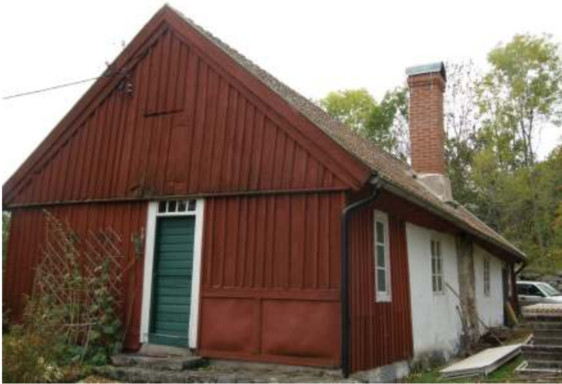
Fig. 11. Skorstenen efter arbetet.
