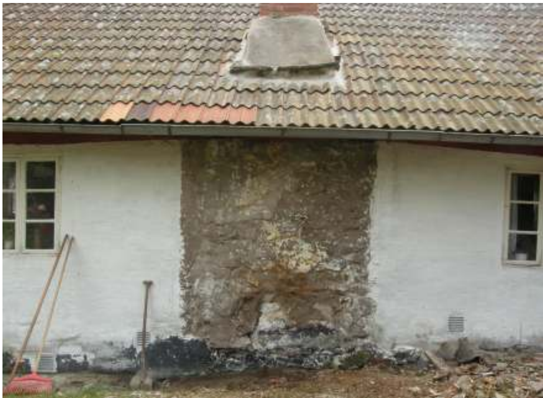
Fig. 14. Bakugnens yttervägg rengjord.
