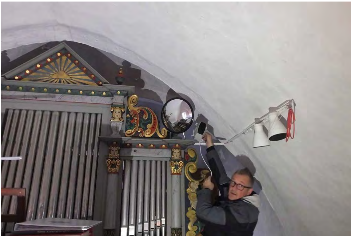
Inprovning av linjedektorns sändarplacering på orgelläktaren.
