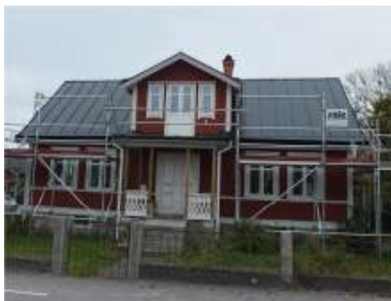
Det färdiglagda plåttaket från framsidan.
