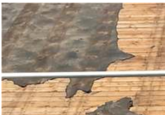
T.v. Äldre takpapp som låg under eternitplattorna vid rivning av taket. T.h. Ny takpapp lagd horisontellt.
