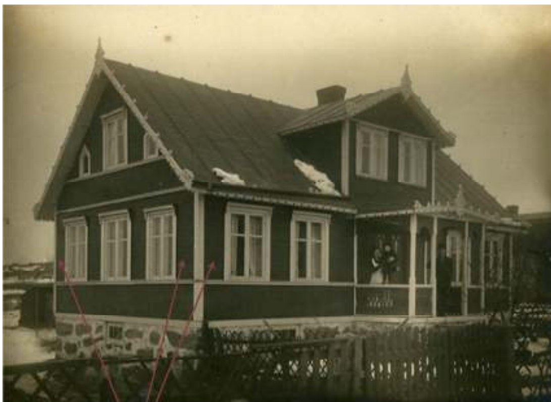
Foto från 1900-talets början visar byggnadens ursprungliga arkitektoniska uttryck. Fotot är ett arkitektförslag som redigerats. Ett extra fönster har lagts till på bottenvåningens gavelparti. Pilarna visar avstånden mellan knut och fönster.
