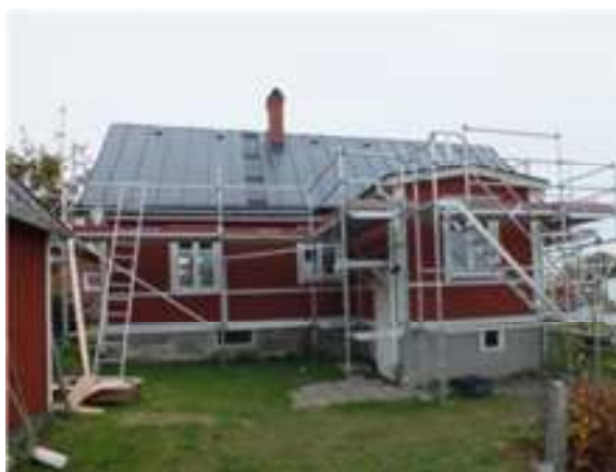
Baksidans plåttäckta takfall med ventilationsöppningar.
