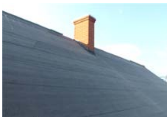
T.v. Äldre takpapp som låg under eternitplattorna vid rivning av taket. T.h. Ny takpapp lagd horisontellt.
