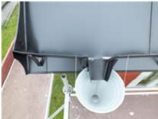
T.v. Fotränna och vattkupa som fäst med tvinnad ståltråd
