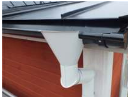
T.h. formklippt vattkupa mot hängränna på utbyggnad.
