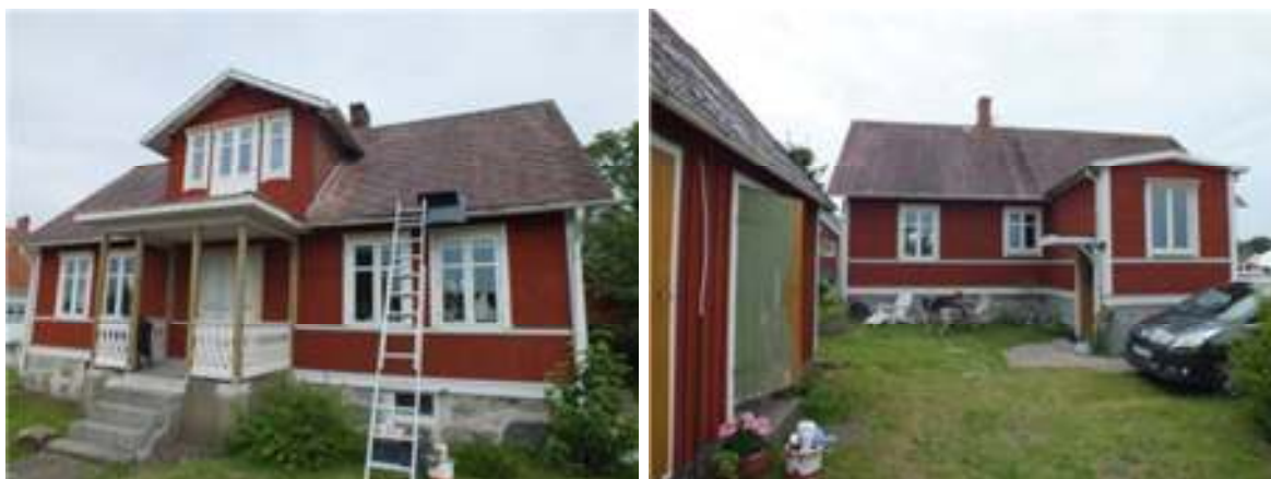
Framsidan före restaurering belagd med eternitplattor.
