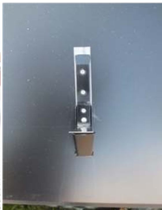
T.v. Vattkupa utan sarg och smala stuprör med raka vinklar. T.h. rännkrok fäst mot fotplåt med blybit emellan.
