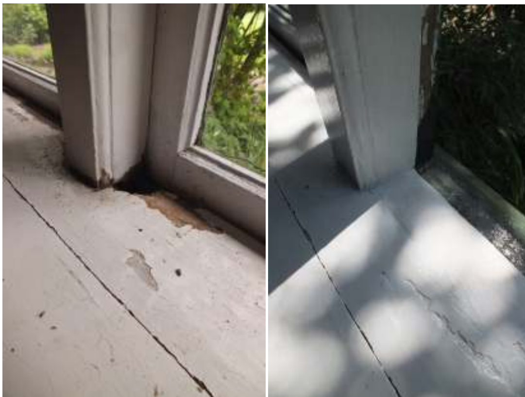
Fönstret i gästrummet längst i öster mot trädgården lagades i karmens bottenstycke, hela fönstret skrapades lätt och avfärgades med vit linoljefärg likt förut.
