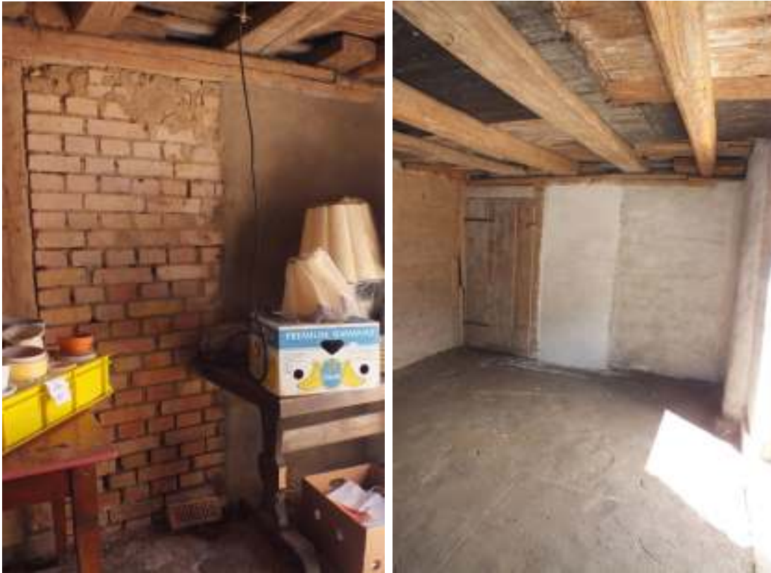
Bethuset renoverades för publikt syfte genom sanering, putsning, kalkning och vältning av lergolv. T.n. ses tegelväggen som putsades i sin helhet. T.h. ses rummet efter att arbetena var klara.
