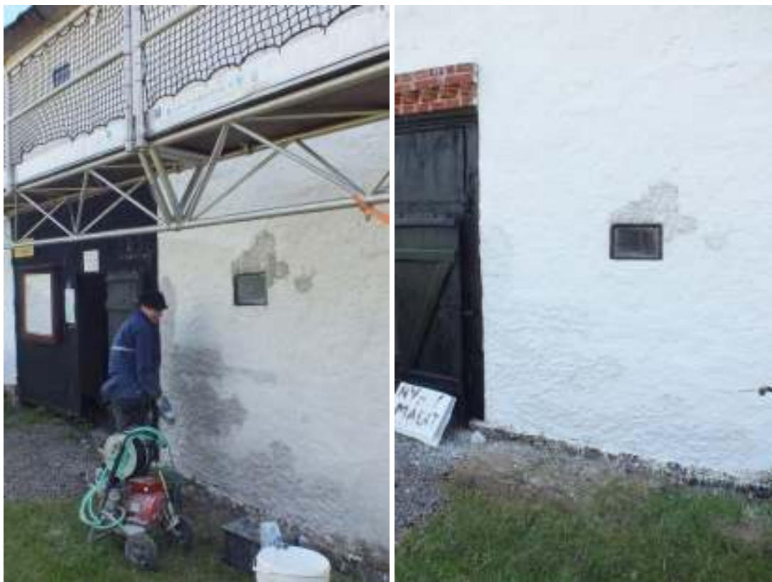
Putslagning utfördes på portalängans norra sida, närmast porten. Ställningar sattes upp så att man kunde kalkfärpa hela fasaden.
