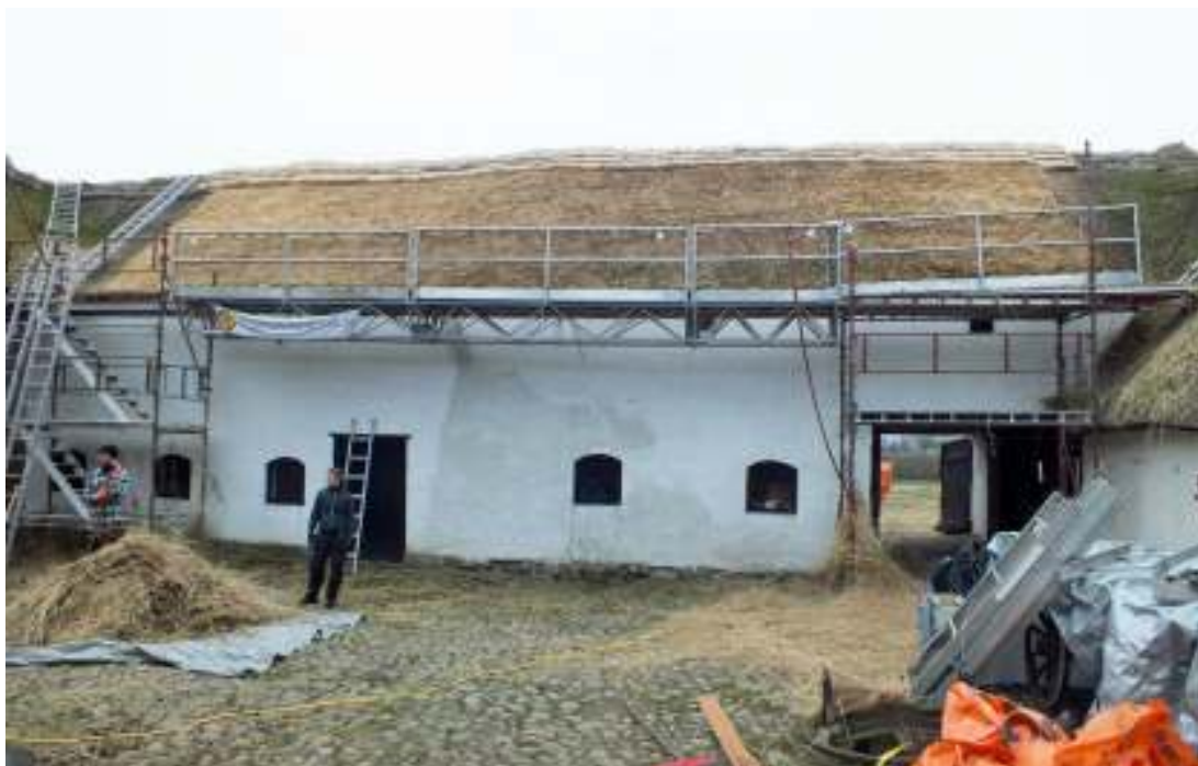
Portalängans tak efter omläggning med ny halm, november 2013.
