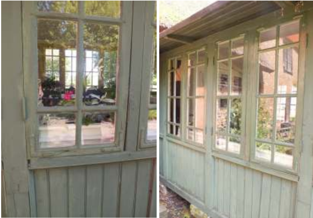
Verandans fyra fönster på den västra sidan närmast köksingången var rötskadade i bågbottenstyckena och lagades genom bladning i bågbottenstyckena. Det var bara fönstren som målades under årets arbeten.
