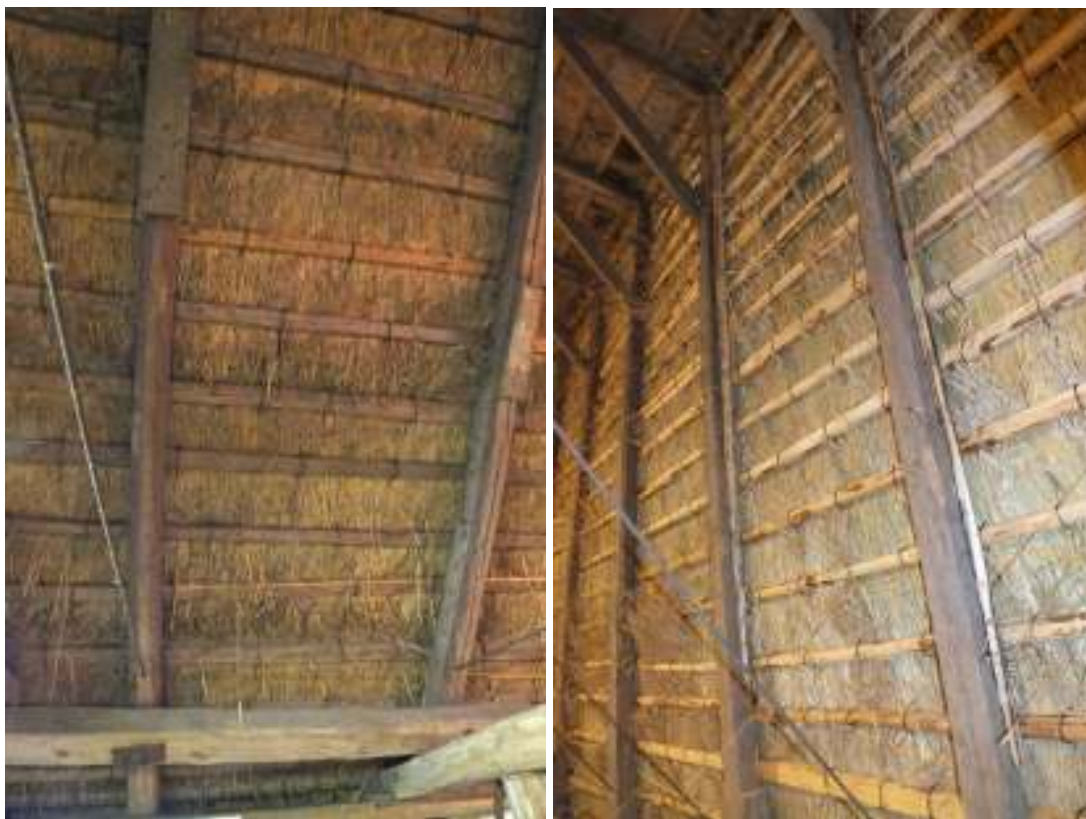
Portalängans tak före (t.v.) omläggningen, sommaren 2013 och efter (t.h.) november samma år. Ett lager med halm var lagt på ströläkt varför det inte fanns några stora vippor med ax på takets insida.
