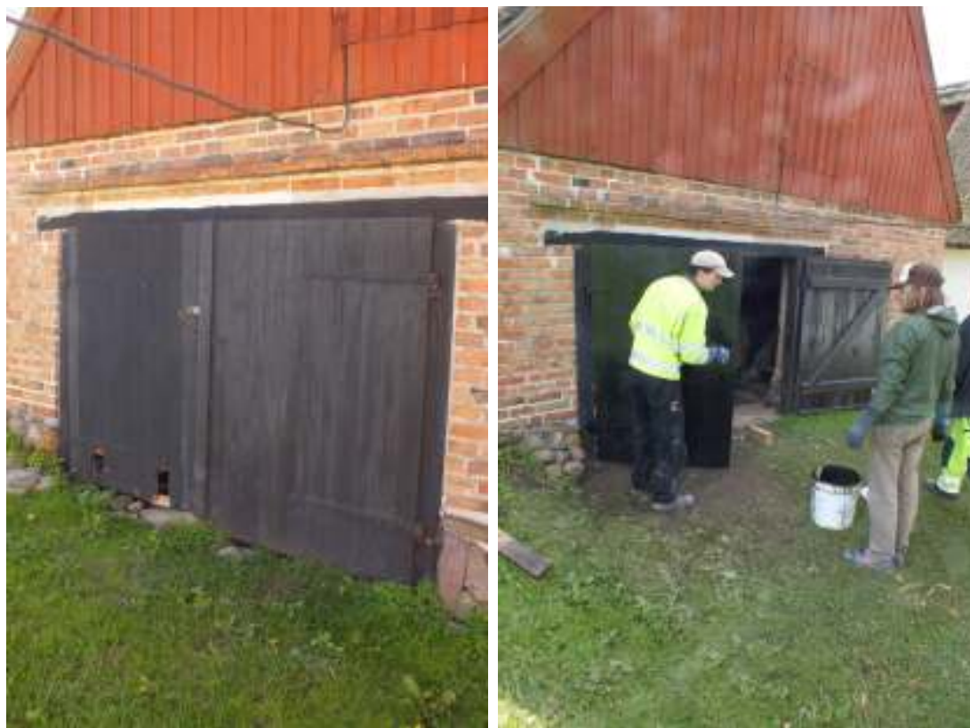
Det vänstra dörrbladet på hönsarhusets norra port var i dåligt skick och ersattes med ett nytt. T.h. ses målning av den nya portdelen med kimrökspigmenterad trätjära.
