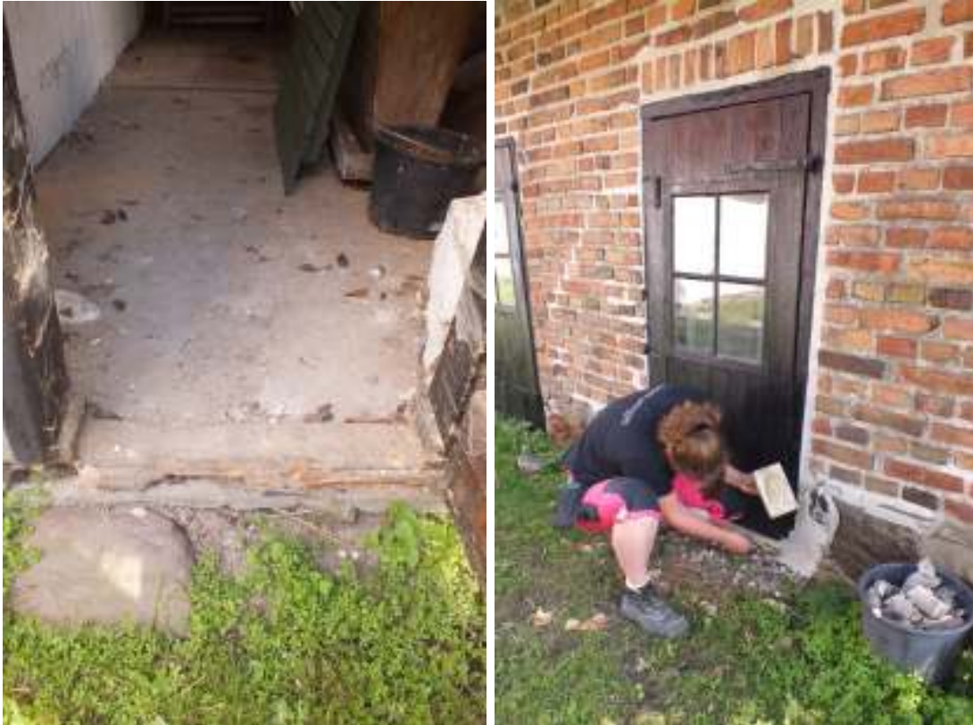
Tröskeln till hönsbusets högra dörr lagades genom att tröskeln kompletterades med nytt virke och fogades med kalkbruk.
