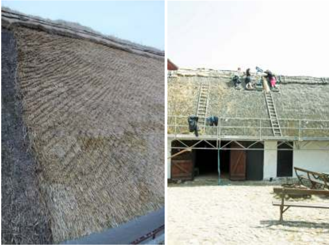
Taket på portalängan efter att det lagts klart (t.v.) i november 2013 och lagning av ryggingen på Gammel Boels tak (t.h.).
