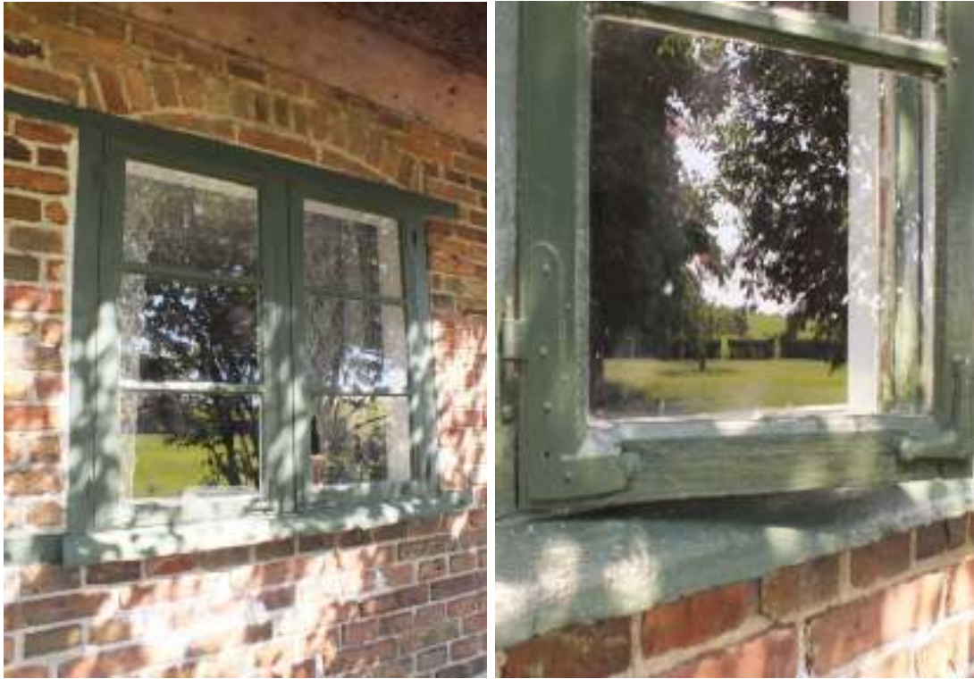
Fönstren på boningshusets baksida kittlagades och anvärgades med gårdens specialblandade gröna linoljefärg. Här ses gästrummets fönster längst i öster som är ett av de fyra gamla fönster som finns kvar på denna sida.
