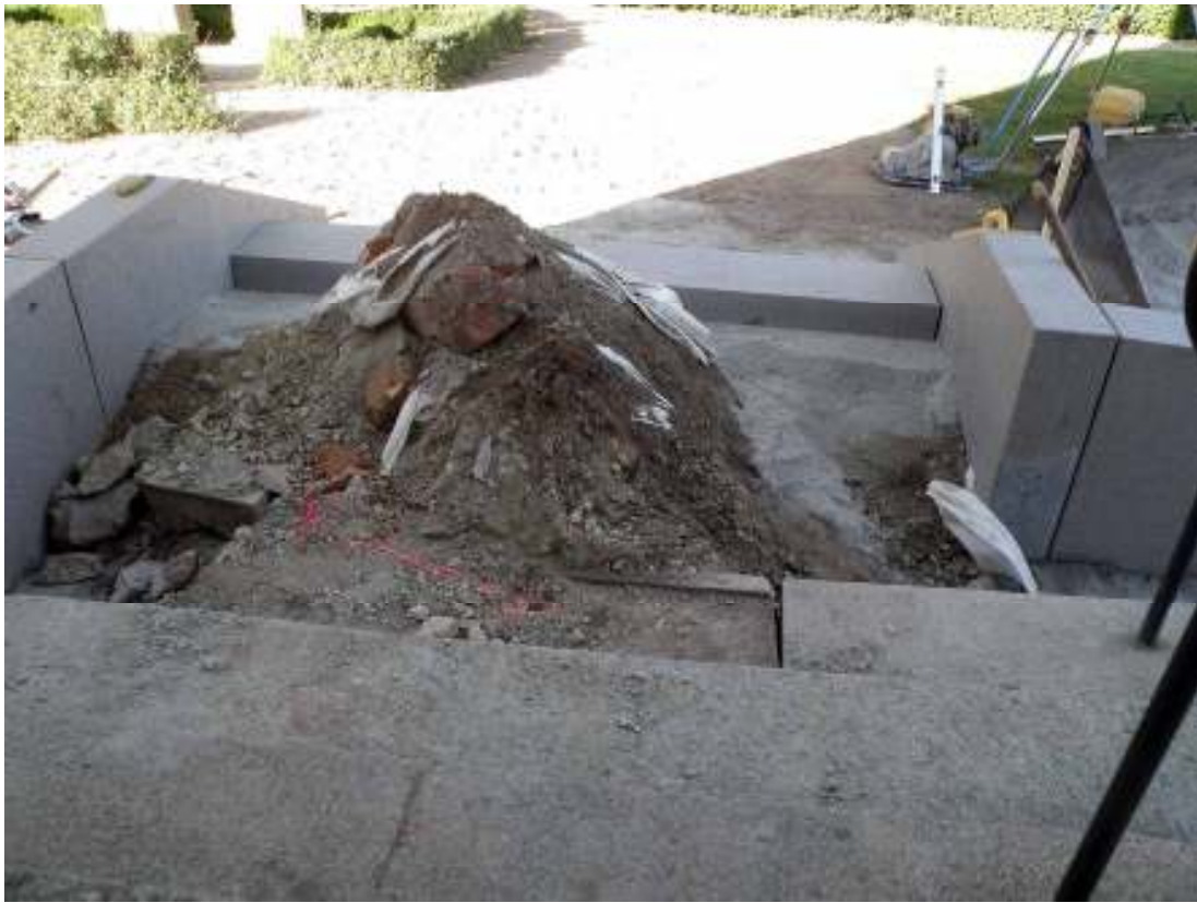
Den gamla trappans blocksteg och schaktmassor från grävningarna användes som fyllning under rampen.
