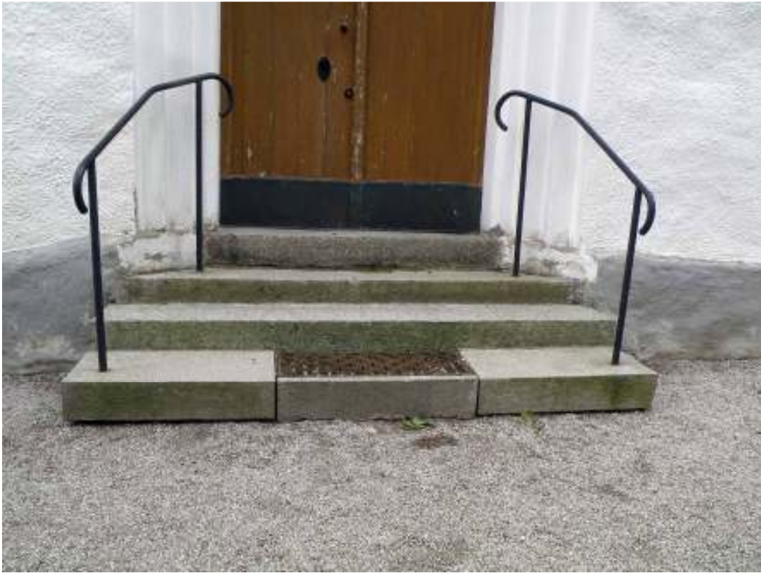
Entrén till kyrkan 2010 före utförda åtgärder. Fyra trappsteg lede upp till västportalen. Det nedre steget föreföll nyare än de övriga stegen av granit.
