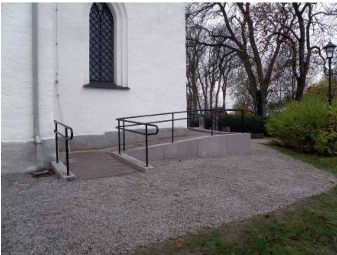
Färdig ramp med rücke monterat i november 2012. Från norr.
