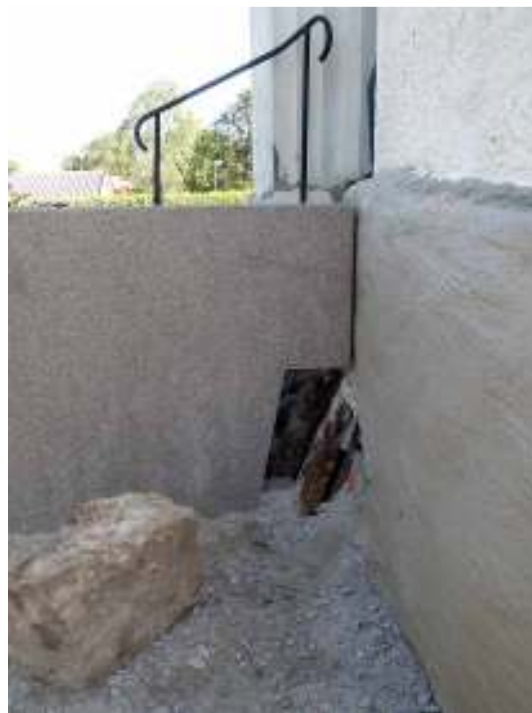
Anläggningsarbete vid långbusets nordvästra hörn. En ledning går in i kyrkan vid trappans södra sida. För att göra plats för ledningen gjordes ett urtag i trappans stödmur. Ledningen putsades sedan över.
