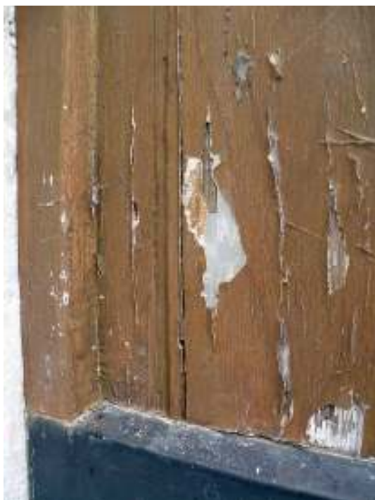
Närbild av kyrkporten före ommålning. Minst tre olika färglager syntes på dörren. Västra porten efter ommålning (dörren var inte lackad ännu).
