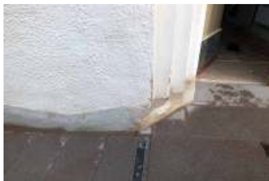
Dörrens sparkeplåt förlängdes med ny kopparplåt nedtill eftersom anslaget mot den gamla trappstenen var borta.
