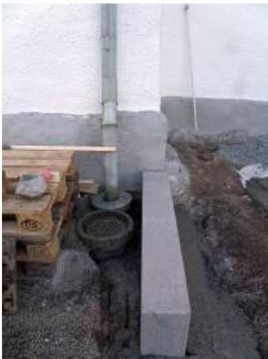
Anläggningsarbete vid långbusets nordvästra hörn. En ledning går in i kyrkan vid trappans södra sida. För att göra plats för ledningen gjordes ett urtag i trappans stödmur. Ledningen putsades sedan över.
