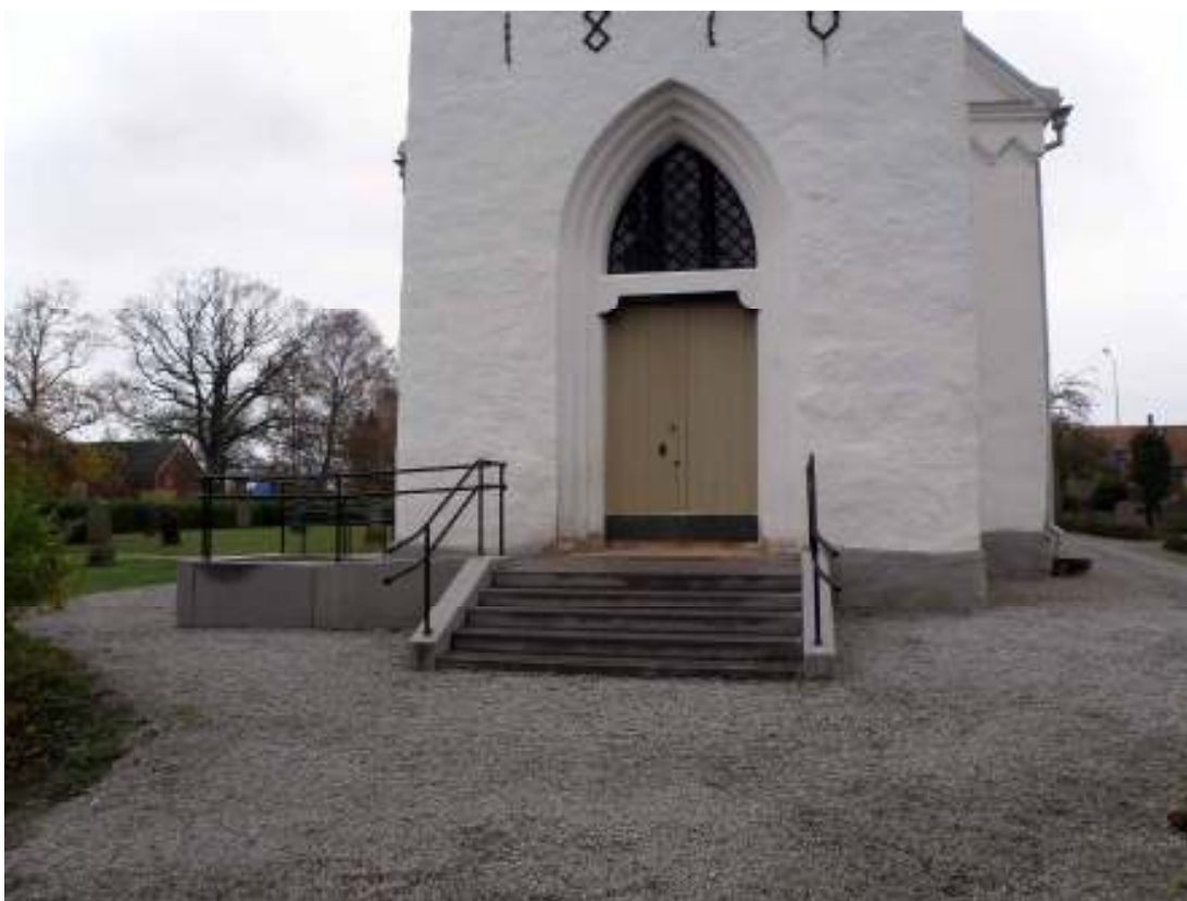
Den nya rampen och trappan från väster. Dörren är inte färdigmålad vid detta tillfälle. Färgen som syns på dörren är endast en grundfärg för den ekådring som sedan utfördes i januari 2013.
