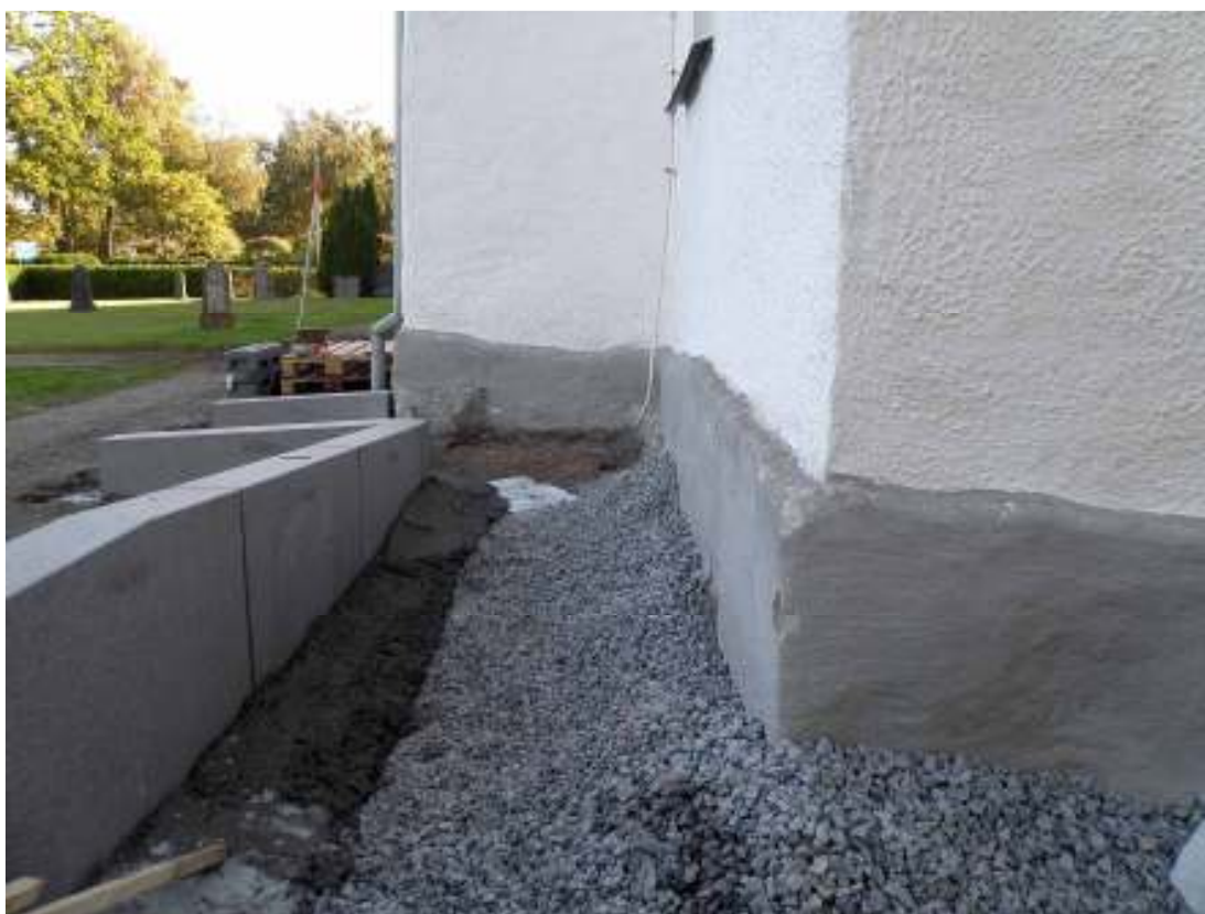
Norra sidan av tornet vid anläggandet av rampen. Sidomurar av granit placerades i grävda rännor utmed rampens sidor. Marken täcktes med geotextil och fylldes upp med makadam. Rampens ovansida kläddes med plattor av granit lagda i stenmjöl.
