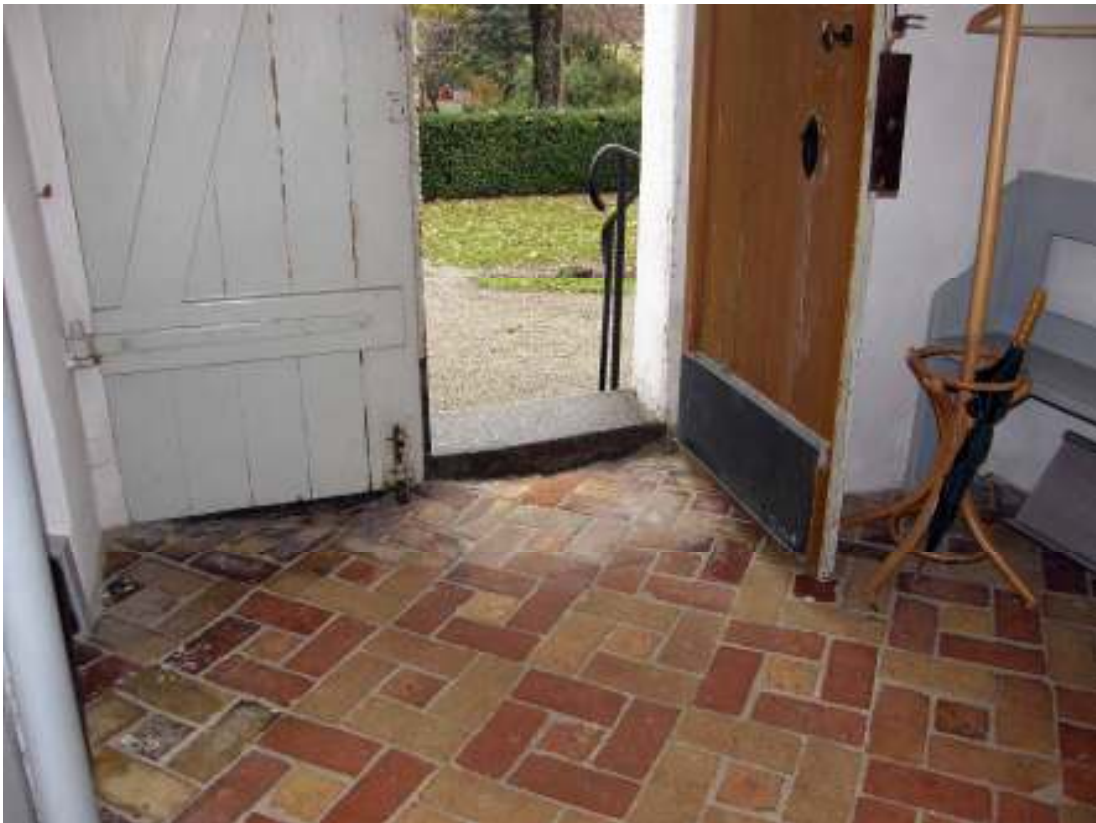
Det övre trappsteget låg som tröskel i dörröppningen med anslag mot dörrens nederkant. Dörren utgörs av en brüddörr sannolikt från 1800-talet. Det kraftiga låset på insidan är från 1814 enligt en inskrift på låset.
