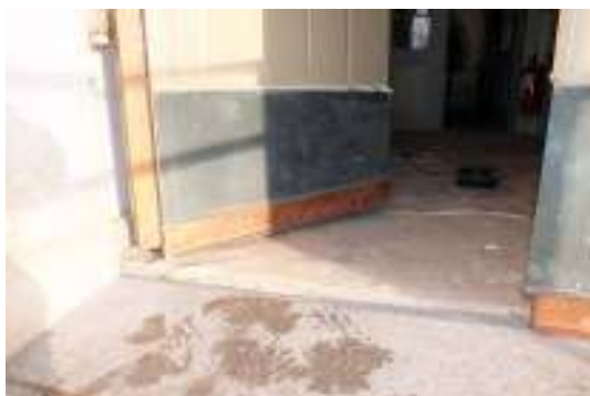
Dörrens sparkeplåt förlängdes med ny kopparplåt nedtill eftersom anslaget mot den gamla trappstenen var borta.
