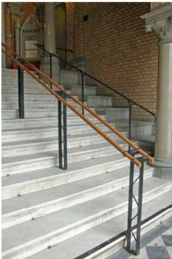
Nedre delen av trappan i västra trapphallen, före (ovan) och efter (nedan t v) montering av räcke. Nedan tb detalj av nedre delen av räcketts stolpar. Stolparna är fästa med bultar i hål i golvet och i trappstegen. Bultarna är numera svartmålade liksom stolparna i övrigt.
