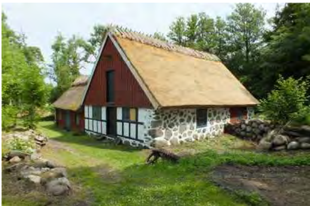
Takfallet efter omläggning.
