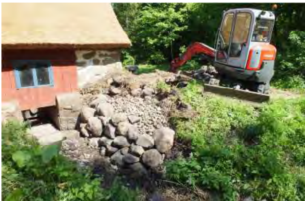
Bilden visar parti av muren uppströms kvarnen under det pågående arbetet med uppstapling av stenen.
