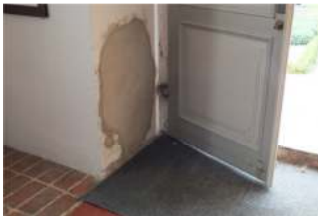
T.v Under arbetet upptäcktes en rötskada i kyrkans takstol som åtgärdades, det skedde även en stöld av kopparen på kyrkans absid. Detta lämnade en skada som fick åtgärdas provisoriskt. T.h I vapenhusets smyg gjordes även en lagning som sedan anvärgades med vit silikatfärg.
