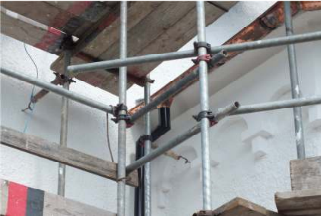
Efter att kyrkan utsatts för stöld ersattes kopparstuprören med stuprör i svart plåt.
