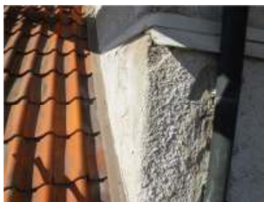
T.v I kyrkans cementsockel fanns det sprickor som behövde åtgärdas. T.h I arbetet ingick även att byta kyrkans stuprör och hängrännor.
