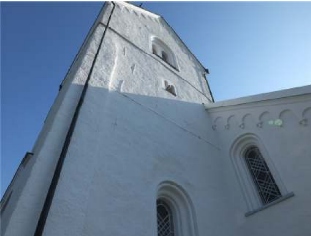
Kyrkans torn och fasad efter renoveringen.
