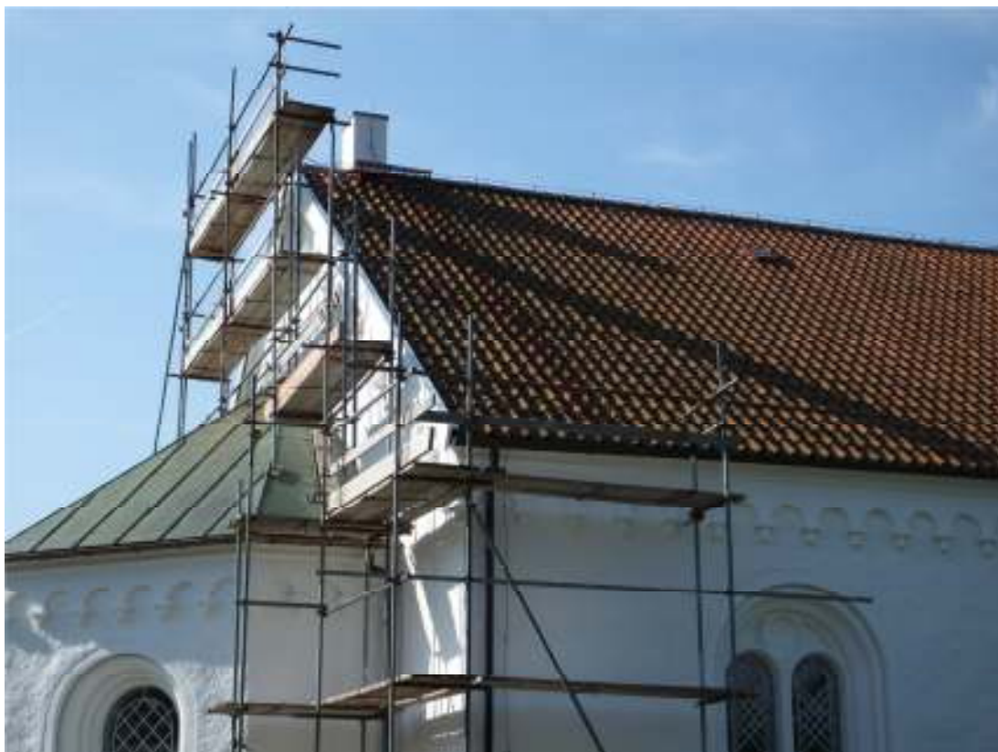
I samband med renovering anlades även en stegen med plattform på kyrkans tak för att öka tillgängligheten till skorstenen. Stegen och plattformen har en tegelröd kulör.
