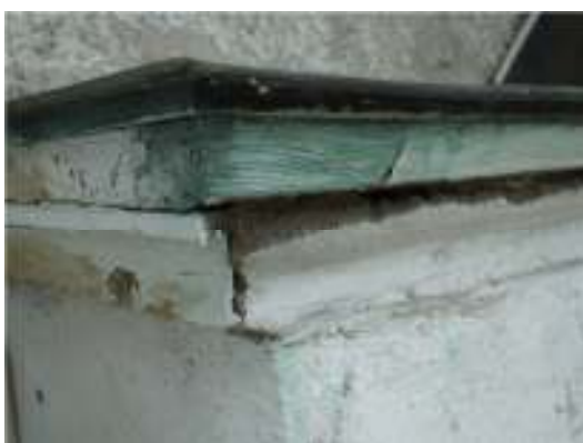
T.v I kyrkans cementsockel fanns det sprickor som behövde åtgärdas. T.h I arbetet ingick även att byta kyrkans stuprör och hängrännor.
