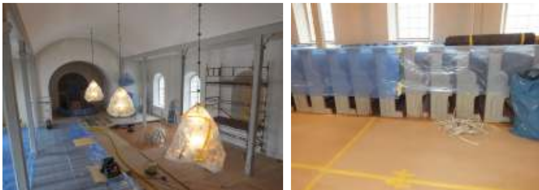
Övertäckningsarbete i kyrkan för att skydda kyrkans inredning.
