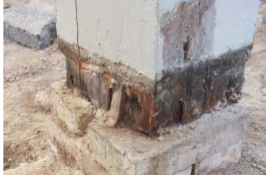
Detaljbilder från arbetet, t.v. upptagna golvplan från bänkkvarteret, t.h. blottlagd pelare i dåligt skick.
