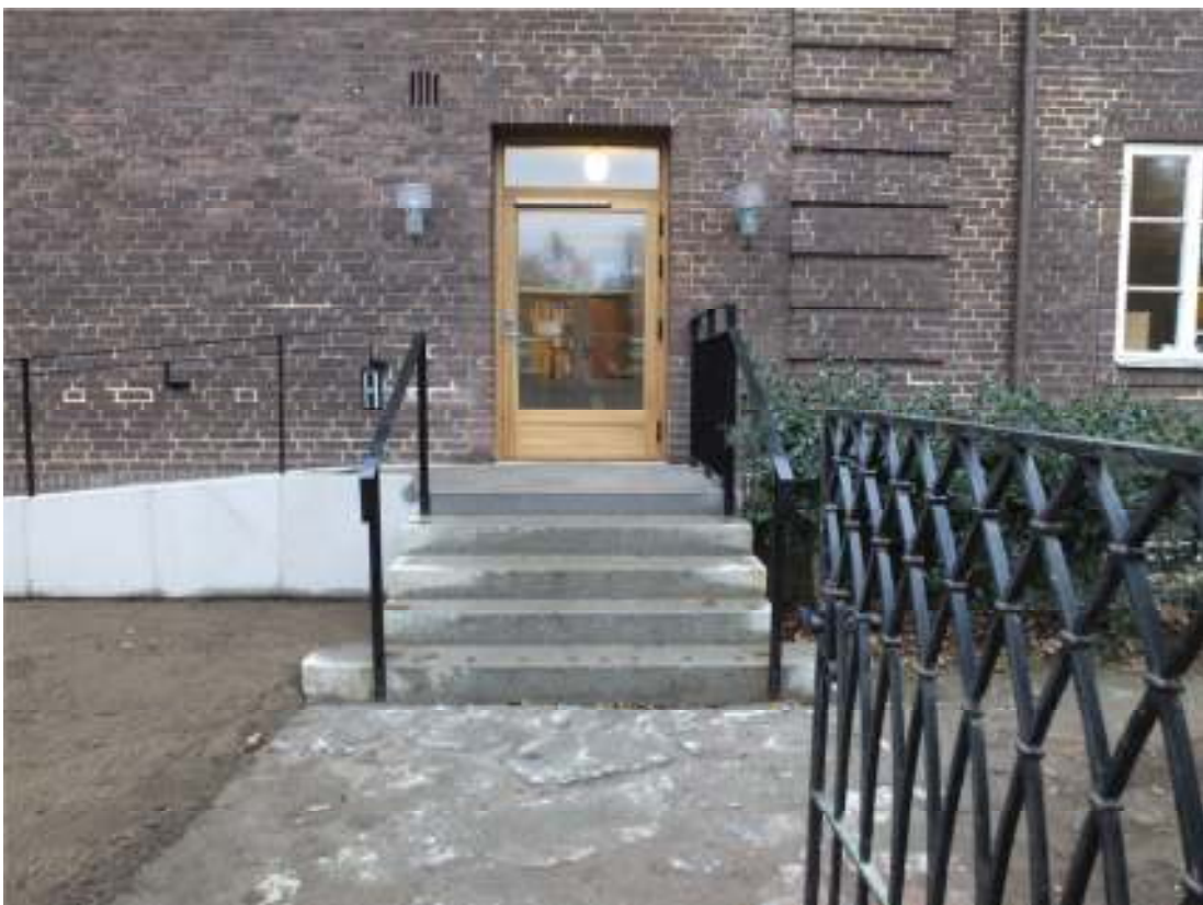
Entrén efter utförda åtgärder med ny dörr, ombyggd trappa, nytt räcke och ramp.
