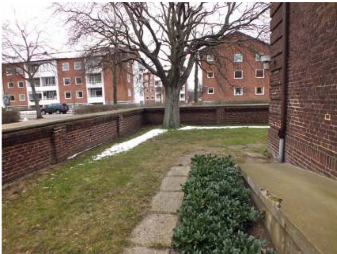
Vy från trappan mot nordöst i januari 2014 före åtgärderna utfördes.
