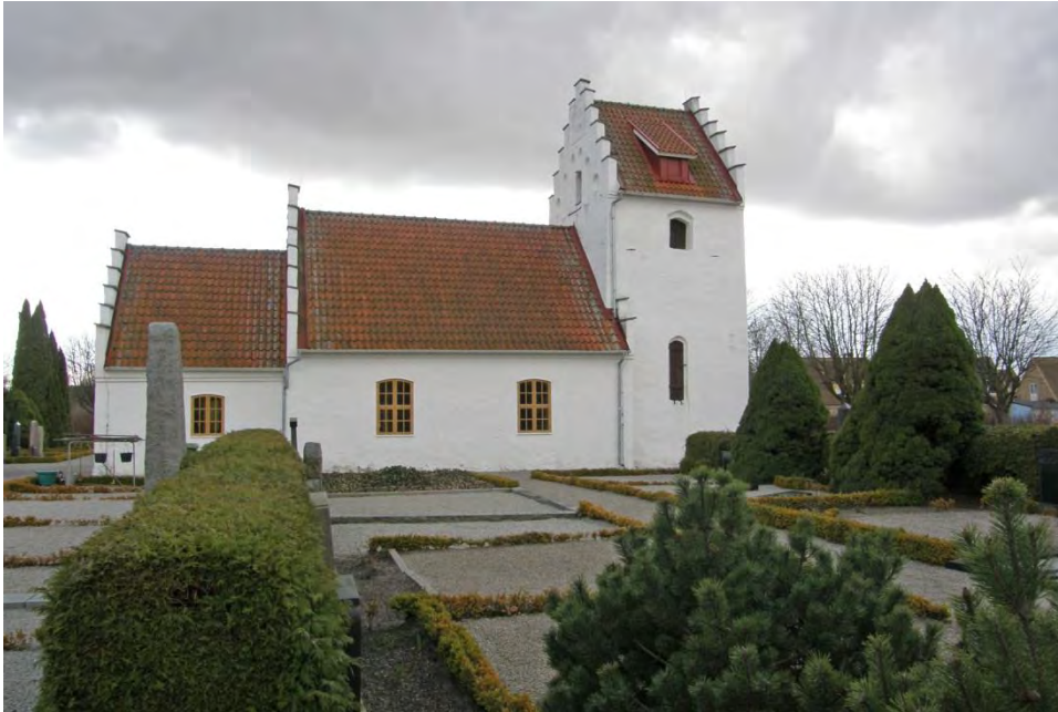
Revinge kyrka före montering av torntrappan. Vy från norr med tornet till höger i bild.
