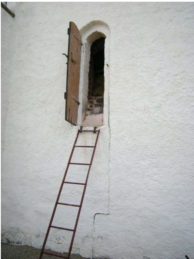
Tornluckan före montering av torntrappan. För att ta sig upp i tornet användes en enkel stege som bakades i ett par krokare som satt fast i muren.
