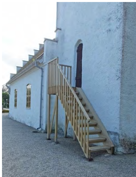
Tornluckan efter montering av torntrappan som är specialbyggd och anpassad för att fungera som en stabil trappa utan att göra åverkan på byggnaden. Tornet har därmed fått en förbättrad tillgänglighet.
