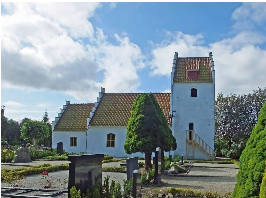
Revings kyrka efter montering av torntrappan. Vy från norr med tornet till höger i bild.
