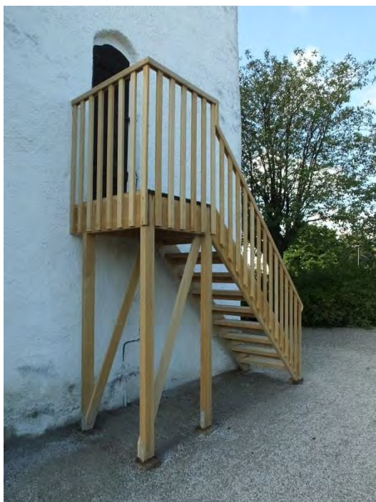
Tornluckan efter montering av torntrappan som är specialbyggd och anpassad för att fungera som en stabil trappa utan att göra åverkan på byggnaden. Tornet har därmed fått en förbättrad tillgänglighet.
