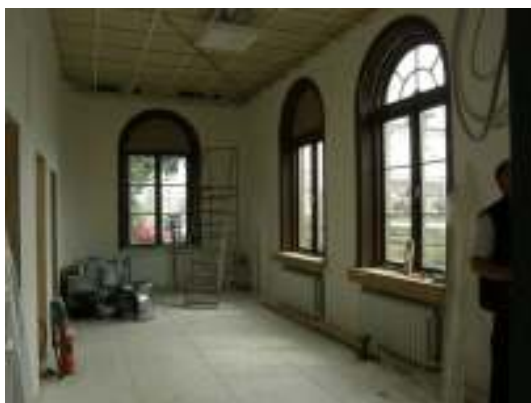
Fönsteröppningar i f.d. postkontorets östra del. Fönsterpartiernas översta båge återställdes där de varit igensatta. Till höger syns utrymmet efter renovering. En gammal lucka från godshanteringen har återanvänts som skärmvägg.
