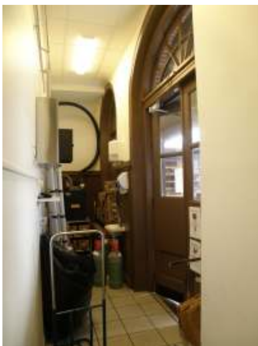
En skiljevägg mellan östra ytterväggen och restaurangköket bevarar ursprungliga öppningar intakta. Mellan det f.d. postkontoret och nuvarande restaurangköket togs en ny dörröppning upp i bärande stomme. Öppningen skymtar till vänster.
