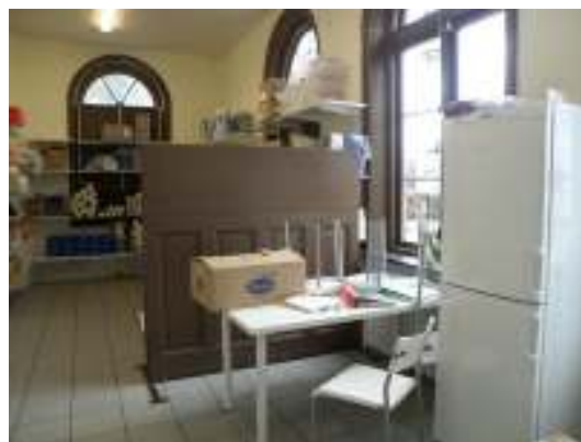
Fönsteröppningar i f.d. postkontorets östra del. Fönsterpartiernas översta båge återställdes där de varit igensatta. Till höger syns utrymmet efter renovering. En gammal lucka från godshanteringen har återanvänts som skärmvägg.
