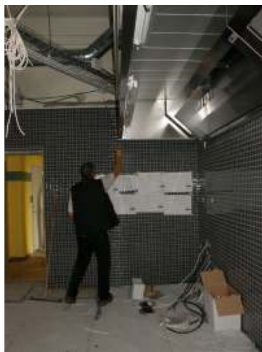
En skiljevägg mellan östra ytterväggen och restaurangköket bevarar ursprungliga öppningar intakta. Mellan det f.d. postkontoret och nuvarande restaurangköket togs en ny dörröppning upp i bärande stomme. Öppningen skymtar till vänster.
