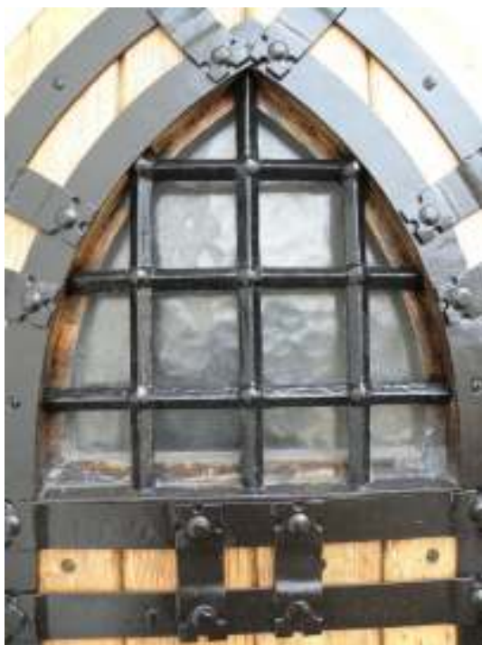
Norra torndörren före renovering (till vänster). Bilden till höger visar dörren efter infällning av ny bräda i nederkant där träet var murket.
