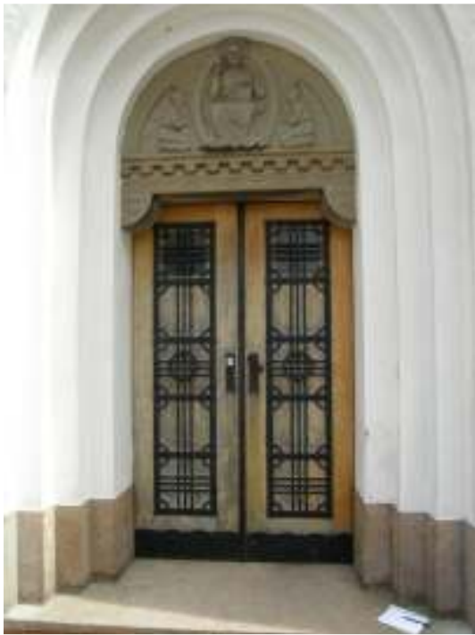
Västra porten före renovering. Beslagen togs ned, blåstrades och målades om. Till höger: Dekorativ bantagsring på västra porten märkt med datumet 19/12 1907. På baksidan av ringen fanns den diskreta märkningen Alfr. J. Rydahl Rydsgård.
