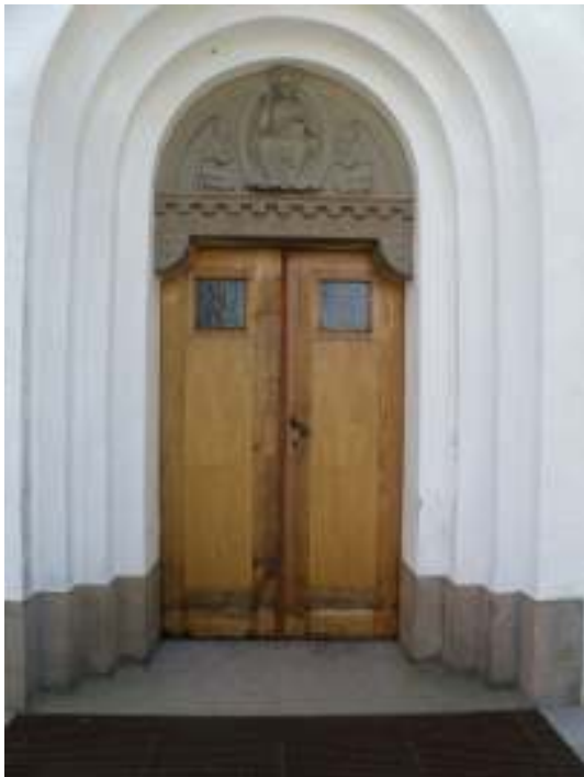
Västra torndörren skrapades ren, blektes med oxalsyra. Mittspeglarna av plywood byttes till nya skivor. Till höger syns dörren efter färdig renovering. Skrivhuvudena har inte målats ännu när bilden är tagen.
