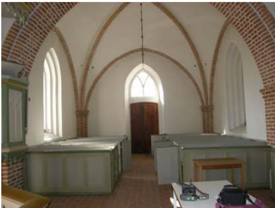
Södra korsarmen vid före arbetets början.
