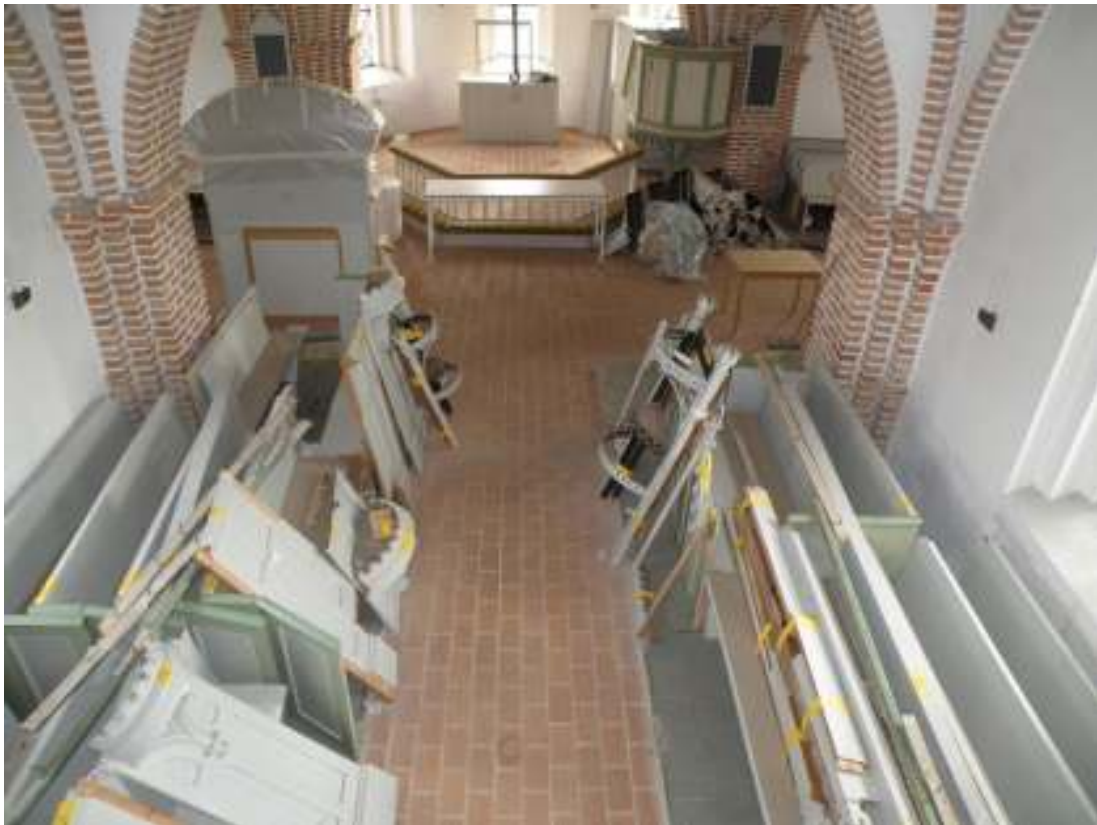
Kyrkan under demonteringsarbetet.
