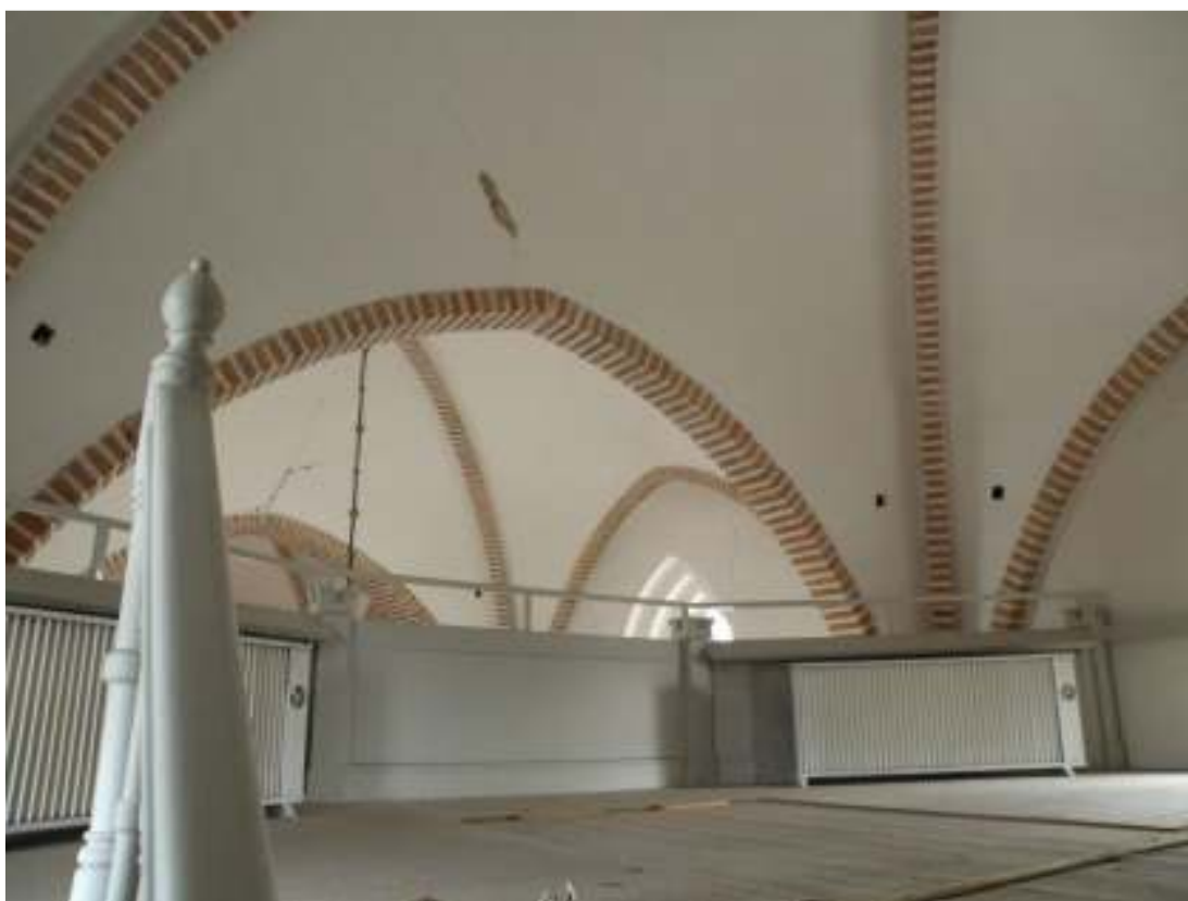
Läktaren efter borttagning av orgelfasaden.
