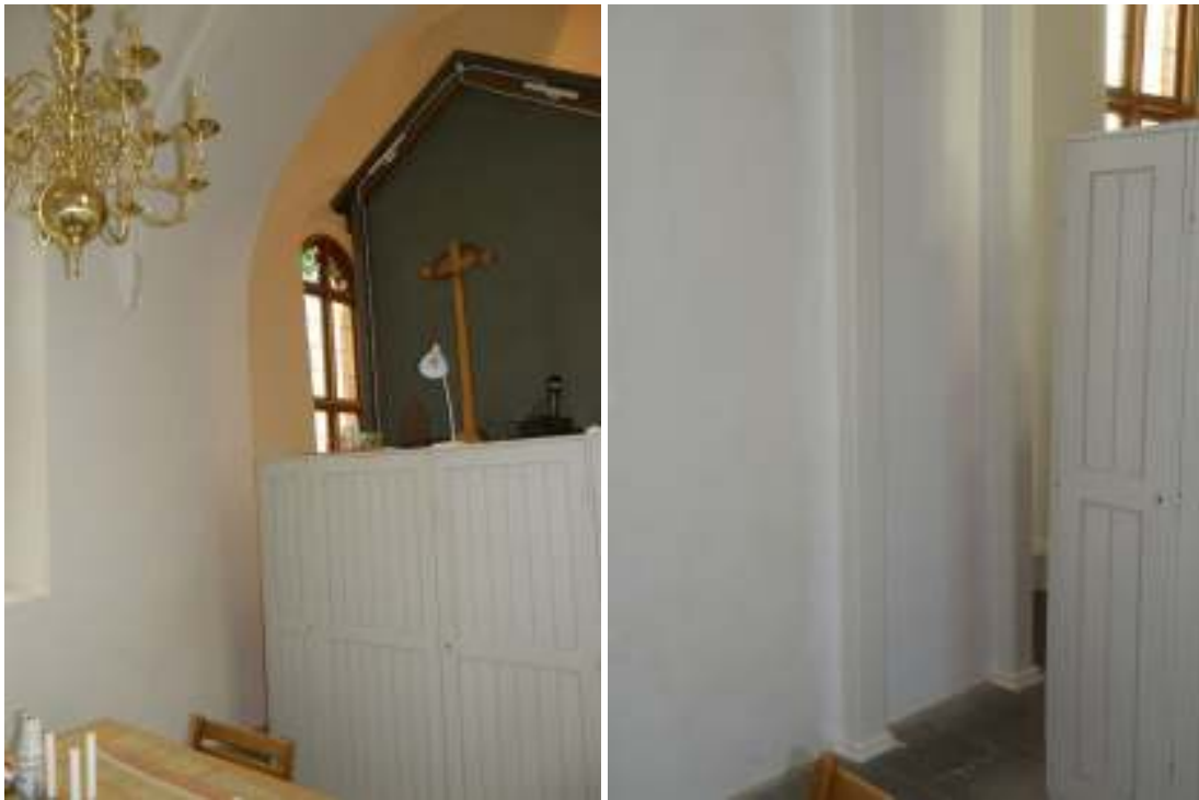
Valvöppningen mot söder före och efter (t.v.) förstärkningsbågarna.
