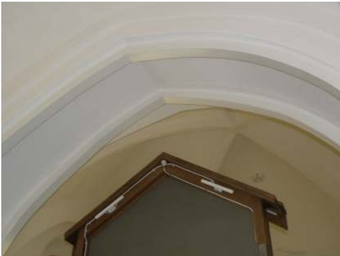
Valvspetsen med de nya järnbågarna infärgade och fogade.
