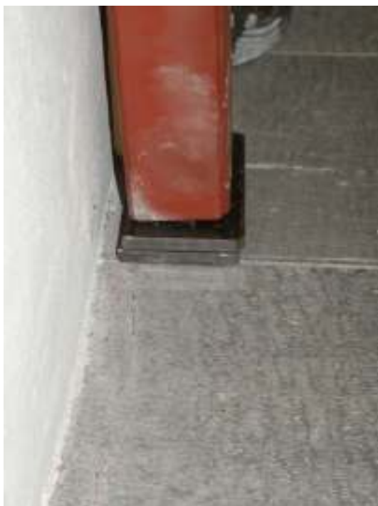
Järnbalkarna ställdes på stålbrickor. Till höger efter infärgning.
