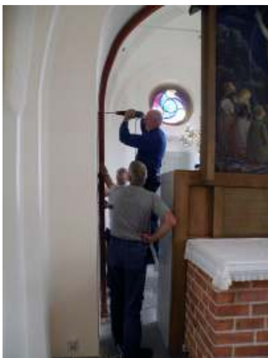
Järnbalken fästes med armeringsjärn i väggen. Till höger närbild av den färdigmålade och fogade balken mot sidomuren.
