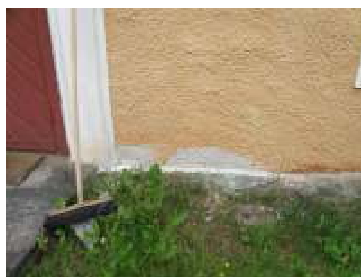
Mindre skador söder om ytterdörren lagade.
