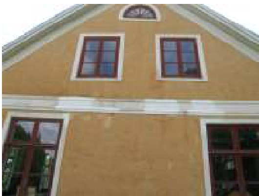
Skadorna på norra gaveln åtgärdade.
