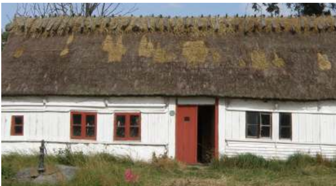
Omfattningen av taklagningsarbeten. Notera de synliga rafterna.
