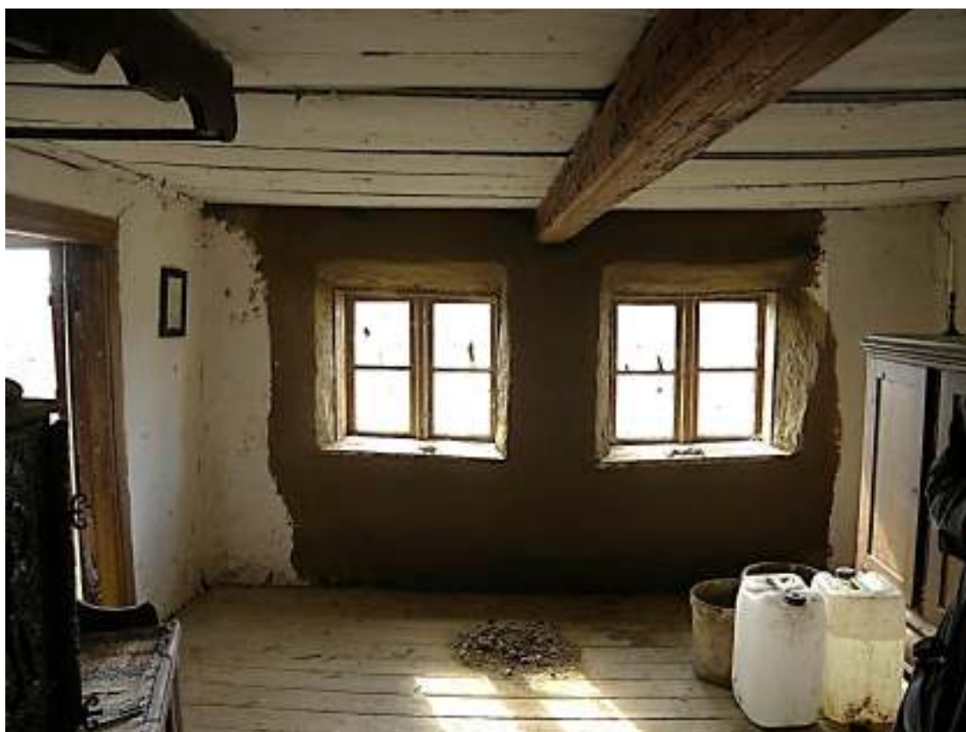
Omfattningen av utförda åtgärder på stuans södervägg.
