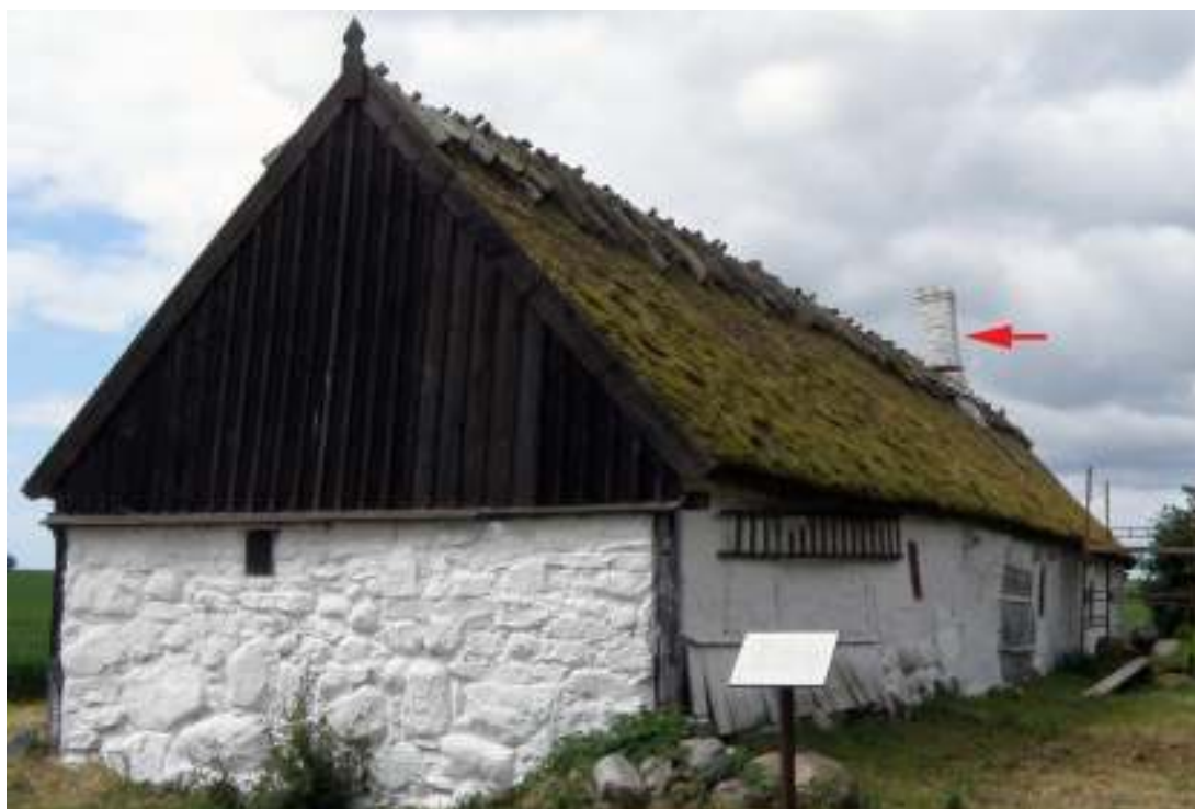
Örumshuset innan arbetet. Notera skorstenen.
