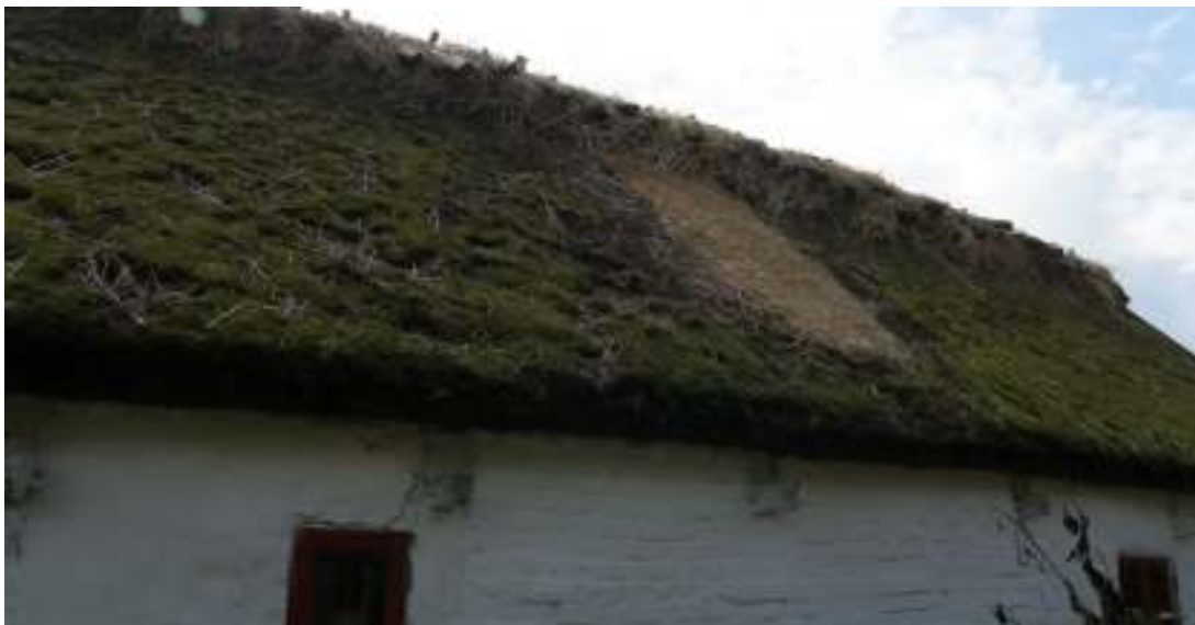
Igentäppning av hålet efter skorstenen.
