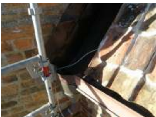
Nytt skvalpskydd vid sydöstra tornet.
