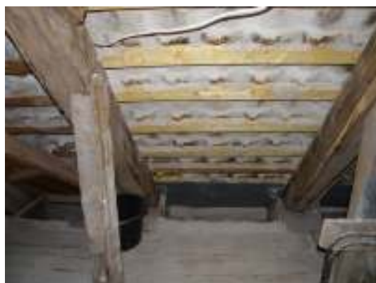
Exempel på understrykning och nya läkter.
