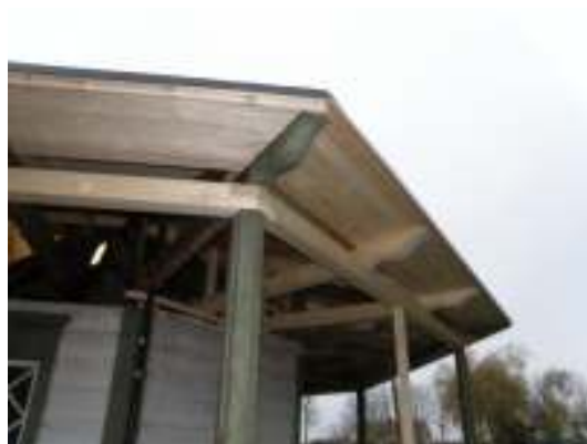
Ny takfotspanel, yttre lejder och tassar.
