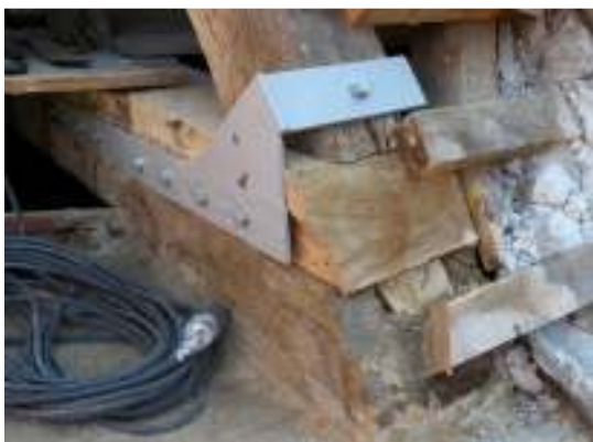
Ex. på fästning av sparre (vid frontespisen)
