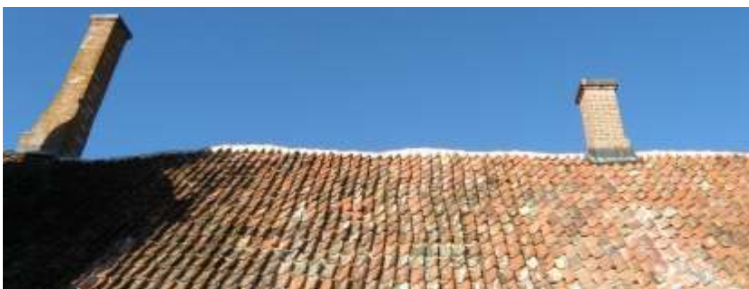
Östra takfallet, nockpannor monterade.
