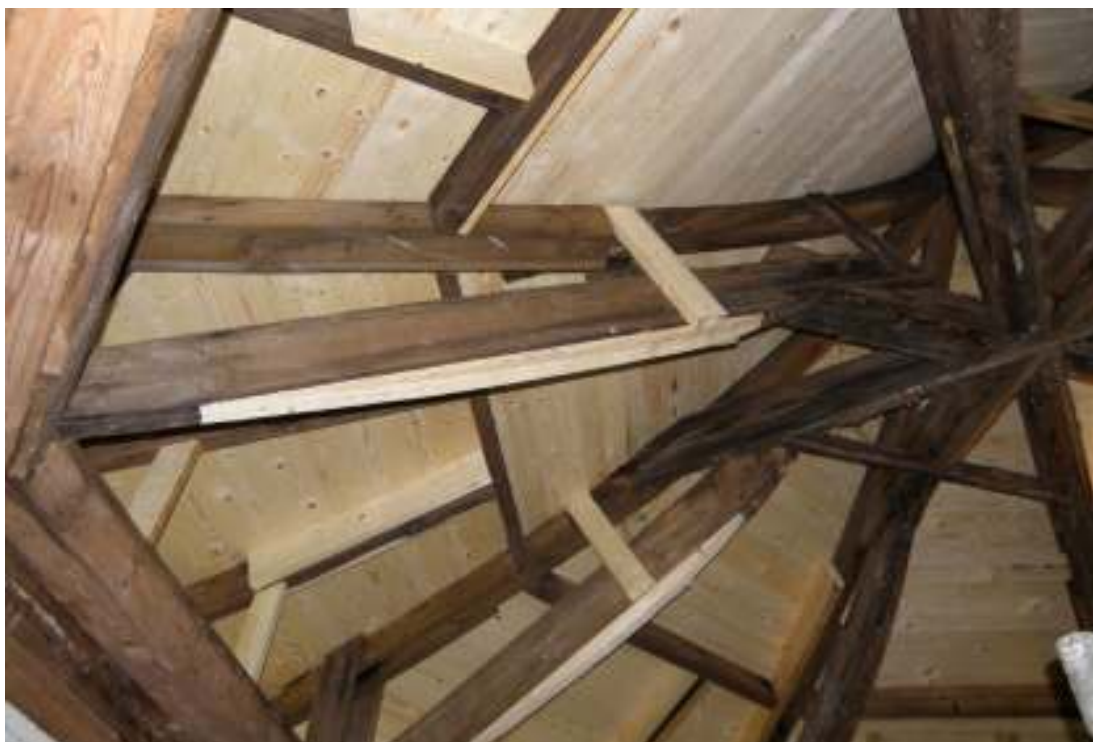
Exempel på bytta delar i takkonstruktionen samt ny underbrädning.
