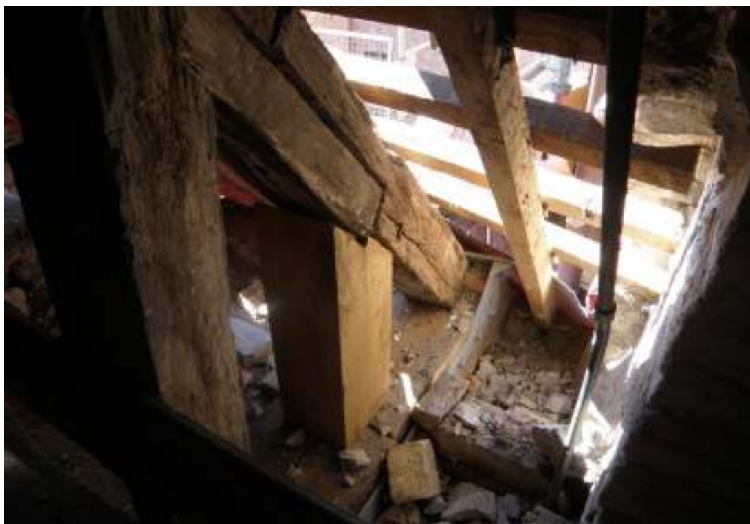
Skarvad sparre, västra takfallet, invid borggårdens torn.
