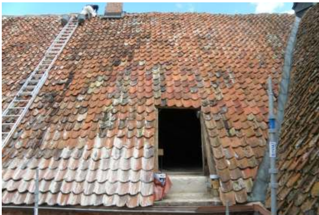
På västra takfallet togs tillfälligtvis ett hål upp för att underlätta arbetet.
