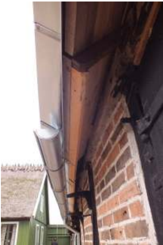
Läktena förstärktes för krokarna till hängrännor, t v. Över porten t h sattes fotränna i stället för hängränna.
