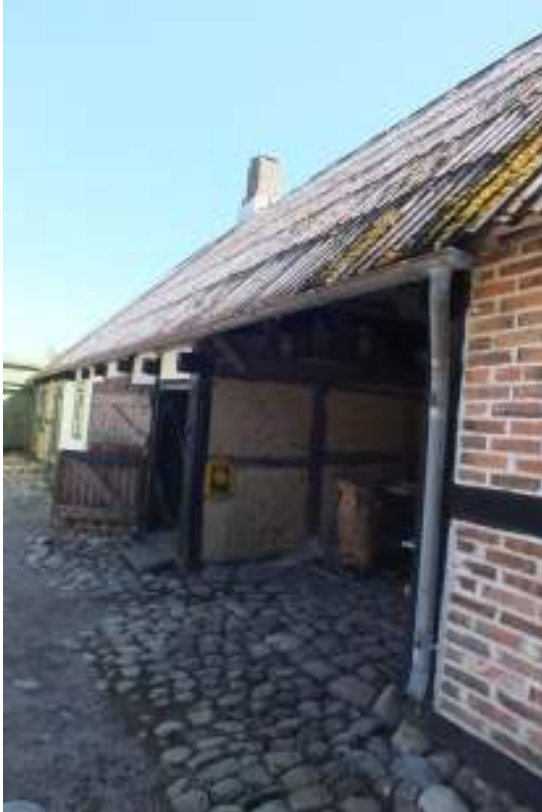
Brygghus- och loglängans avvattning byttes och förlängdes med ny hängränna och nya stuprör längs hela sidan.
