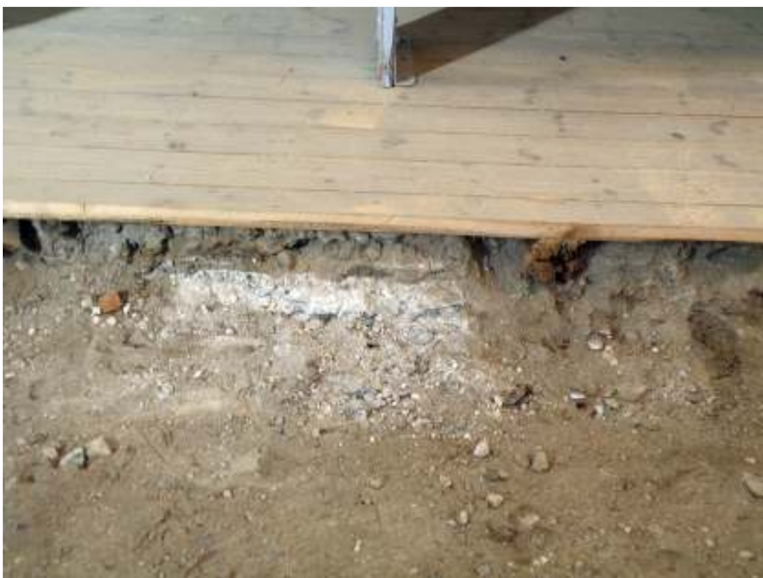
På södra sidan syntes följande skikt mot väster vilket kan utgöra en rest av den medeltida södra långhusmuren.
