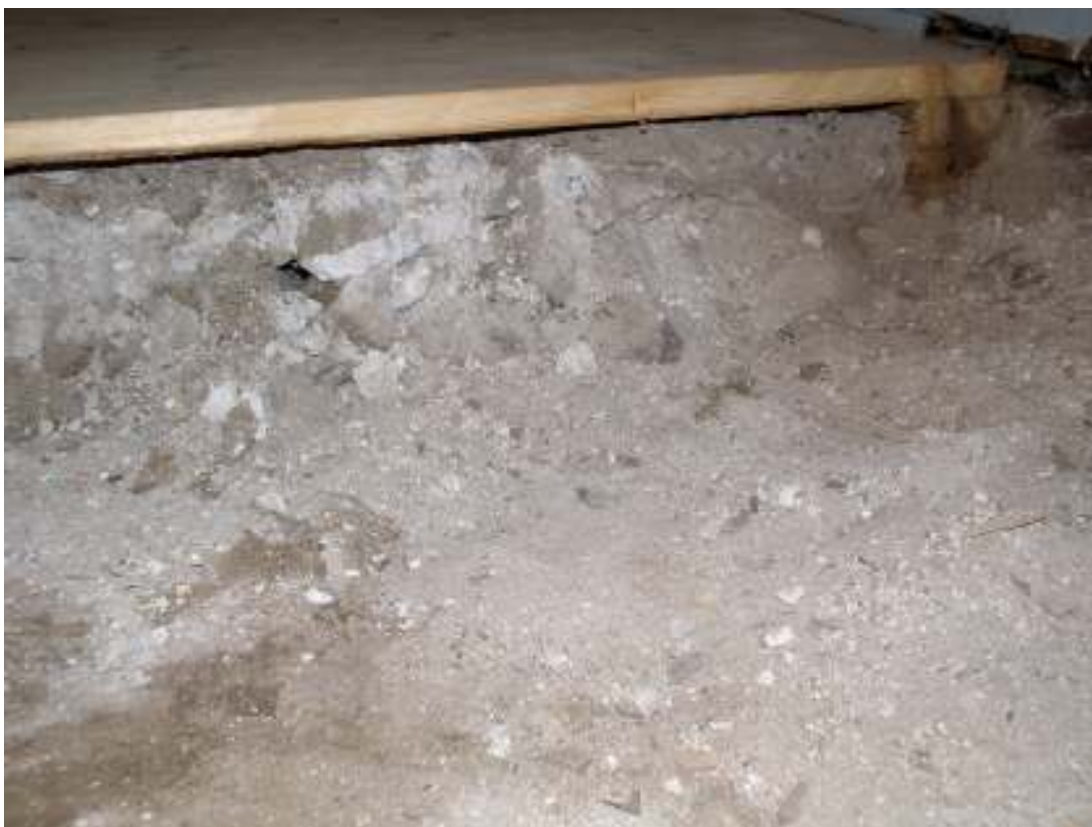
Bild som visar golvfyllningen på norra bänkkvarteret sett mot väster och kvarvarande bänkrad. Ett murskikt kan anas som går in under bänkgolvet.
