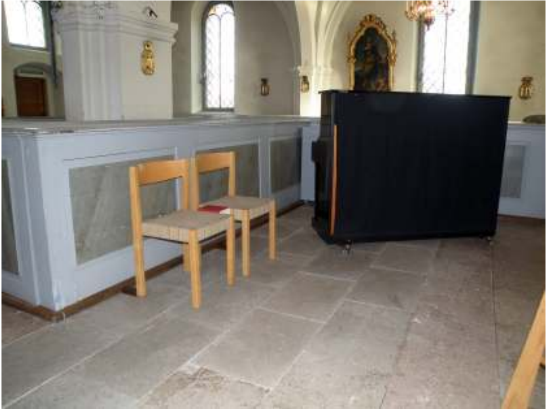
Norra sidan om mittgången och det nylagda golvet vid platsen för den borttagna bänken.
