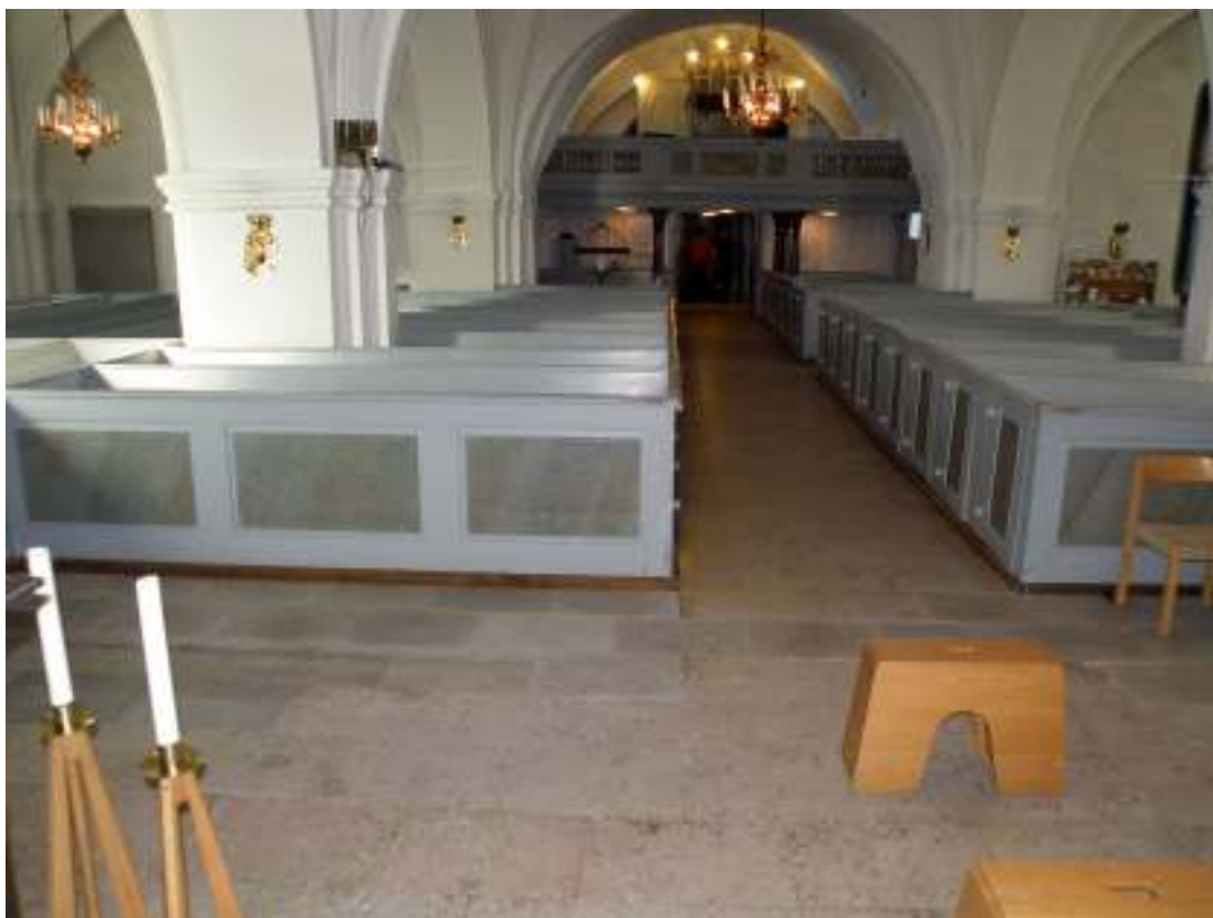
Långhusets främre del efter utförda åtgärder.
