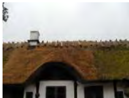
Samma parti efter åtgärd med ny strätäckning.
