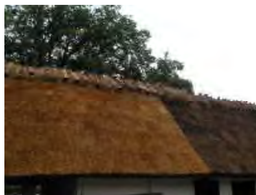
Samma ställe efter omläggning av strätaket.
