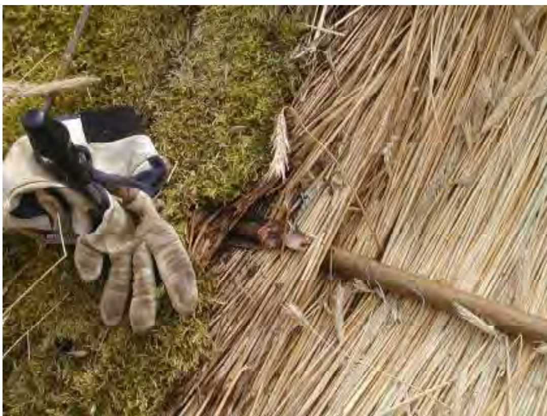
Vid mosskanten t.v. ses en tvinnad ståltråd av grövre slag och t.h. ses den tunnare sortens ståltråd som sitter fast i en skruv vilken skruvas fast i raften och tvinnas runt hasselkäggen.
