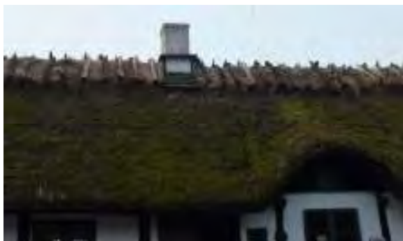
Boningshusets södra takfall med homejan före arbetet.
