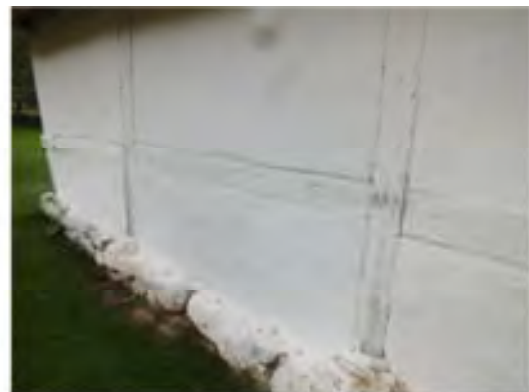
Samma ställe efter lagning av lerklinat fack
