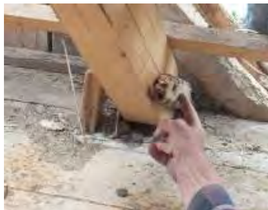
Stället där delen av avhasaren var fäst på sparren intill homejan.
