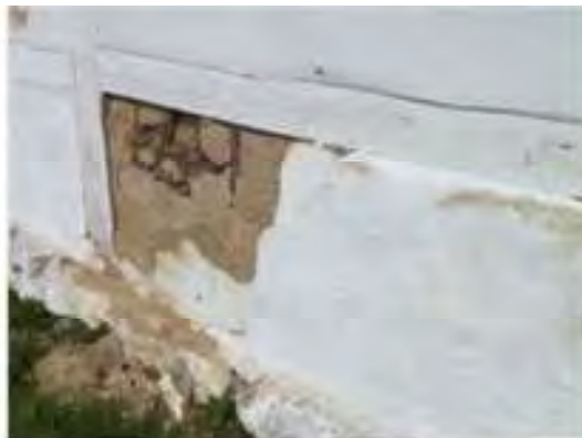
Boningshusets sydfasad före lagning
