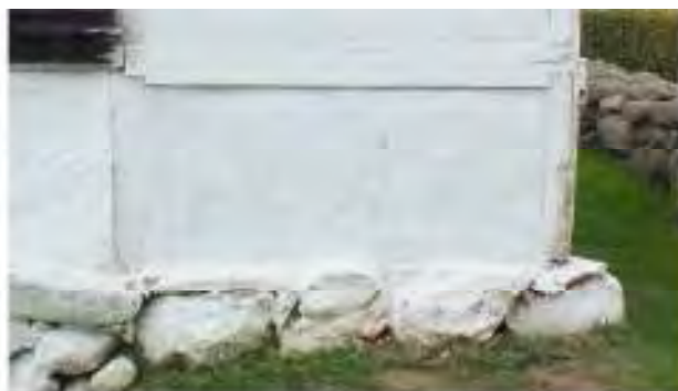
Samma ställe efter lagning av lerklädat fack.
