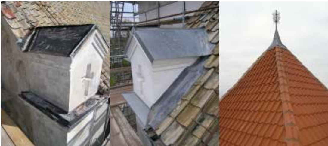
På bilden till vänster visas en av lisenernas fialer med plåtavtäckning före renoveringen. På bilden i mitten visas fialens avtäckning och blytäckning för vattenavledning efter renovering. Längst till höger syns torntaket efter renovering med krönkors och blyplåtskerön på plats.
