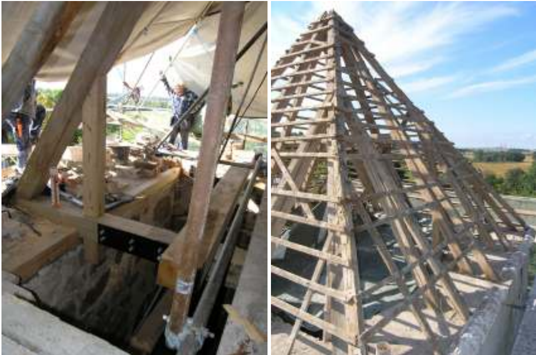
Till vänster: skadat stomvirke på tornet byttes till nytt virke. Fyra sparrar byttes i sin helhet och i övrigt lagades virket genom skarvning. Bilden till höger visar torntaklaget före renovering med äldre kvarvarande läkt.
