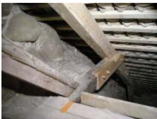
Lagd takstol på långhusvindens östra sida. På högra bilden visas långhusvinden sedd från väster.
