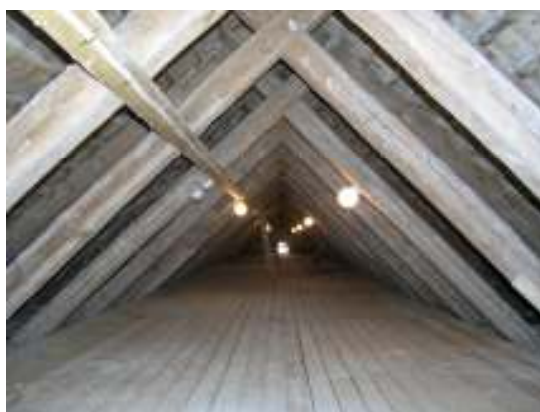
Lagd takstol på långhusvindens östra sida. På högra bilden visas långhusvinden sedd från väster.
