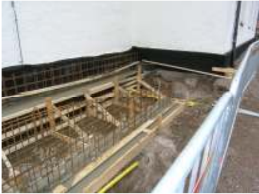
Gjutning av rampens stödmurar.
