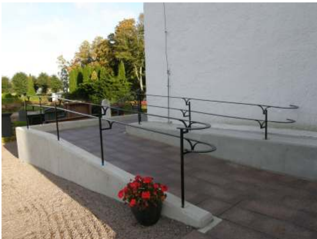
Färdig ramp sett från uppgången, tornets södra sida.
