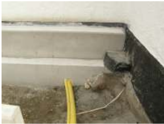
Rör för ledningar drogs genom pågjutning, genom tornmur in till tornets bottenvåning. Till vänster syns ingången för tomrör i tornets bottenvåning södra väggen, under torntappen.
