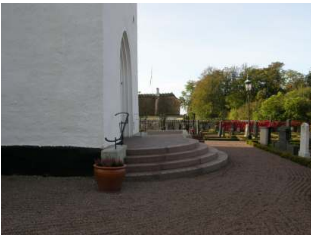
Den nya torntrappan med plats för bl.a. rullstolar att vända på.
