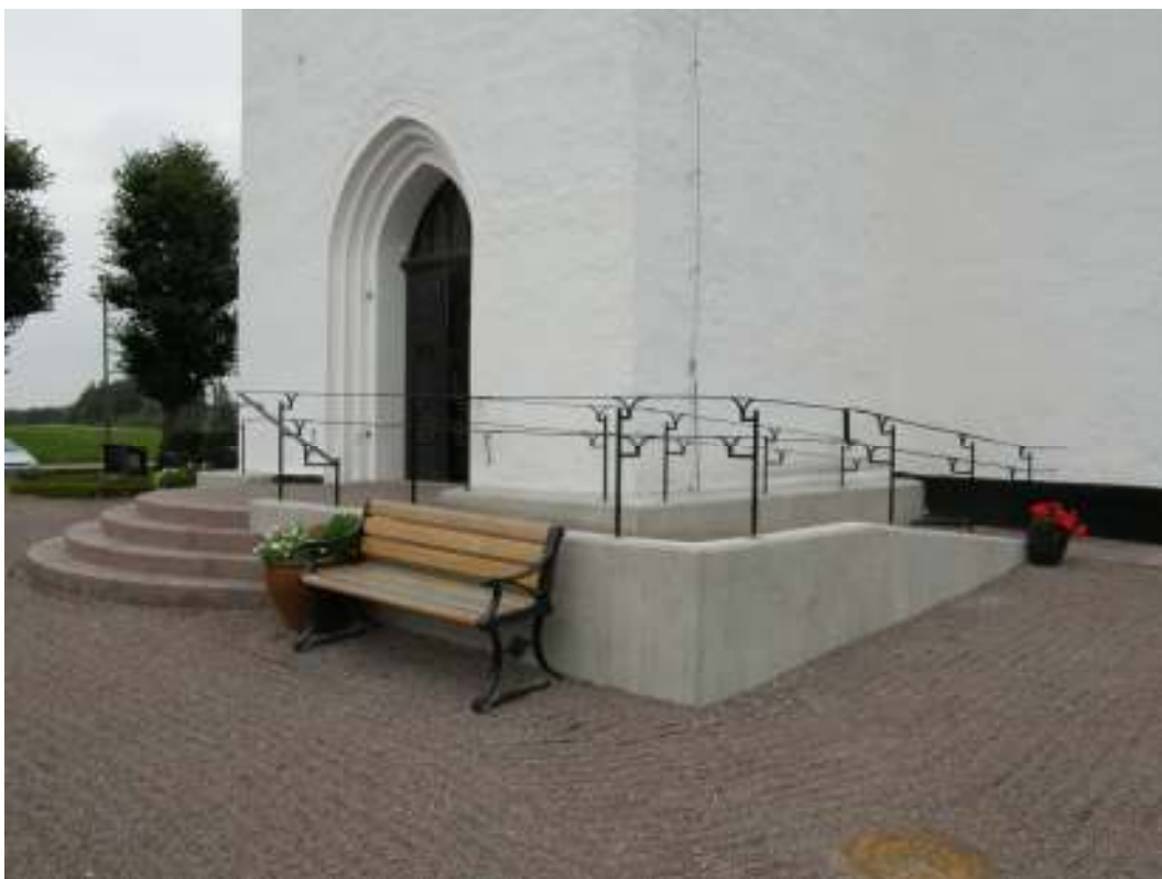
Ny ramp och trappa sett från sydväst.
