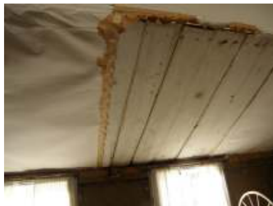
Fig. 7. Takbrädorna återmonterade.
