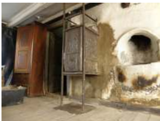
Fig. 4. Lagning i anslutning till sättugnen.
