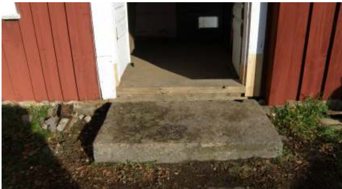
Fig. 1. Ytterdörren efter arbetet.
