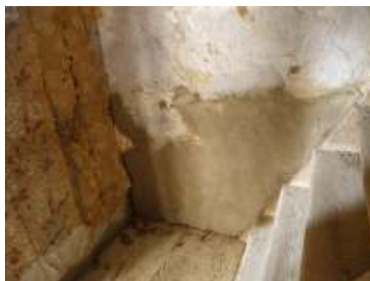
Fig. 5. Lagning vid trappan bakom illaren.
