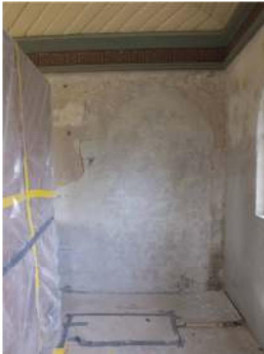
Bilderna visar väggytorna när puts-skikten delvis rivits. Vänstra raden ovanifrån och ner: den södra korsarmen, södra delen av långhuset, sakristians vägg åt väster samt del av underliggande ytskikt i sakristian. Högst upp till höger har lös puts knackats bort och underliggande kulörer framkommit i södra korsarmens fönsternischer. Nedre bilden till höger visar en av sakristians väggar efter rivning av ytskikt.
