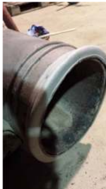
Kolonnen på verkstaden, efter blästring har den grundmålats både invändigt och utvändigt. Den nedre bilden till höger visar kolonnens överdel där kapitälet ansluts. Foto: Lars Svensson.
