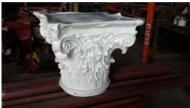
Kolonnen återmonterad och målning pågår. På rad två till böger bortas de gamla järndubbarna ur för att ge plats åt nya, rostfria. Längs ner syns kapitälet efter renovering och målning. Locket av blyplåt har vikts runt kapitälets topp för att hålla tätt. Foto: Lars Svensson.
