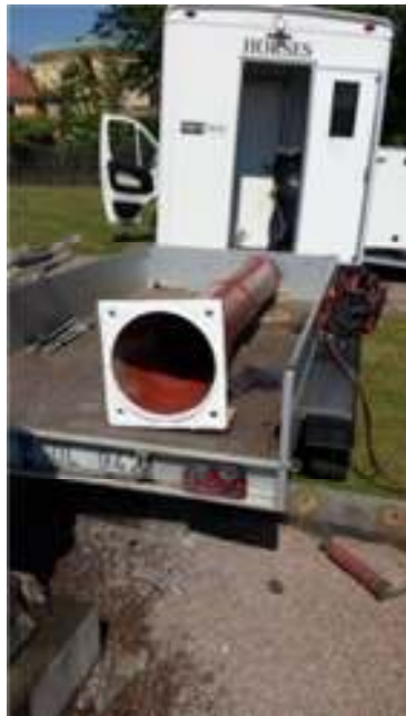
Kolonnen på verkstaden, efter blästring har den grundmålats både invändigt och utvändigt. Den nedre bilden till höger visar kolonnens överdel där kapitälet ansluts. Foto: Lars Svensson.
