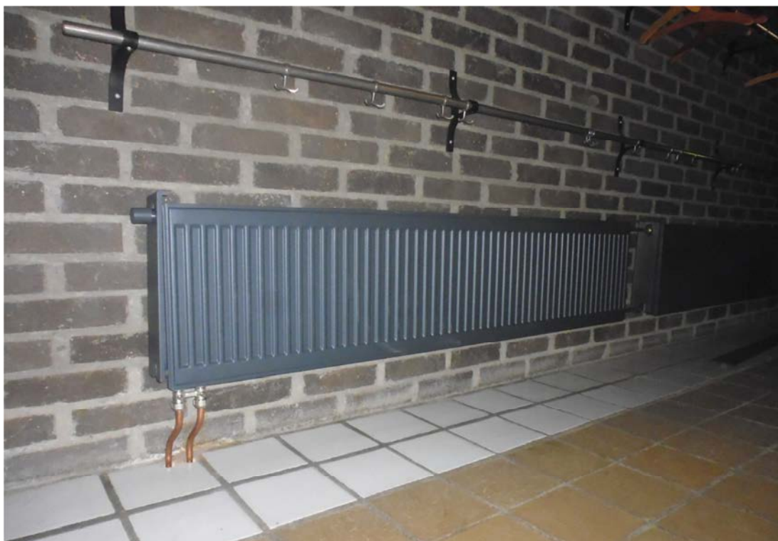
Radiatorerna enligt ovan, med avtagen plåtbeklädnad.
