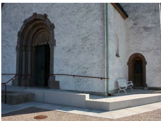
Bild t.v. Det nya rampområdet anläggs på sydvästra sidan om kyrkan. T.h. De mörkare delarna är stenar som återanvänts från den gamla trappan. De ljusare är den nya stenen som kommer mörkna något med tiden.
