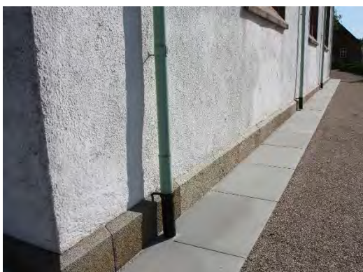
Bild t.v. Delar av de gamla stenplattorna ersattes med nya då de gamla inte kunde justeras på ett bra sätt. Plattorna har gjorts i samma dimension som de gamla. Bild t.h. Närmare bild på ett av de nya räcken som gjorts med inspiration från de gamla.
