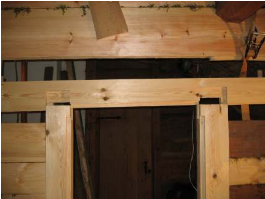
Bild 16 Lycketräets anslutning till gåtarna.
