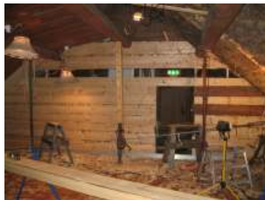
Bild 14 Lycketräet på plats för att markera för dörrgåtarna.
