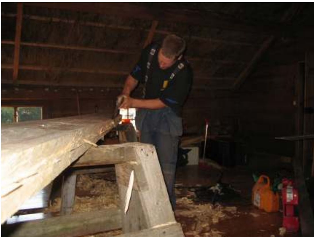
Bild 9 Mejhuggning av båle till mellanväggen.
