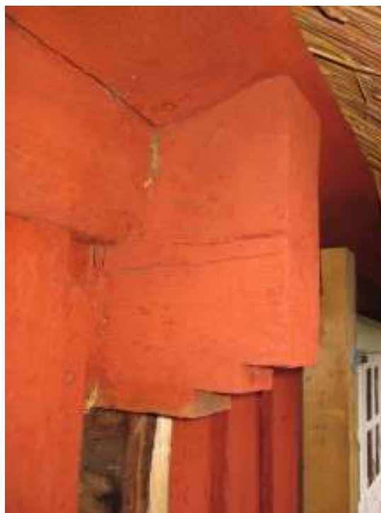
Bild 6 Översta knutskallen som stöder hofsbrädan samt har en två droppnäsor.
