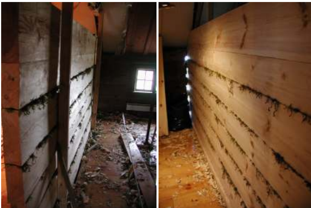
Bilderna visa snedningen av den norra vägghalvan.
