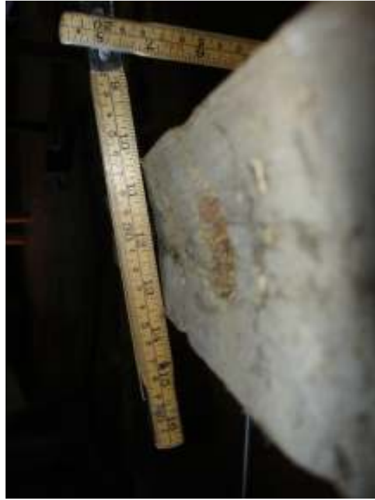
Bild 2 Originalbåles extremt flackt mejdrag.
