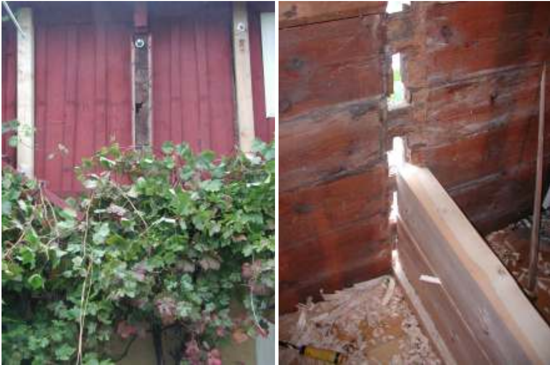
Till vänster syns knutskallarna efter den tidigare väggen i den södra fasaden. Till höger har upptimringen av innerväggen påbörjats.
