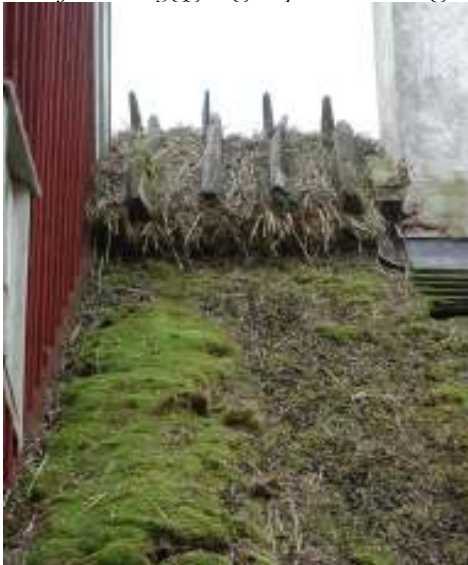
Ny rygging respektive ilagning i taksägget på den lägre byggnadsdelen i väster.
