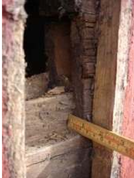
Bild 4 Hål efter utknut. Lägga märke till dikthålet. Mossan är avlägsnad för att det ska synas tydligare.
