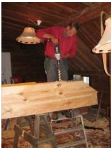
Bild 10 Dymlingshålsborrning på modernt vis.
