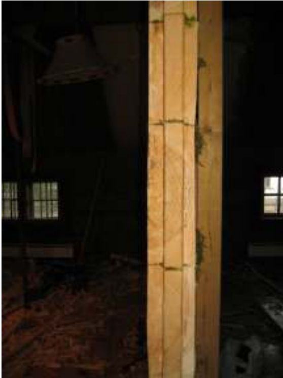
Bild 15 Fjädern som ska ansluta till gåtarna. Notera de flacka mejdragen.
