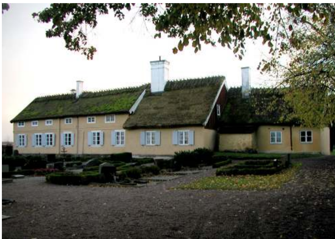
Norra fasaden med omlagt tak på den mellersta delen av byggnaden.
