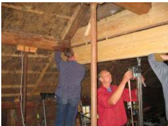
Bild 11 Montering av den andra bålen.
