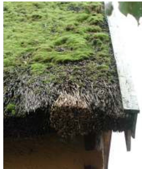
Ny rygging respektive ilagning i taksägget på den lägre byggnadsdelen i väster.
