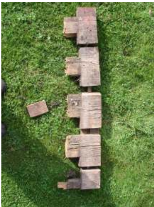
Bild 5 Södra sidans nerplockade knutkedja. Notera dymlingarna.
