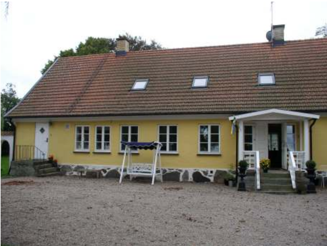
Kastanjegården, boningshuset. Notera takfönstren samt fasadens något oregelbundna fönstersättning. Fönstren tillhörande salen är de tre närmast förstukvisten.
