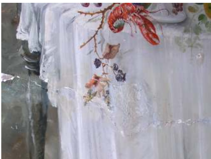
Parti av väggmålningen med den ojämna och grova lagningen. Sprickan löper diagonalt över väggen på ömse sidor och har troligtvis uppkommit av det rör som tidigare varit placerat rakt genom väggen, från köket och bakugnen till ytterligare en värmekälla i salen.
