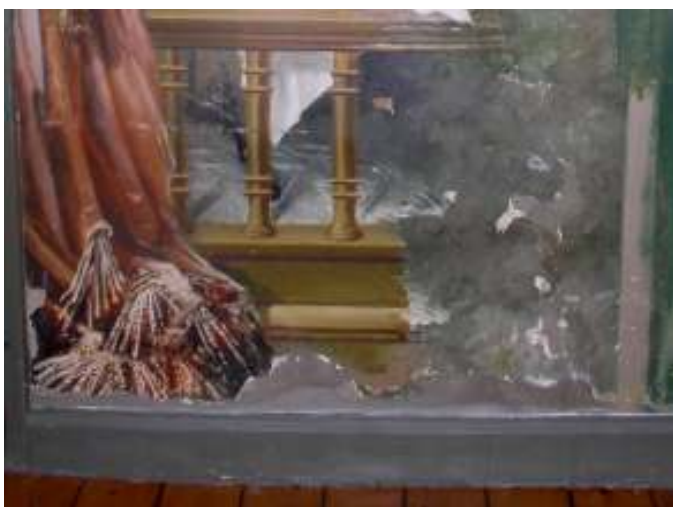
T.v. Målningens nedre parti, med tidigare lagningar utförda i cementhaltigt kalkbruk. Notera även det övermålade partiet av motivet till höger. T.h. Parti av målningens övre hörn, i anslutning till nischen, med en äldre ojämn lagning.
