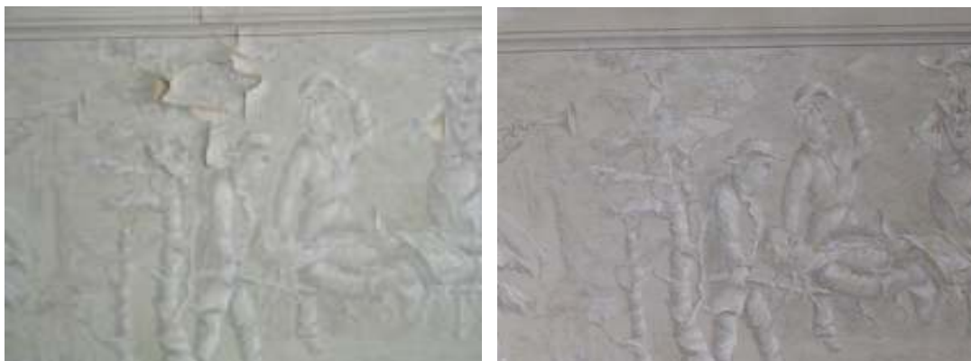
T.v. Parti av frisen i salens sydvästra hörn med omfattande färgresning och färgsläpp. T.h. Samma parti efter konsolidering och lätt retuschering.
