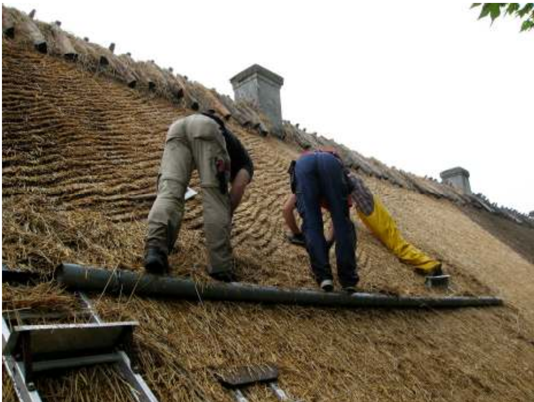
Sydöstra stiet. Ryggningen är på plats och taket skärs
