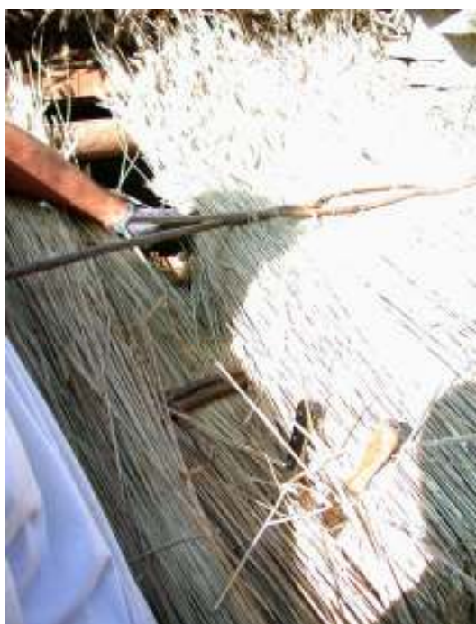
Det sydvästra stiet med vass bortrivet och täckning med halm påbörjat. Foto: Mikael Andersén
