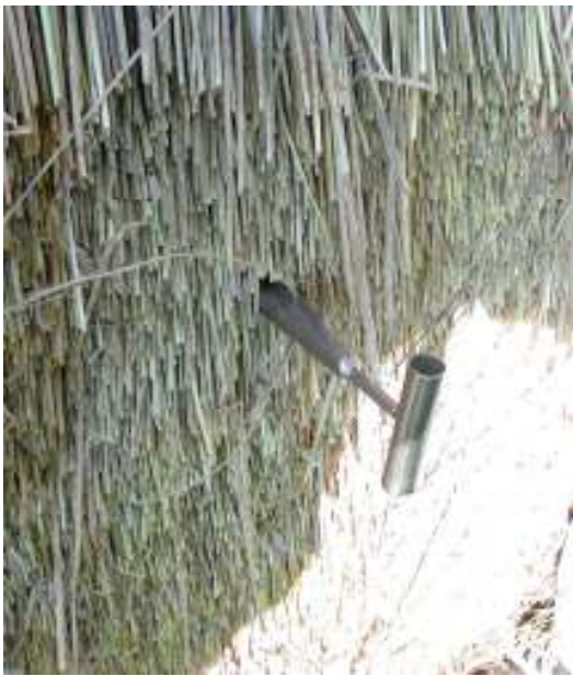
Sydöstra stiet. Tjockleken kontrolleras. Upppe vid nocken binds dubbla räfter för att tåla påfrestningarna. De utskjutande stråna binds sedan över nock
