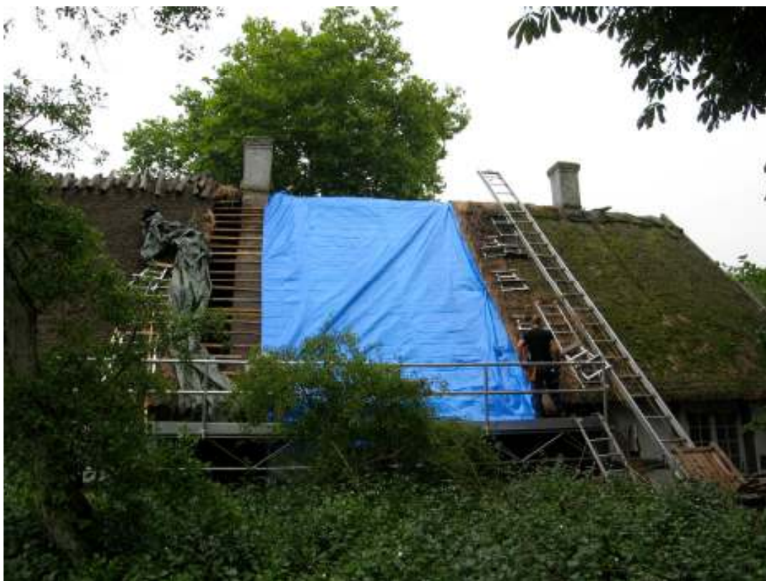
Det sydvästra stiet med vass bortrivet och täckning med halm påbörjat. Foto: Mikael Andersén
