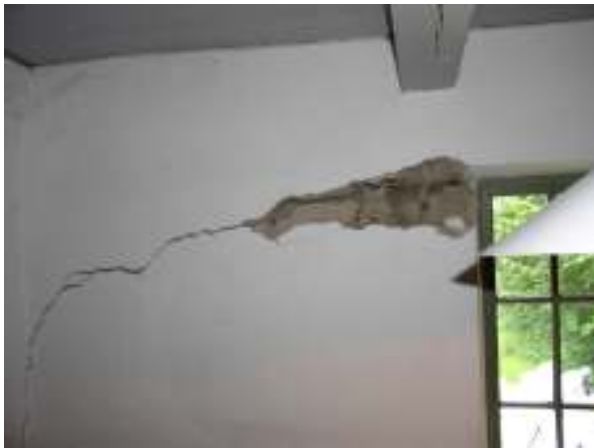
Serveringsrummets östra vägg. Kraftig sprickbildning, det inre facket av lertegel är på väg att släppa från det yttre.. Foto: författaren
