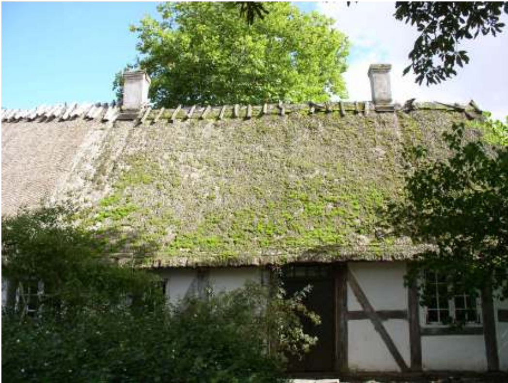
Sydvästra takfallet med vasstäckning före omläggning till balm. Foto: författaren
