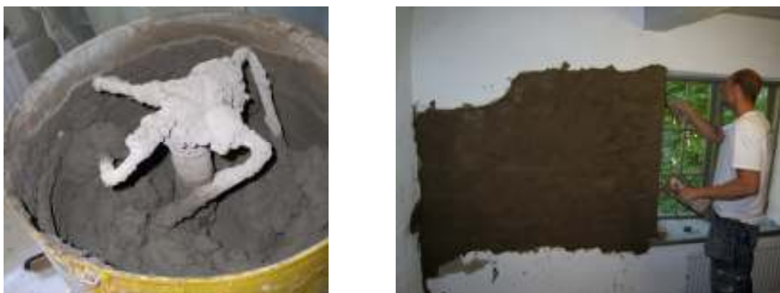
Serveringsrummets östra vägg. Lerputsbruk tillverkades på plats. Befintligt lerputsbruk och söndriga lertegel togs tillvara och nytt lerputsbruk tillverkades. Ca 1 cm tjock lerputs slevdrogs på väggen,
