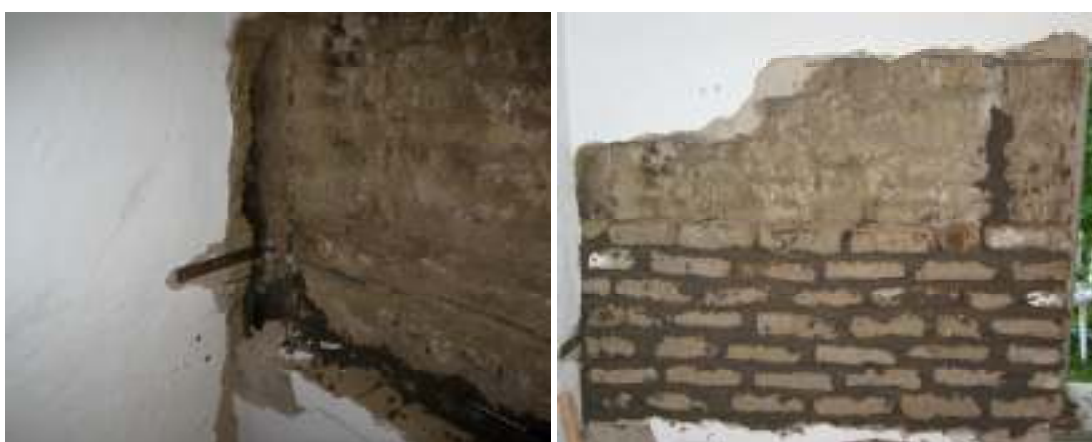
Serveringsrummets östra vägg. Ca 2 x 1,5 m av lerteglet nertaget, varefter återmurning med gammalt tegel skedde som kompletterades med ca 20 nya lertegel.
