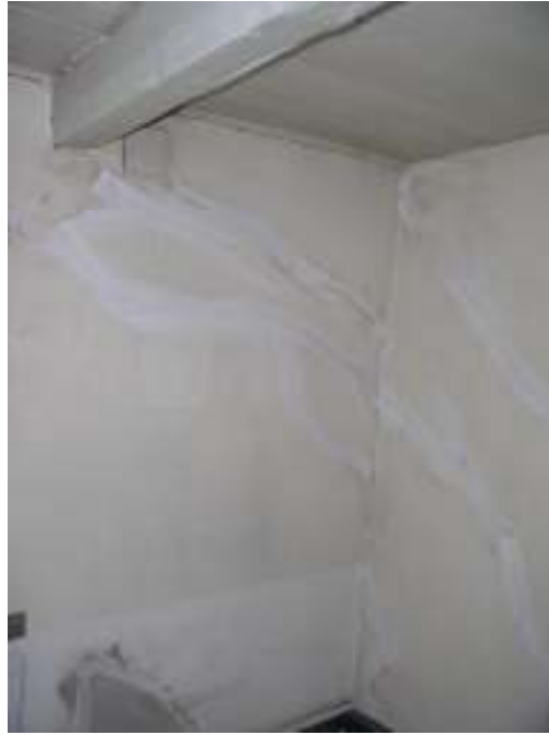
Serveringsrummets östra vägg. Skarvar tilljämnades och lerputsen fick torka. På lilla salens östra vägg ifylldes sprickor med nytt lerbruk, varefter de kalkavfärgades.
