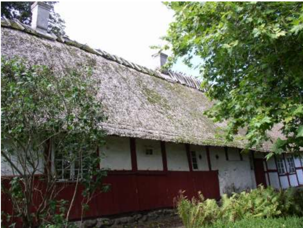
Sydöstra takfallet med vasstäckning före omläggning till balm. Foto: författaren
