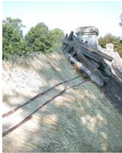
Sydöstra stiet. Tjockleken kontrolleras. Upppe vid nocken binds dubbla räfter för att tåla påfrestningarna. De utskjutande stråna binds sedan över nock
