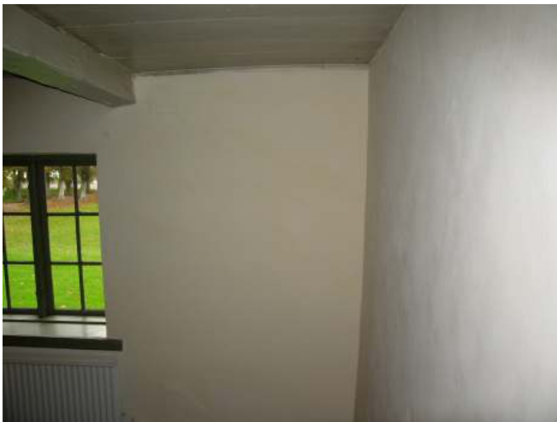
Lilla salens östra vägg efter det att väggytorna kring de lagade sprickbildningarna anvärgats med kalkfärg.
