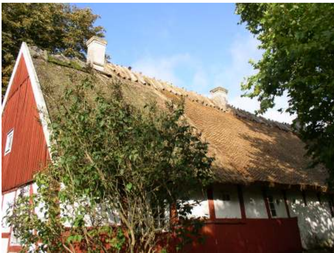
Sydöstra takfallet efter omläggning. Tv gavelsti med vasstäckning som kommer att läggas om till halm 2007.
