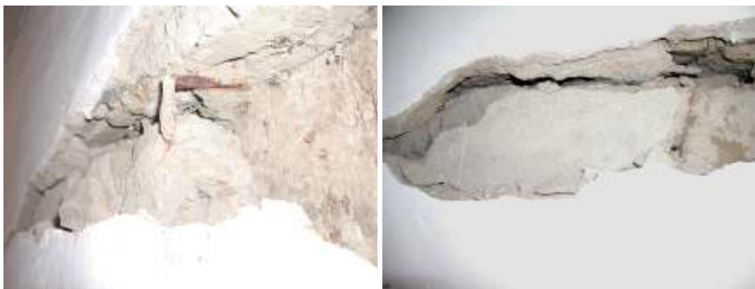
Serveringsrummets östra vägg. Små L-formade ankarjärn fästade mot ektimran håller fast det inre tegelfacket av lertegel. Gammalt puts-skikt med kvastad kalkning funnen på lertegel.
