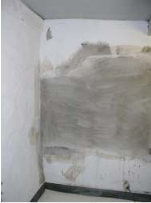
Serveringsrummets östra vägg. Skarvar tilljämnades och lerputsen fick torka. På lilla salens östra vägg ifylldes sprickor med nytt lerbruk, varefter de kalkavfärgades.
