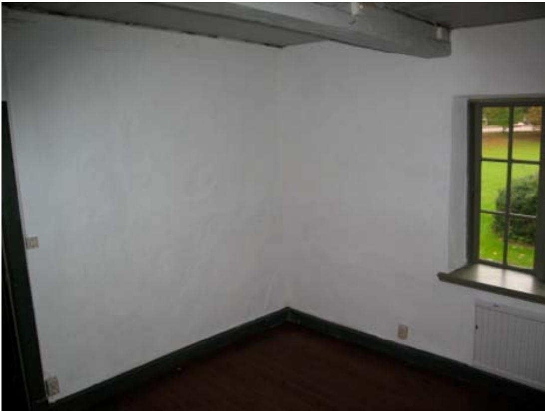
Serveringsrummets östra vägg efter det att väggytorna kring de lagade sprickbildningarna avfärgats med kalkfärg.
