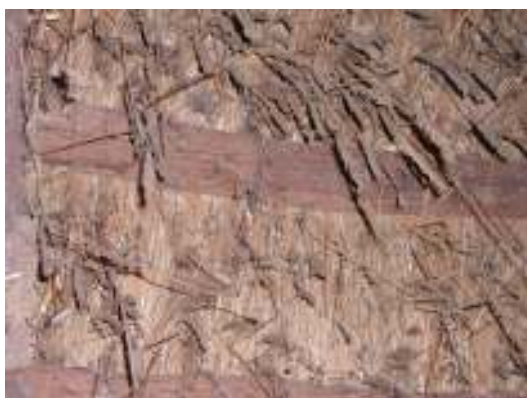
Sydöstra gavelstiet med gammal halmtäckning bundet med vidjor, vilket ligger under befintlig vasstäckning
