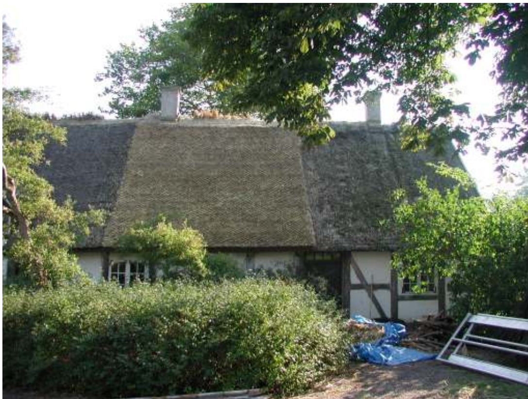
Sydvästra stiet efter omläggning, ryggingen återstår ännu. Tv sti som omlades 2002. Th gavelsti med vasstäckning som kommer att läggas om till halm 2007.
