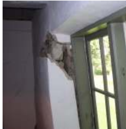
Serveringsrummets östra vägg. Kraftig sprickbildning, det inre facket av lertegel är på väg att släppa från det yttre.. Foto: författaren
