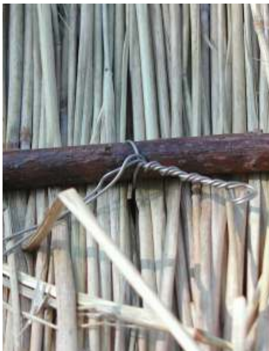
Sydöstra stiet. Ståltråd binds mellan läkt av gran och raft av pil
